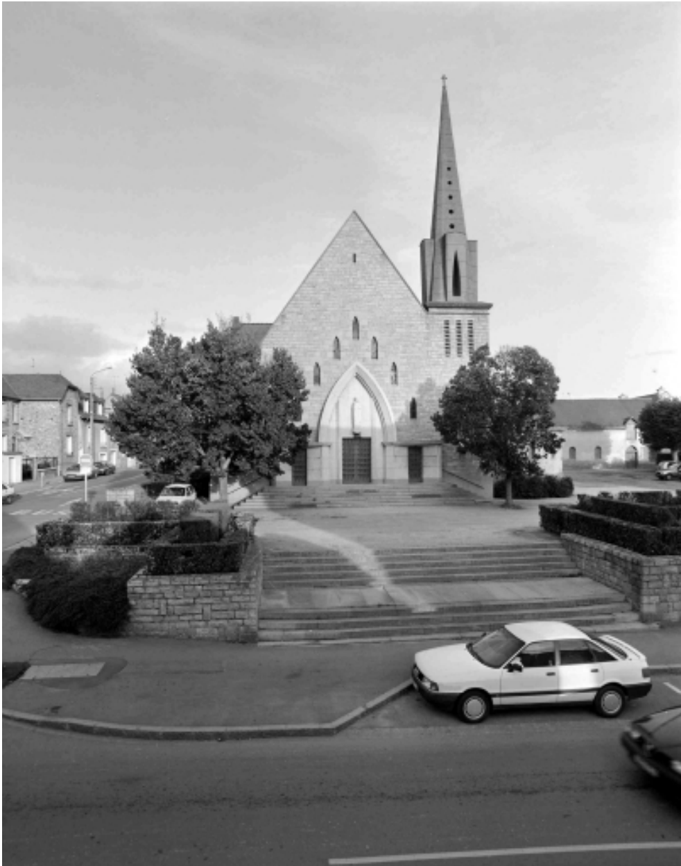
Vue de situation, depuis la rue de Saint-Malo, à l'ouest
