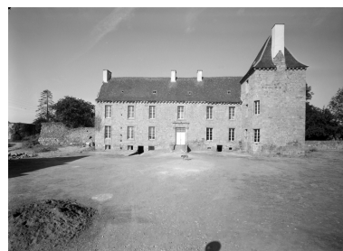
Façade est Phot. Guy Artur IVR53_19742200682V
