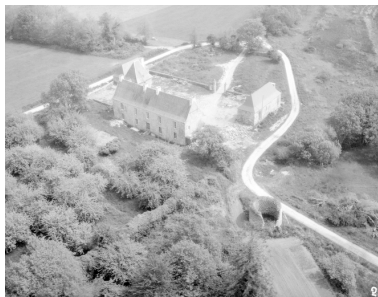
Vue aérienne : vue générale nord-ouest Phot. G.A.L.A.T. IVR53_19772200108P
