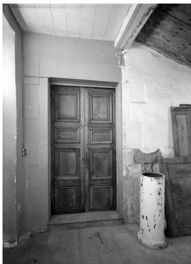
Porte du rez-de-chaussée Phot. Guy Artur IVR53_19742200687V
