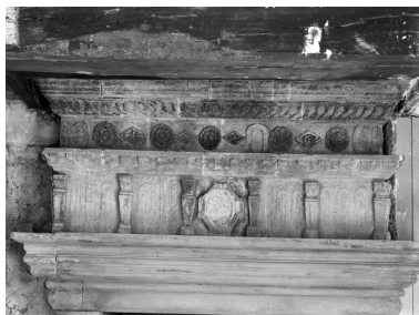
Détail du haut de la cheminée Phot. Guy Artur IVR53_19742200696V
