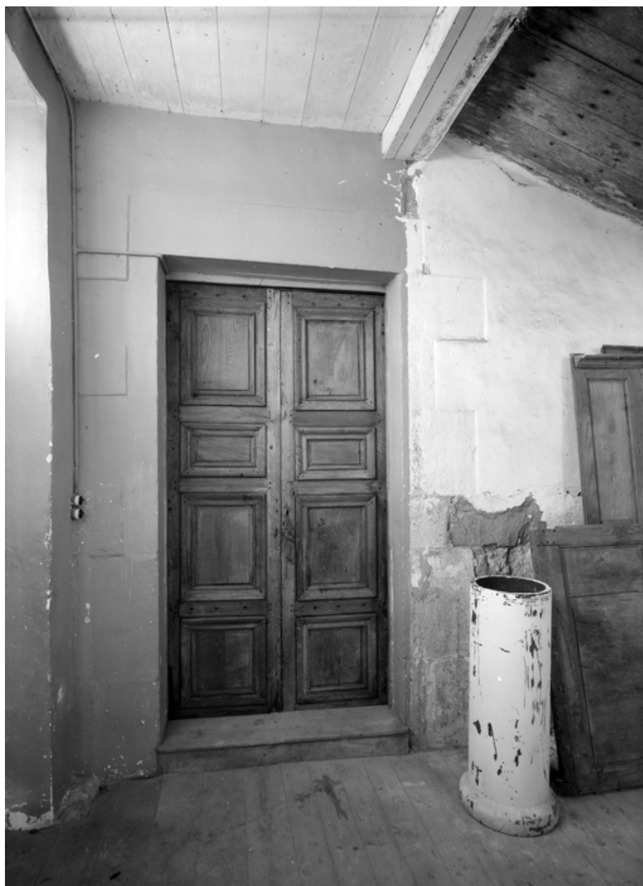
Porte du rez-de-chaussée
