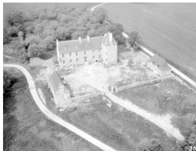
Vue aérienne : vue générale sud Phot. G.A.L.A.T. IVR53_19772200107P
