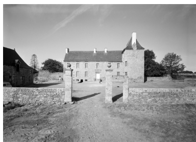
Arrivée à l'est Phot. Guy Artur IVR53_19742200680V
