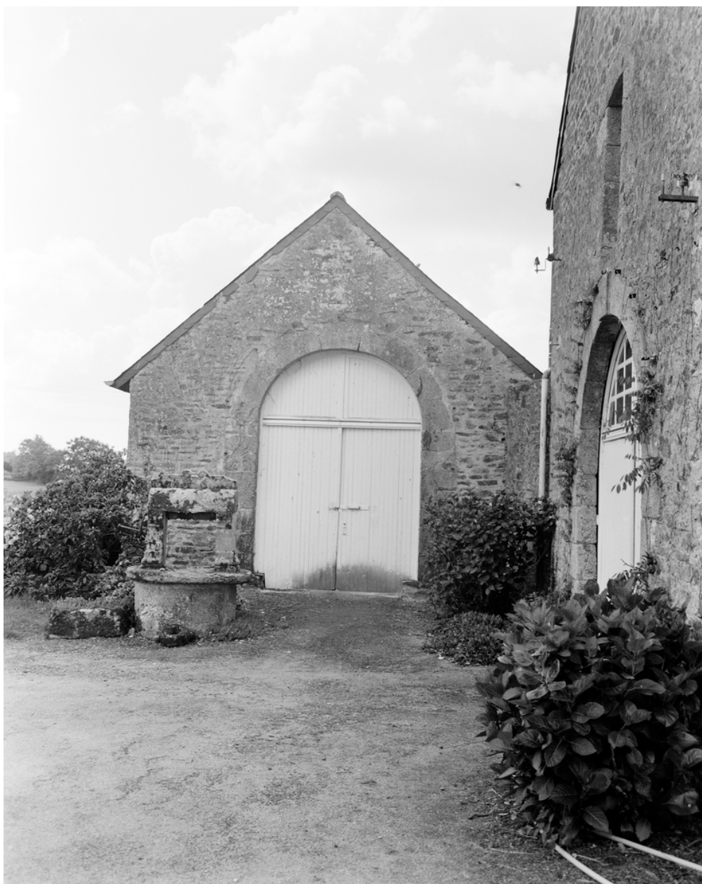
Grange 1, pignon nord.
