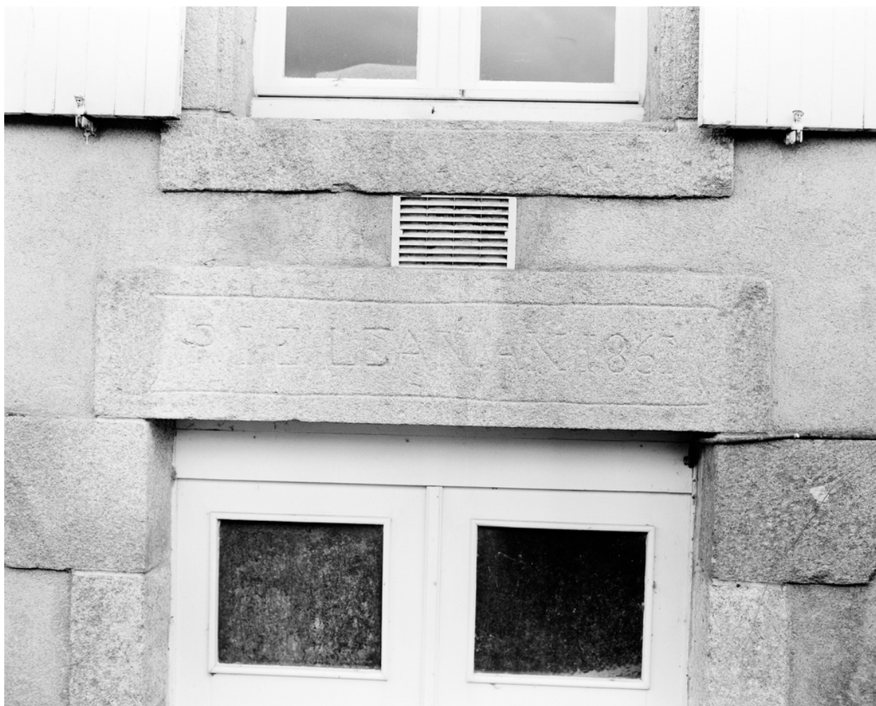
Logis, détail du linteau de la porte nord, daté 1861.
