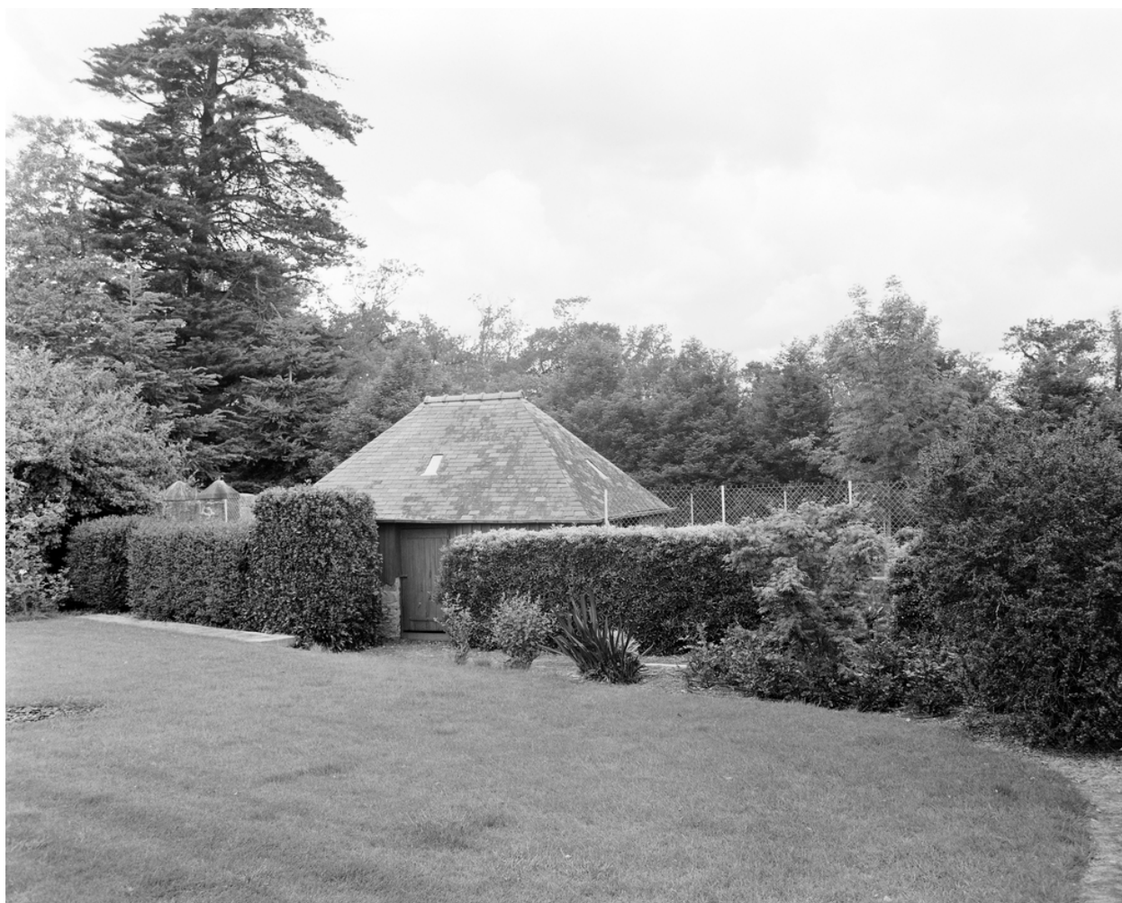
Chenil, vue générale.
