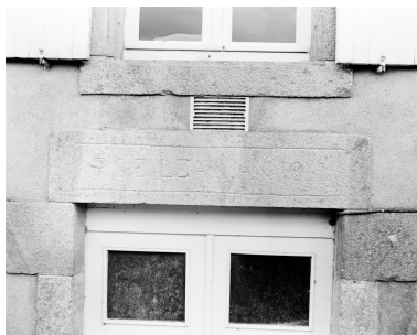
Logis, détail du linteau de la porte nord, daté 1861. Phot. Bernard Bègne IVR53_19975600628X
