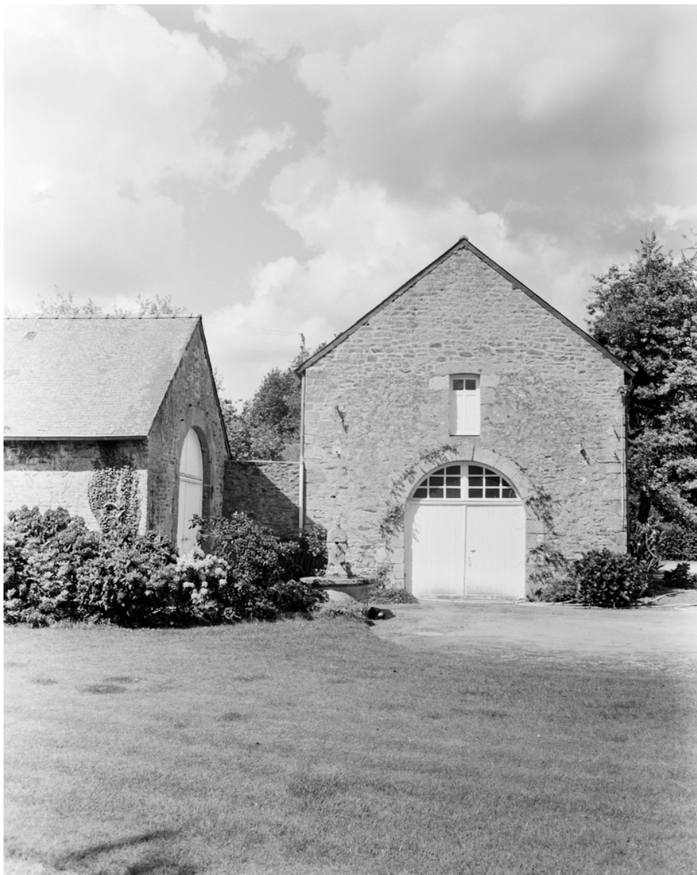
Grange 2, pignon est.
