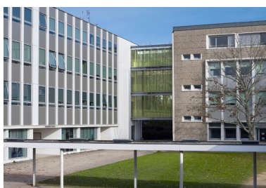
Jonction entre le nouvel internat P3, à gauche, et le bâtiment scientifique.
