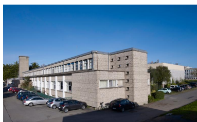
Service de restauration et chaufferie (R. Ouvré et G. Tourry architectes), vue d'ensemble prise du sud-ouest. Phot. Bernard Bègne IVR53_20195600518NUCA
