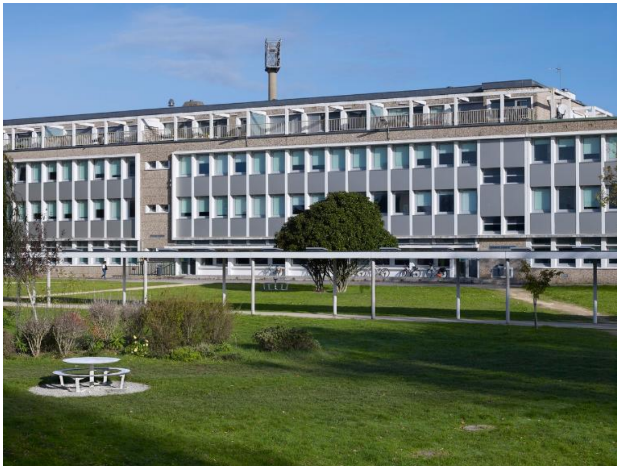
Bâtiment scientifique, façade sud-ouest (R. Ouvré et G. Tourry, architectes). Noter le toit terrasse avec un étage de logements de fonction, en retrait de façade.
