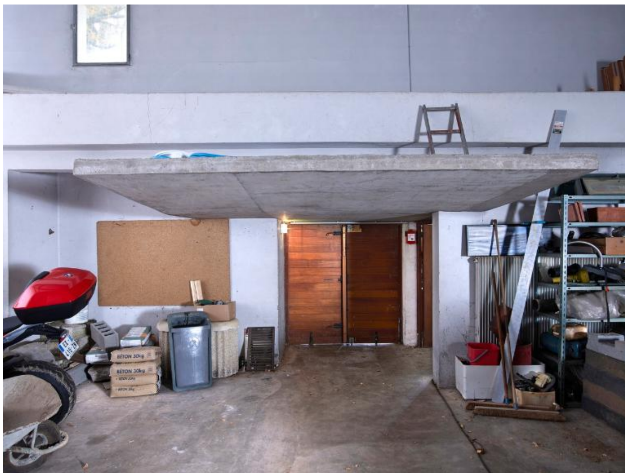
Chapelle, vue intérieure. René Ouvré architecte (1966-1967). La marquise en béton au dessus de l'entrée.
