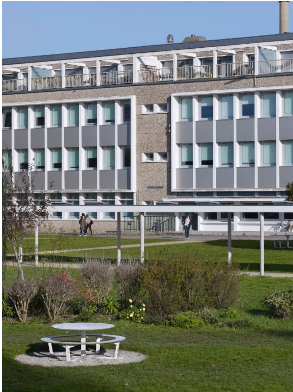
Bâtiment scientifique, façade sud-ouest (R. Ouvré et G. Tourry, architectes) : Détail centré sur la travée de l'escalier central. Noter l'isolation extérieure, le toit terrasse avec un étage de logements de fonction, en retrait de façade et le portique en béton.
