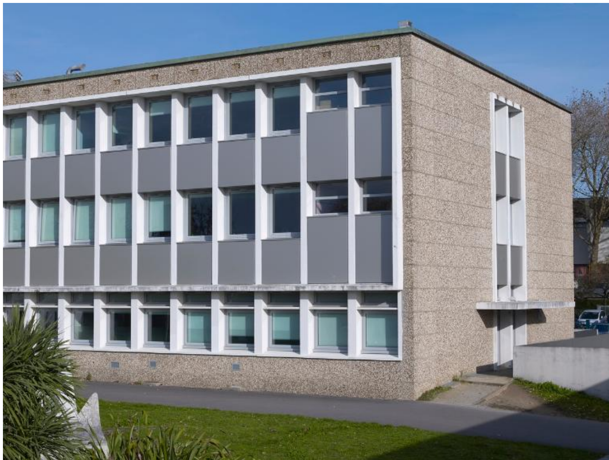
Bâtiment scientifique, angle sud. Noter le soin apporté au traitement de la travée et de l'entrée dans le pignon.
