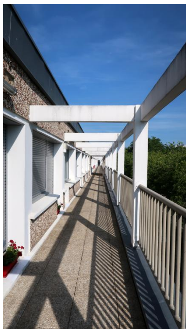
Bâtiment scientifique (R. Ouvré, architecte) : portique sur la coursive de desserte des appartements de fonction.
