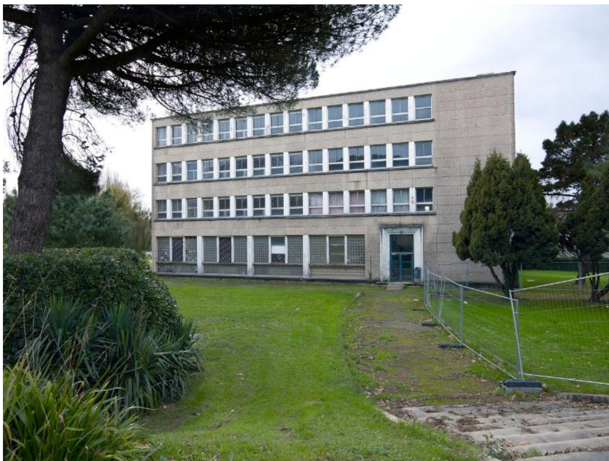
Internat garçons n°1, façade nord-est. Au rez-de-chaussée, les verrière en pavés de verre de la salle de jeux tranquilles.
