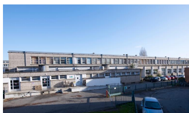
Service de restauration (R. Ouvré et G. Tourry architectes), vue d'ensemble de la façade sud-ouest. Phot. Bernard Bègne IVR53_20195600516NUCA
