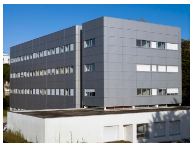
Internat garçons n°2, réhabilité (isolation extérieure, adjonction de l'aile au premier plan, Thierry Loison architecte).
