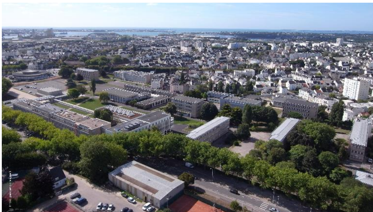
Vue aérienne du lycée
