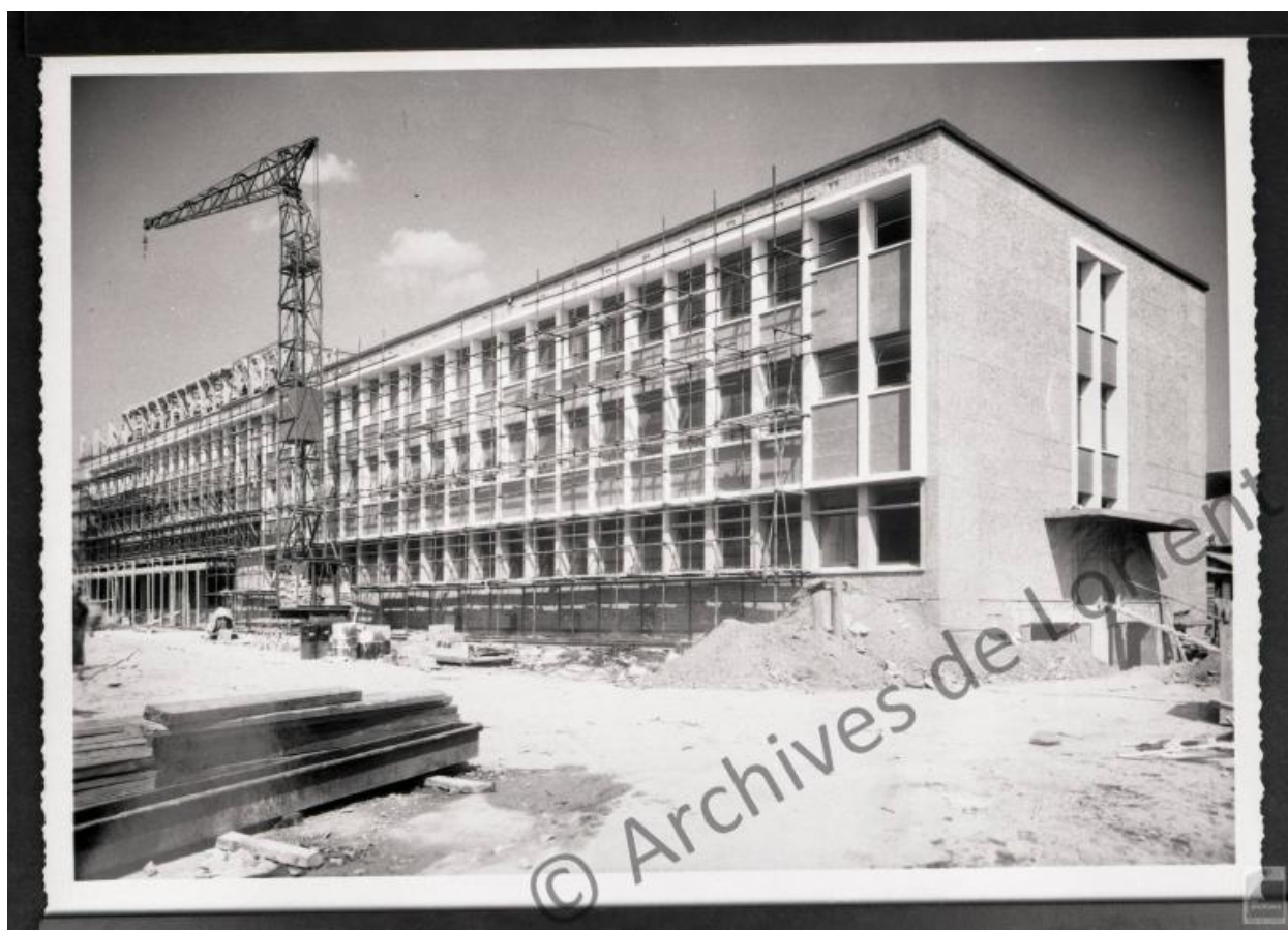
Construction du bâtiment scientifique (R. Ouvré, architecte). On remarque la construction du portique au dernier étage.
