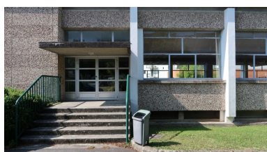
Réfectoire (R. Ouvré, architecte) : vue de détail d'une sortie. Phot. Thierry Goyet IVR53_20185606650NUCA
