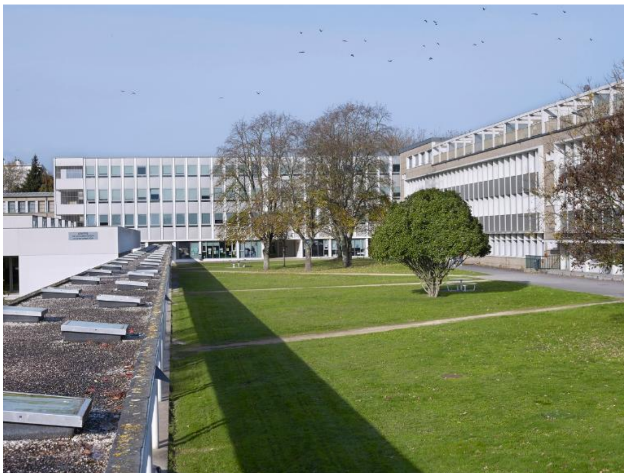
De gauche à droite, à l'arrière plan, externat P3, bâtiment scientifique. Au premier plan, toit de la galerie de circulation créée lors de la restructuration post-2005.
