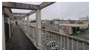
Vue d'ensemble prise depuis les logements de fonction situés au dernier étage de l'internat de filles pré-bac (au premier plan, le réfectoire, R. Ouvré architecte). Les appartements sont desservis par une coursive extérieure soulignée par un portique en béton armé.
