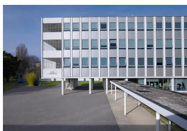
Nouvel externat P3 (S. Bertic et P. Debard, architectes, ca. 2005). Reprise contemporaine du vocabulaire architectural moderne
