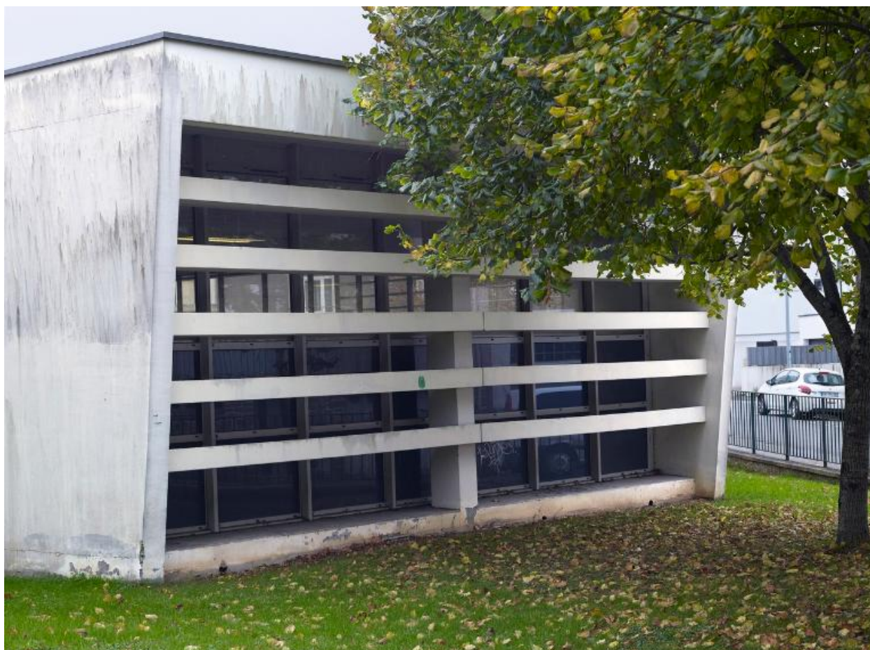
'Petit gymnase'. Détail de la façade nord-est de l'extension.
