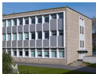
Bâtiment scientifique, angle sud. Noter le soin apporté au traitement de la travée et de l'entrée dans le pignon.
