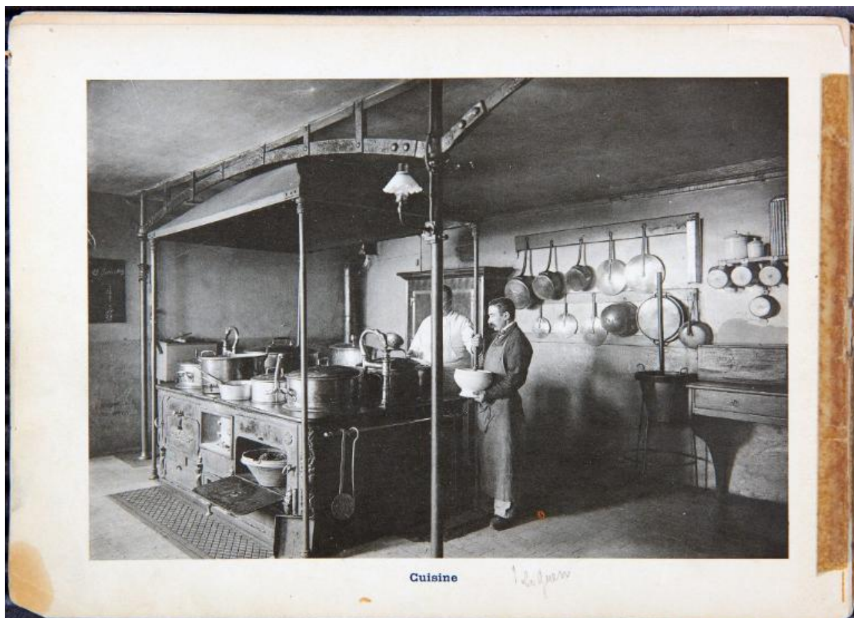
Photo ancienne de la cuisine du futur lycée Dupuy-de-Lôme avec la batterie de cuisine en cuivre et le grand four en fonte dans les années 1908-1909
