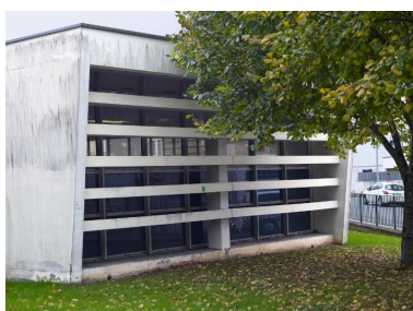
'Petit gymnase'. Détail de la façade nord-est de l'extension. Phot. Bernard Bègne IVR53_20195600565NUCA
