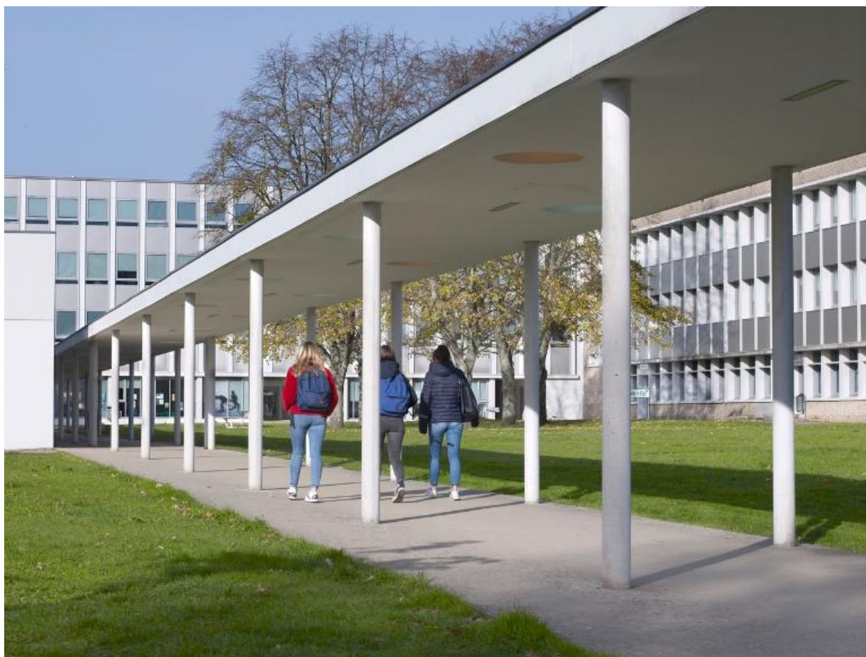
Galerie de circulation (ca. 2005).
