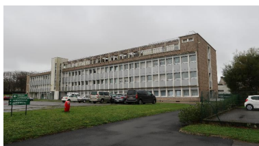
Internat et logements de fonction (R. Ouvré, architecte). Il a fait l'objet une réhabilitation "légère".
