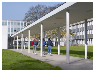
Galerie de circulation (ca. 2005).
