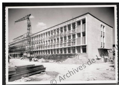
Construction du bâtiment scientifique (R. Ouvré, architecte). On remarque la construction du portique au dernier étage. IVR53_20185606659X
