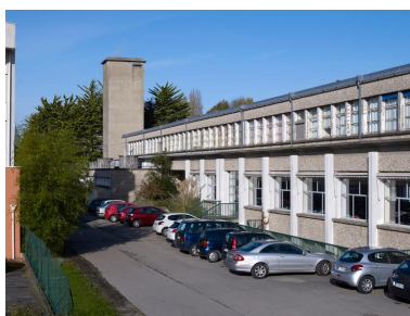
Service de restauration et chaufferie (R. Ouvré et G. Tourry architectes), vue d'ensemble prise du sud-ouest. Phot. Bernard Bègne IVR53_20195600520NUCA
