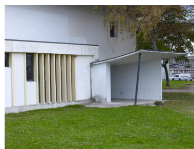
Détail de la façade et entrée. René Ouvré architecte (1966-1967). Phot. Bernard Bègne IVR53_20195600552NUCA
