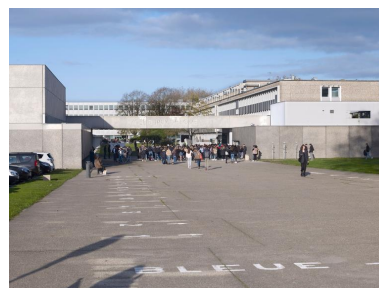
La nouvelle entrée du lycée (P. Debard, S. Bertic, architectes) : salle polyvalente, porche, bâtiment administratif.
