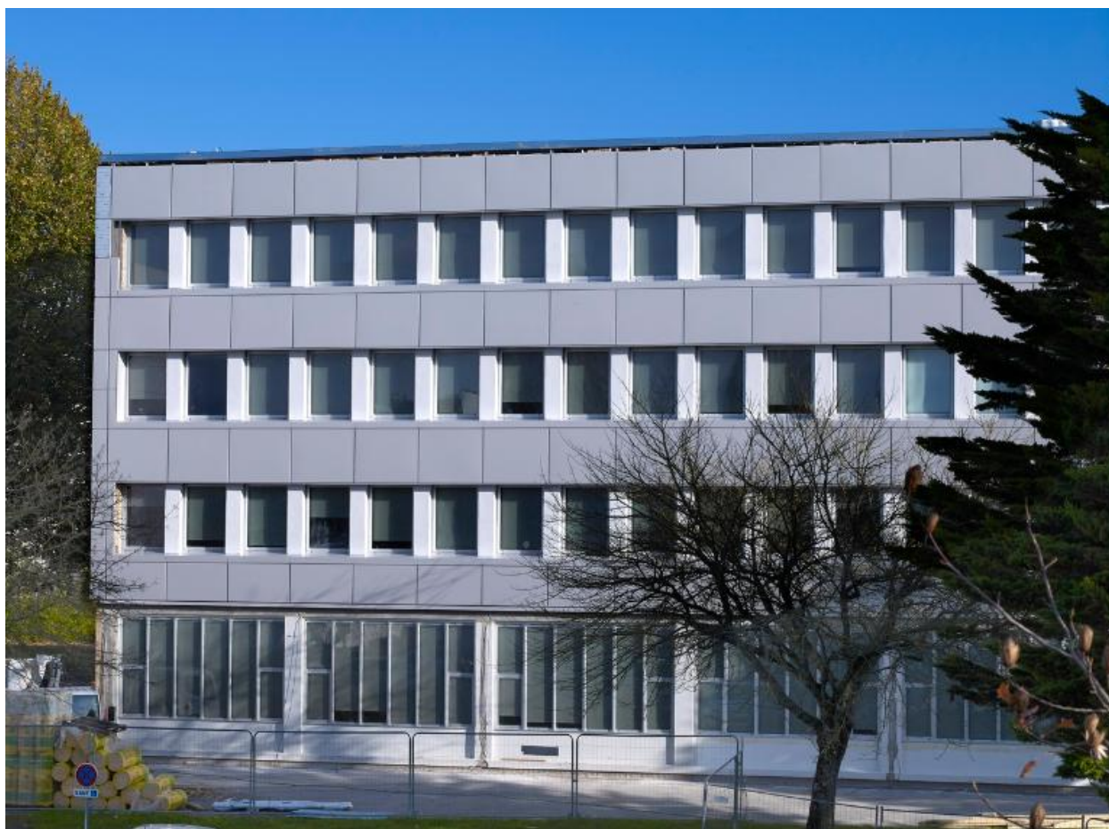
Internat garçons (bâtiment 4), transformé en "espace langues" en cours de réhabilitation thermique.
