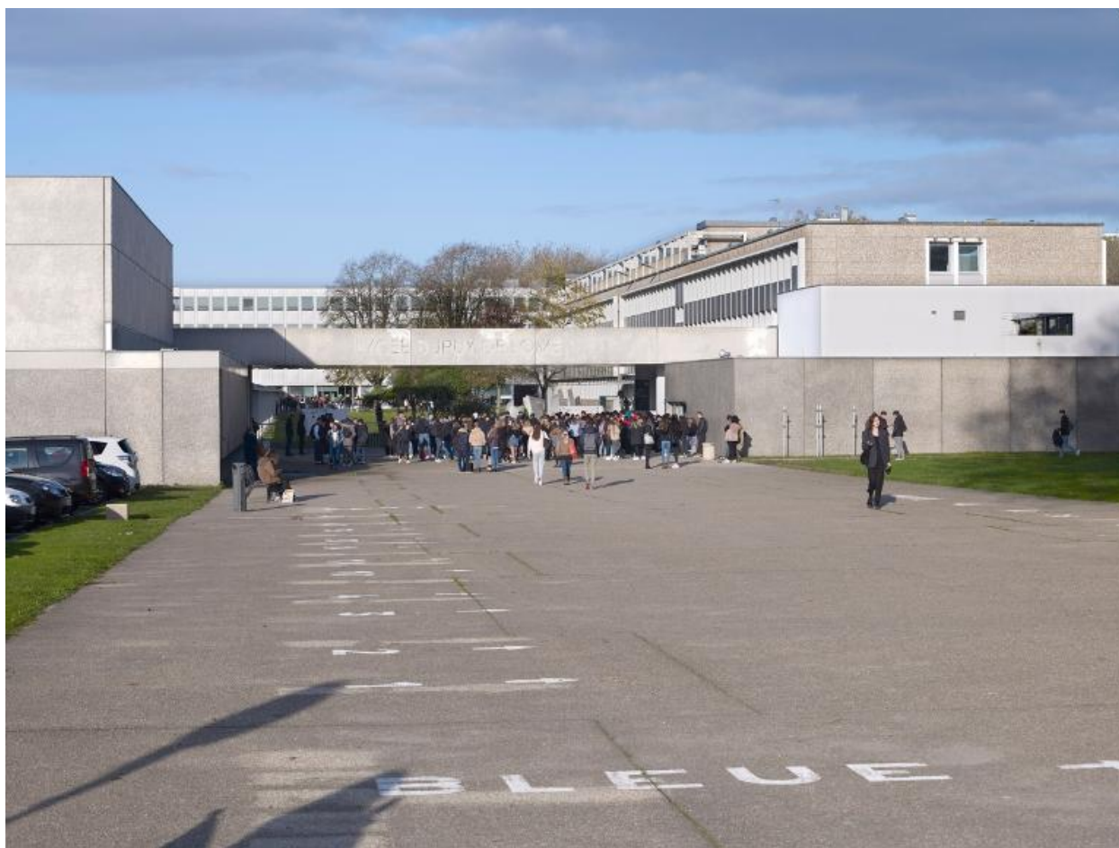
La nouvelle entrée du lycée (P. Debard, S. Bertic, architectes) : salle polyvalente, porche, bâtiment administratif.
