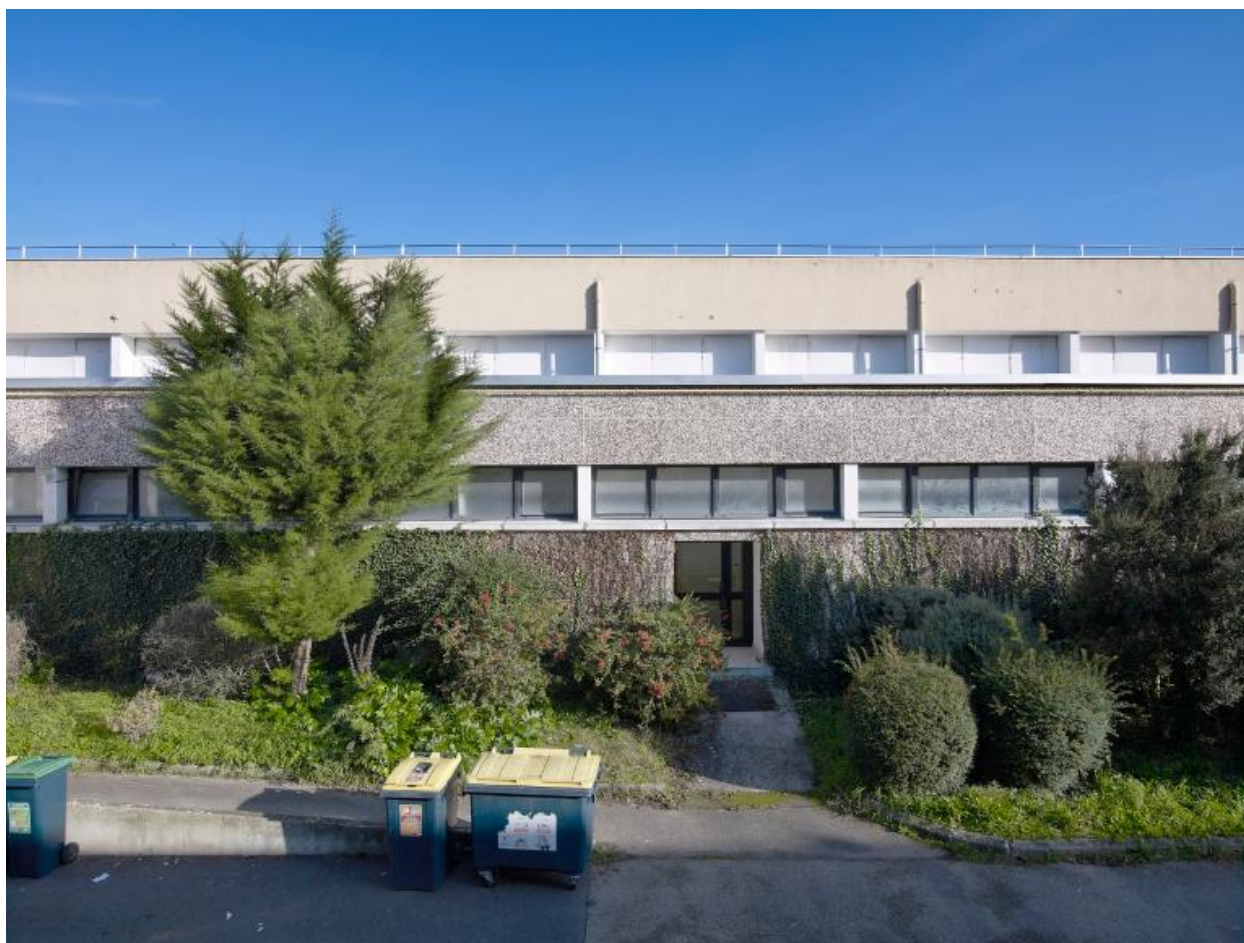
Restaurant scolaire : détail de la façade sud-ouest.
