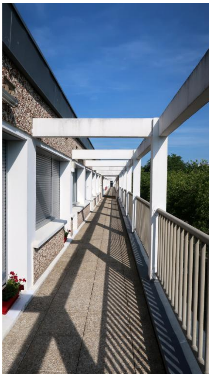
Bâtiment scientifique (R. Ouvré, architecte) : portique sur la coursive de desserte des appartements de fonction.
