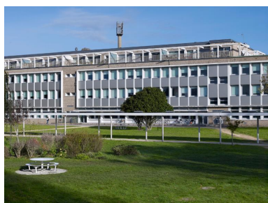
Bâtiment scientifique, façade sud-ouest (R. Ouvré et G. Tourry, architectes). Noter le toit terrasse avec un étage de logements de fonction, en retrait de façade.
