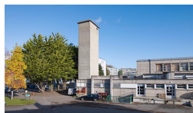
Cheminée de la chaufferie et service de restauration, détail de la façade sud-ouest. Phot. Bernard Bègne IVR53_20195600517NUCA
