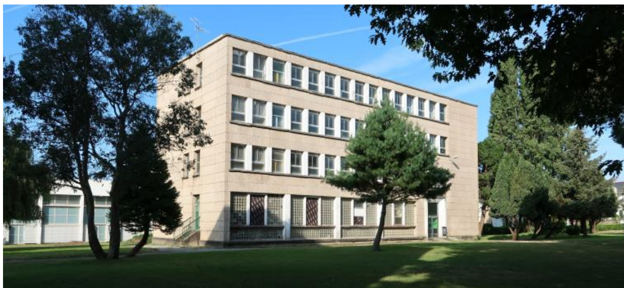
Un des premiers internats (Georges Tourry Architecte, ca. 1954), désaffecté.
