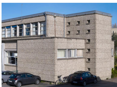
Service de restauration, détail angle sud. Phot. Bernard Bègne IVR53_20195600519NUCA
