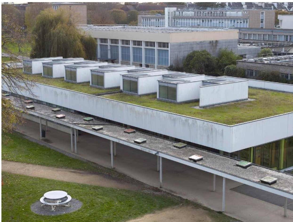
Toitures et baies de l'étage du CDI (P. Debard et S. Bertic, architectes, ca. 2005).
