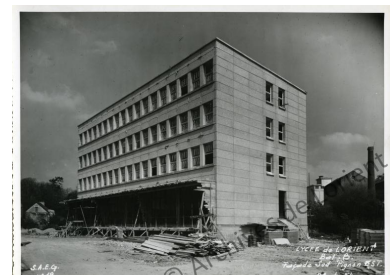
Internat en cours de construction (G. Tourry architecte). IVR53_20185606658X
