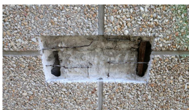
Système d'accrochage des panneaux de parement de façade, préfabriqués, en béton et gravier lavé. On aperçoit la structure (poteau en béton armé) et les parpaings en ciment utilisés pour le remplissage entre deux poteaux de la trame. Phot. Thierry Goyet IVR53_20185606657NUCA
