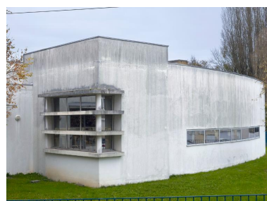
'Petit gymnase'. Détail de la façade sud de l'extension. Phot. Bernard Bègne IVR53_20195600566NUCA
