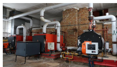
Chaufferie et souches de cheminées. Phot. Thierry Goyet IVR53_20185606654NUCA
