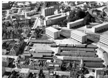
Vue aérienne du lycée Dupuy-de- Lôme, 15 juin 1959. Au premier plan, le lycée en « baraques », au deuxième plan, les trois premiers internats, les trois premiers externats construits et les plantations conservées. IVR53_20215605001NUC
