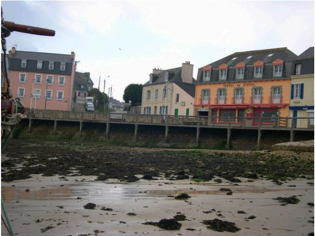
Vue du front portuaire du Styvel depuis la plage (partie sud)
