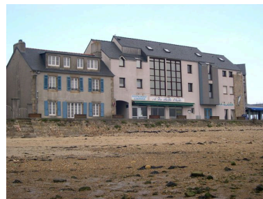
Vue du front portuaire du Styvel depuis la plage (partie nord) Phot. Guillaume Marie IVR53_20062908435NUCA
