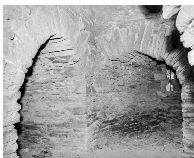
Fortification d'agglomération : rue Mystringue, vue intérieure de la tour (état en 1985) Phot. Norbert Lambart IVR53_19855600711X
