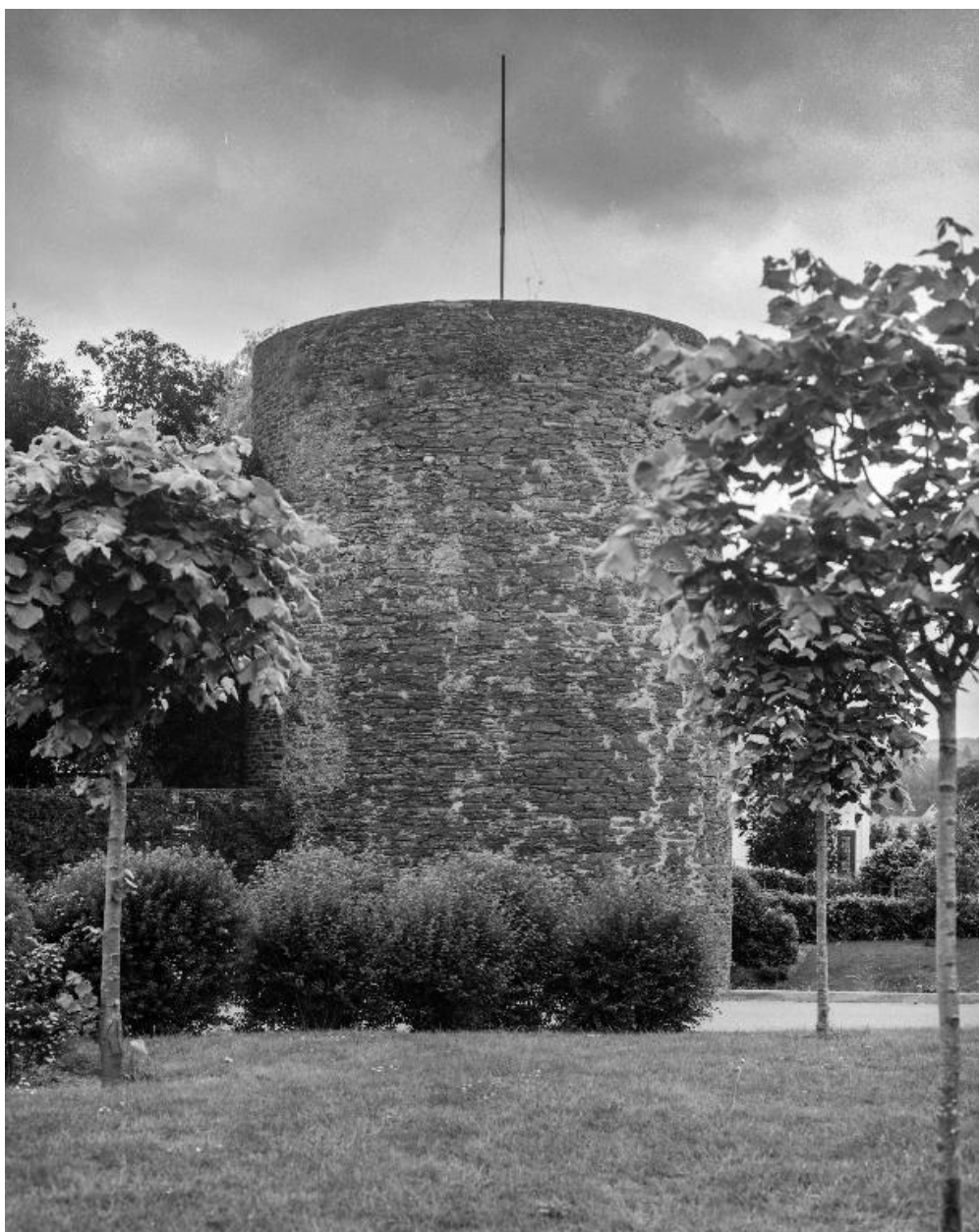
Fortification d'agglomération : rue Mystringue (état en 1985)
