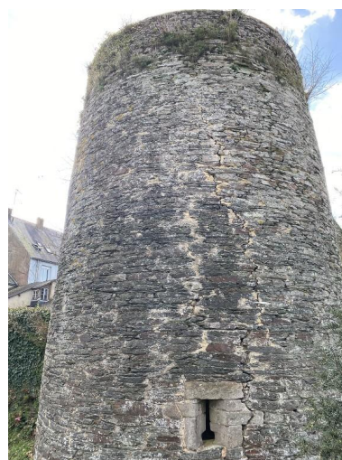
Vue est Phot. Baptiste Oligo IVR53_20265610175NUCA
