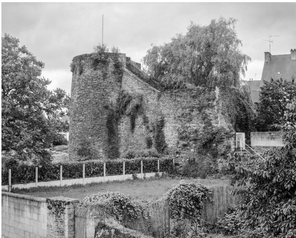
Fortification d'agglomération : rue Mystringue (état en 1985)
