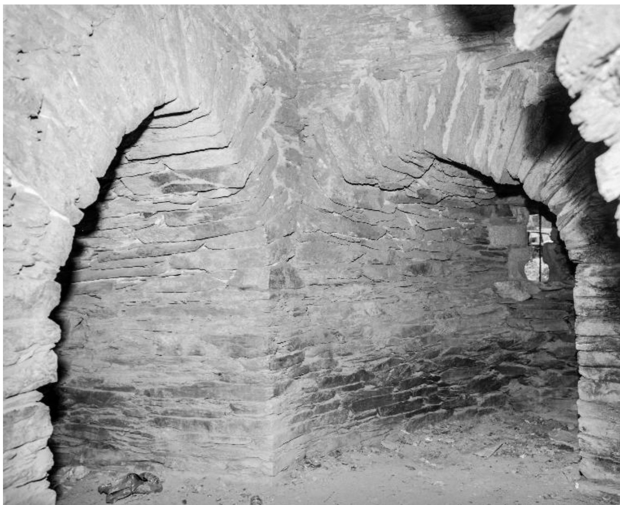
Fortification d'agglomération : rue Mystringue, vue intérieure de la tour (état en 1985)
