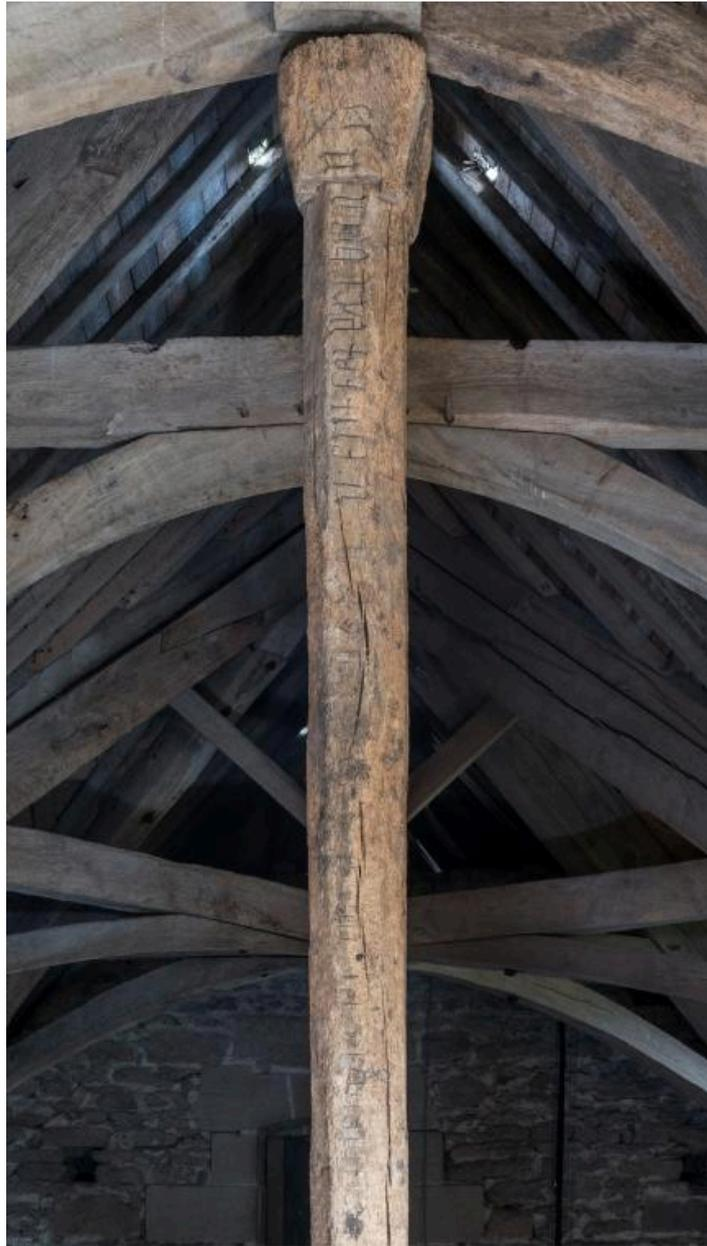
Vue de détail de la partie supérieure du poinçon de la ferme orientale de la charpente du choeur.
