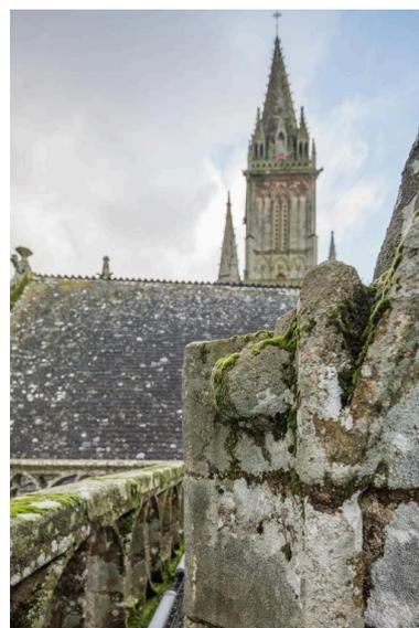
Vue de détail : vestige d'un écoulement d'une ancienne toiture et du pinnaclet qui le surmontait, à la jonction sud entre la travée droite du chevet et l'abside.
