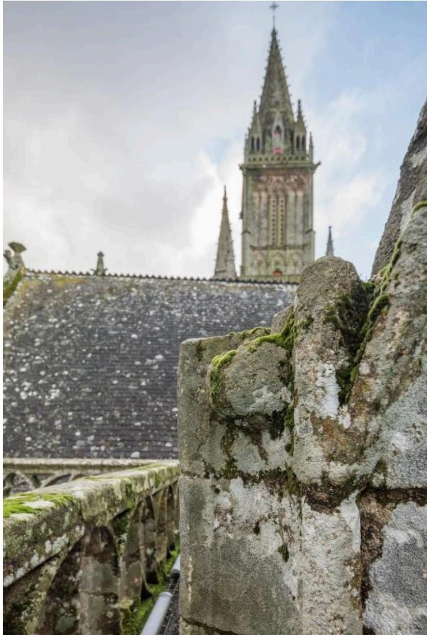
Vue de détail : vestige d'un écoulement d'une ancienne toiture et du pinacle qui le surmontait, à la jonction sud entre la travée droite du chevet et l'abside.
