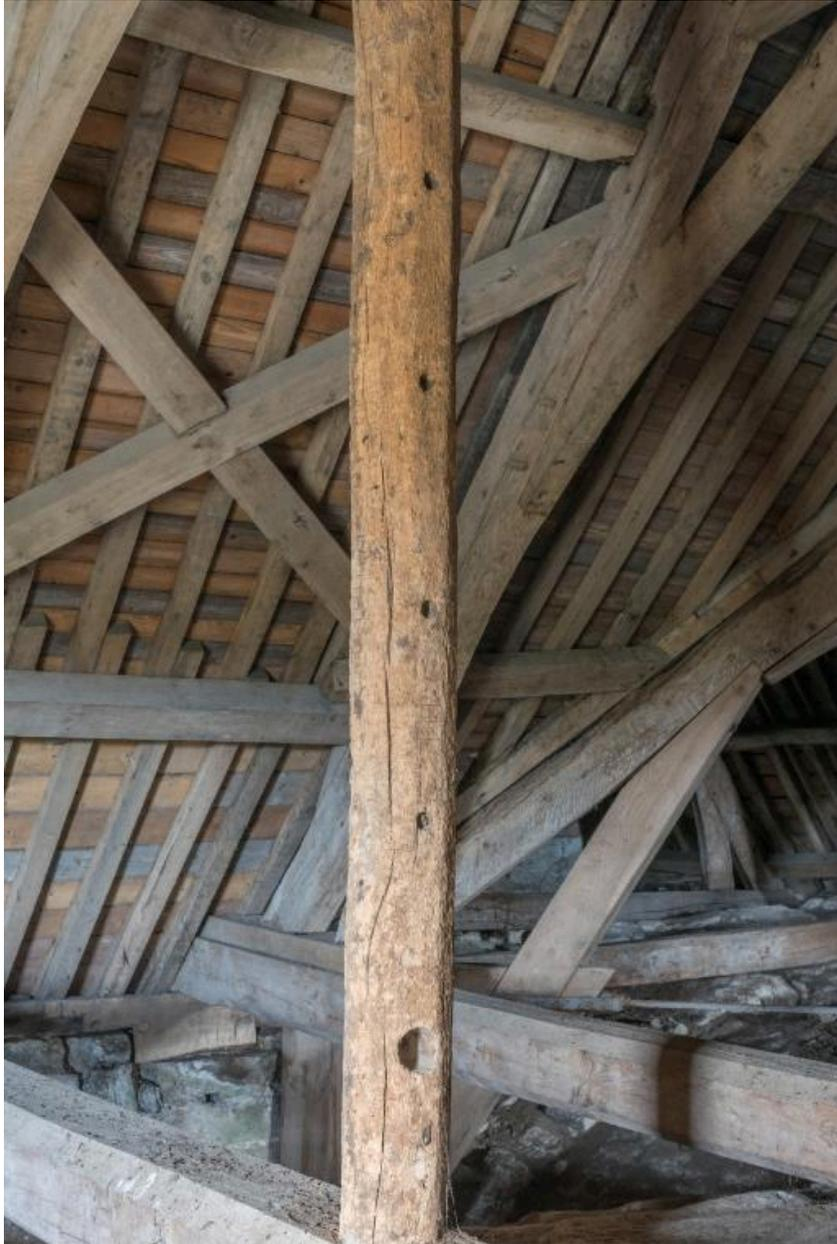
Vue oblique du poinçon de la ferme la plus à l'est dans la charpente du choeur.
