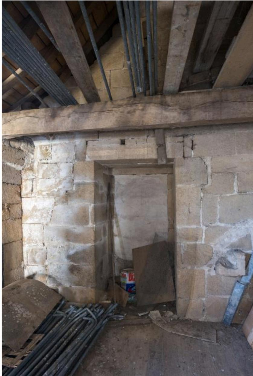
Vue de détail : baie obturée dans le mur est et à l'étage du bâtiment dit de la "prison" (probable ancienne salle du conseil de fabrique).
