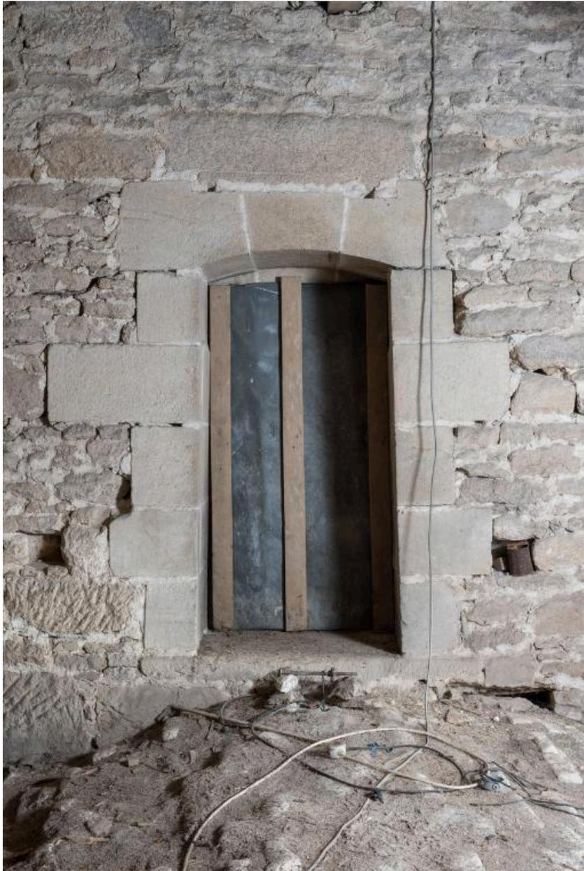
Vue de détail : ouverture pratiquée dans l'axe du mur de refend entre la nef et le transept, au niveau du comble.
