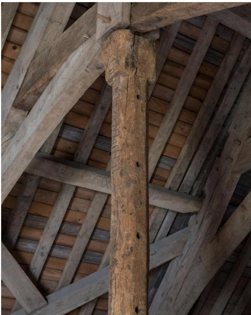
Vue oblique de la partie haute du poinçon de la ferme orientale de la charpente du chœur.
