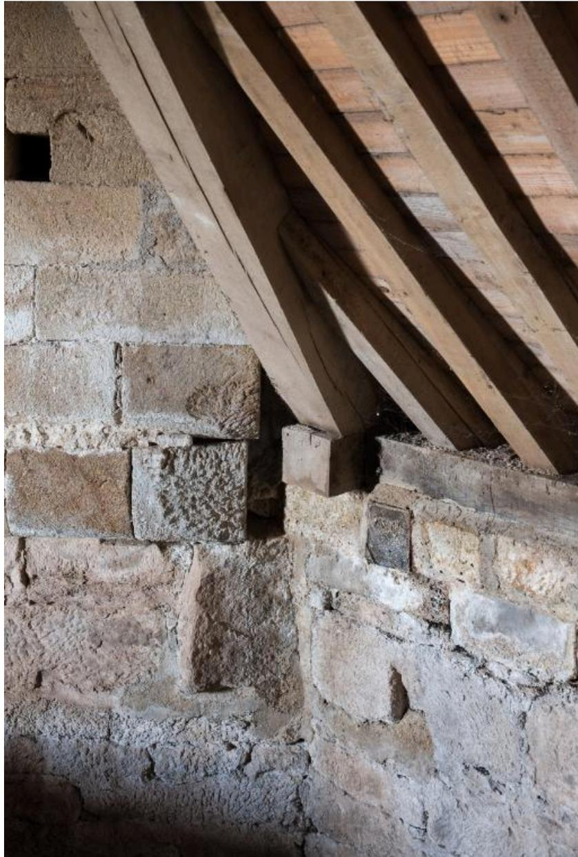
Vue de détail : jonction des maçonneries de l'abside à trois pans (à gauche) et du mur sud de la travée droite du choeur (à droite).
