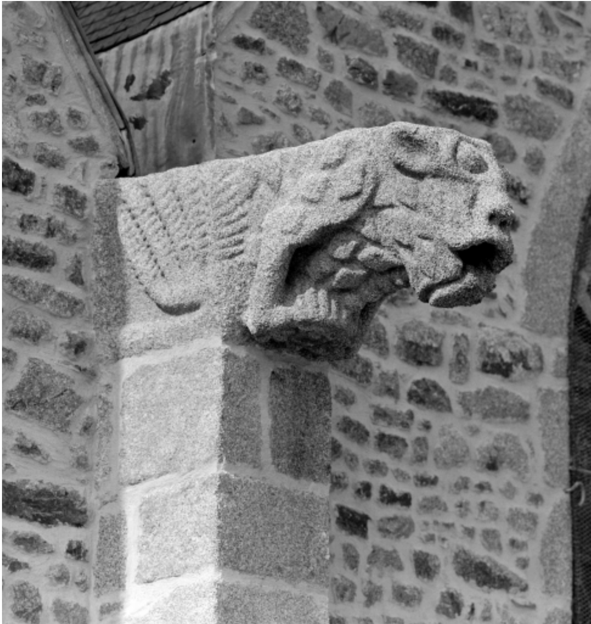
Elévation Nord, gargouille : détail de la face Est
