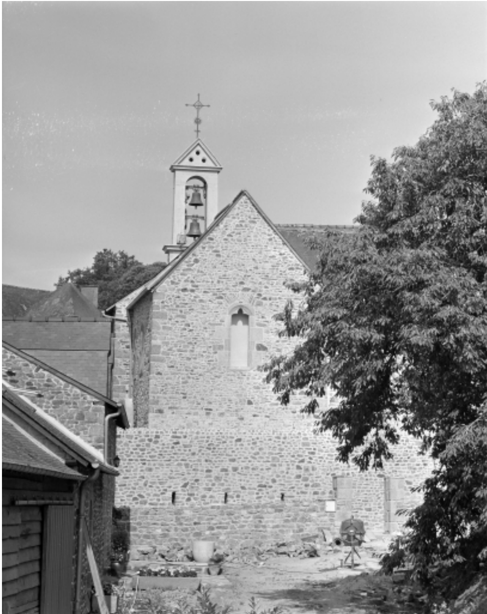
Elévation Est, pignon Est : vue générale
