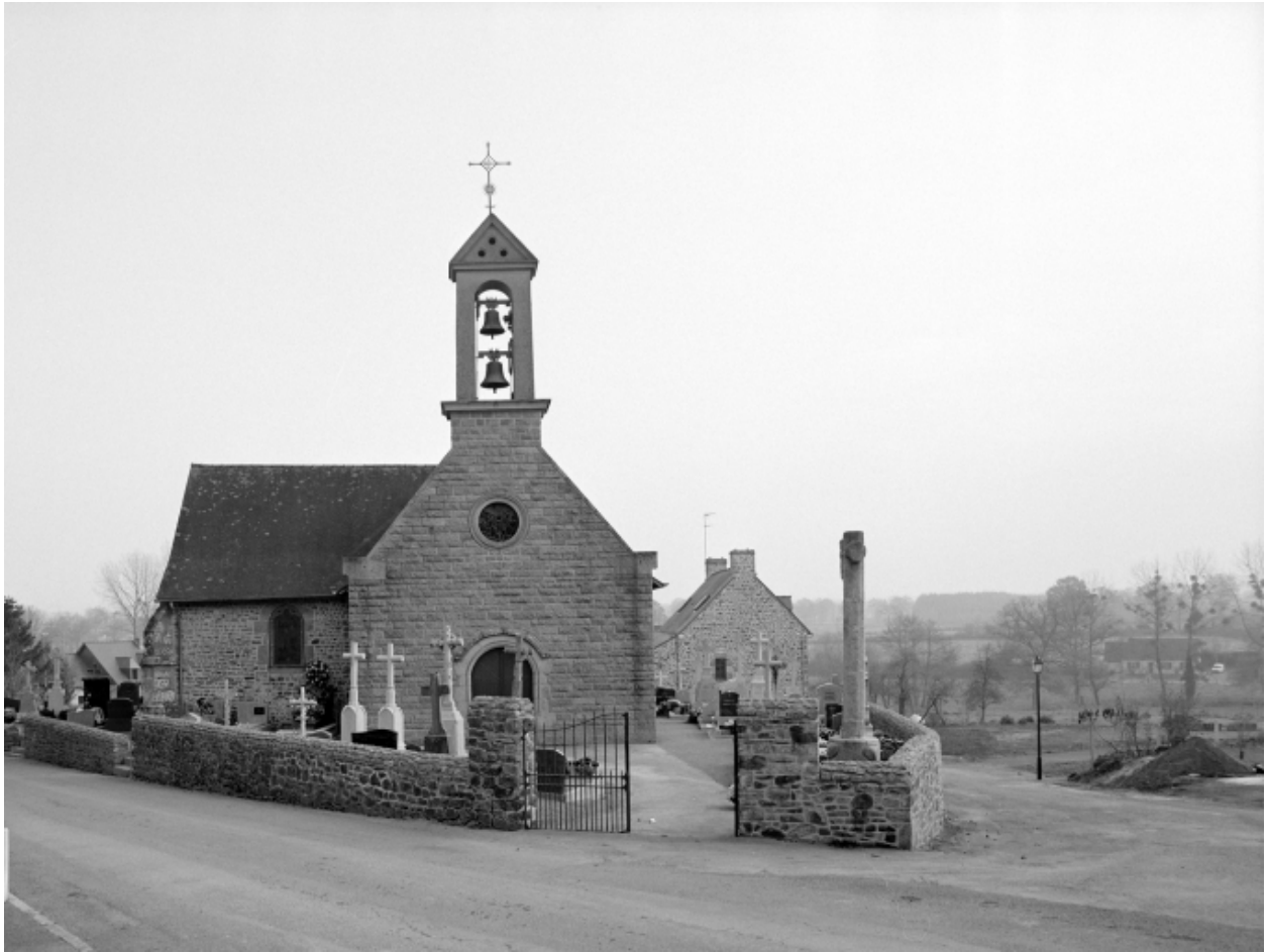
Elévation Ouest : vue générale
