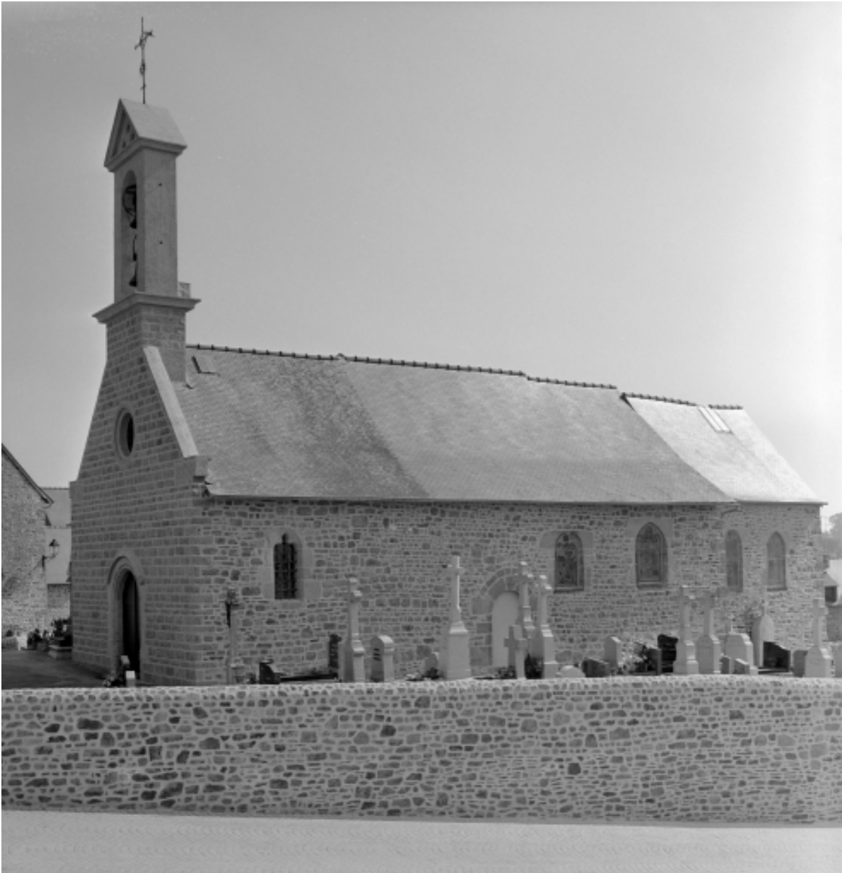
Elévation Sud-Ouest : vue générale
