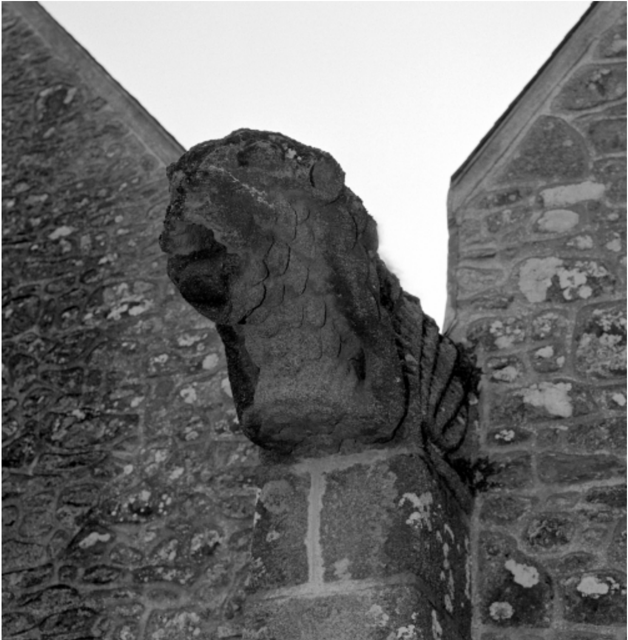
Elévation Nord, gargouille : détail de la face Ouest
