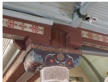
Détail du chapiteau en bois peint de motifs floraux Phot. Bernard Bègne IVR53_20133501972NUCA
