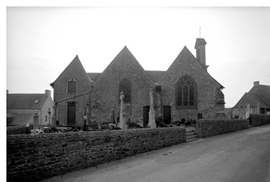
Elévation Nord : vue générale Phot. Guy Artur, Phot. Norbert Lambart IVR53_19933500630X
