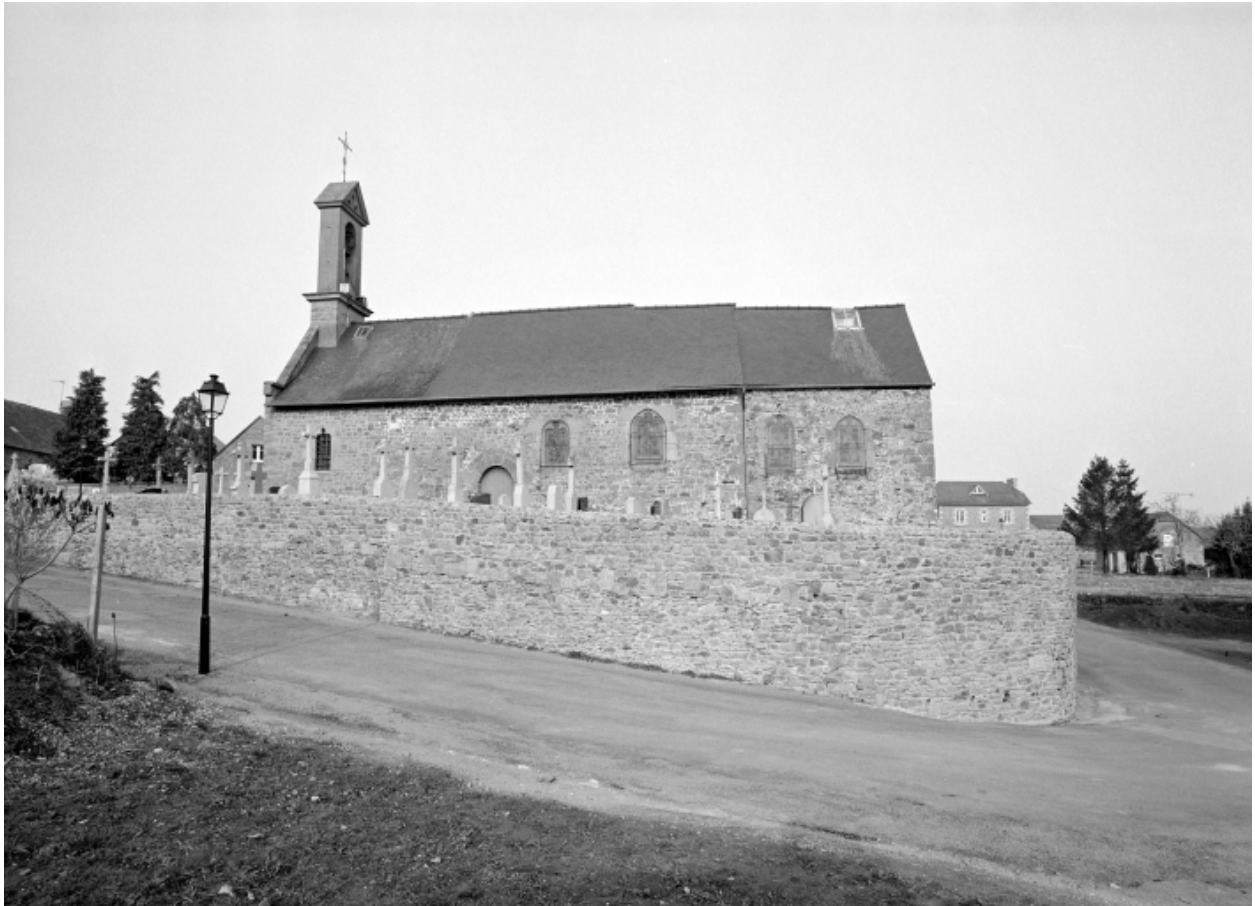
Elévation Sud : vue générale
