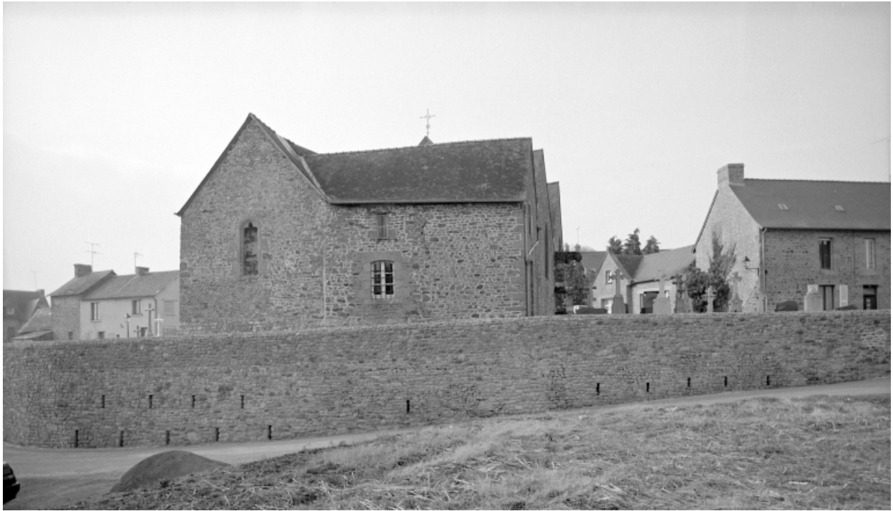
Elévation Est : vue générale
