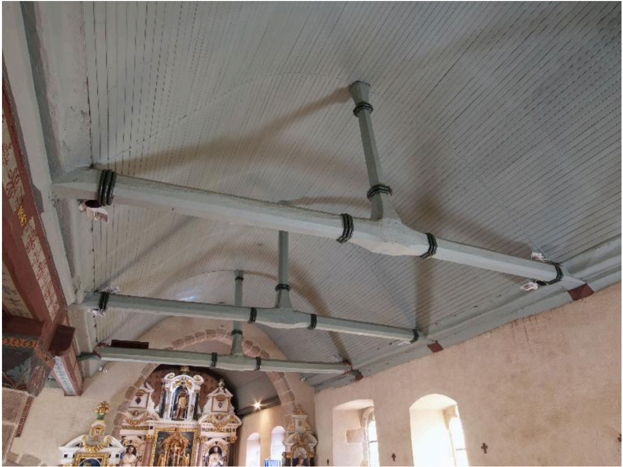
Intérieur : vue générale de la charpente de la nef
