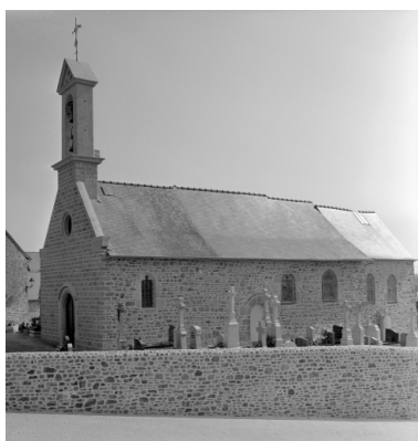
Elévation Sud-Ouest : vue générale Phot. Guy Artur, Phot. Norbert Lambart IVR53_19943501445X
