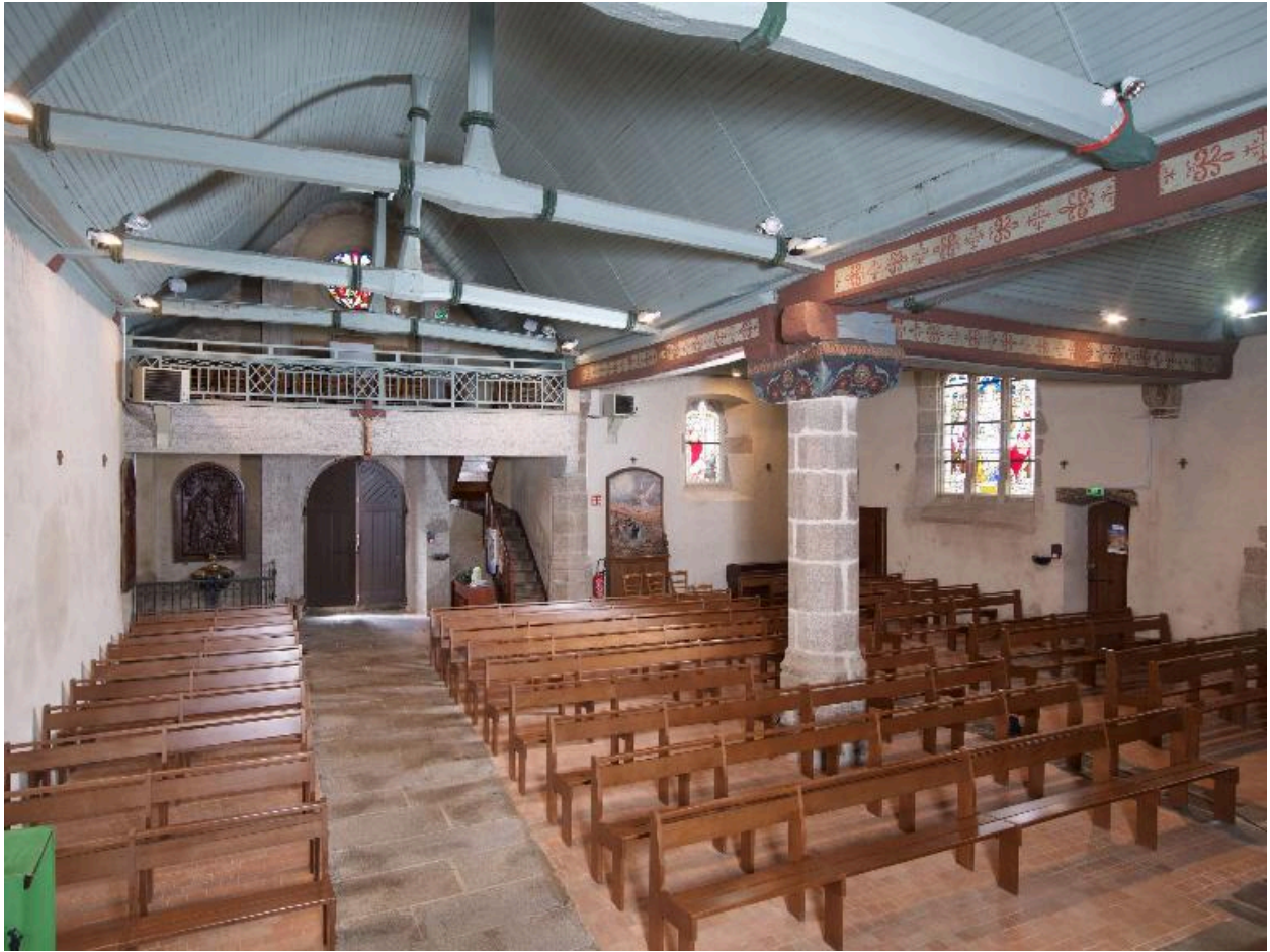
Vue générale de la nef
