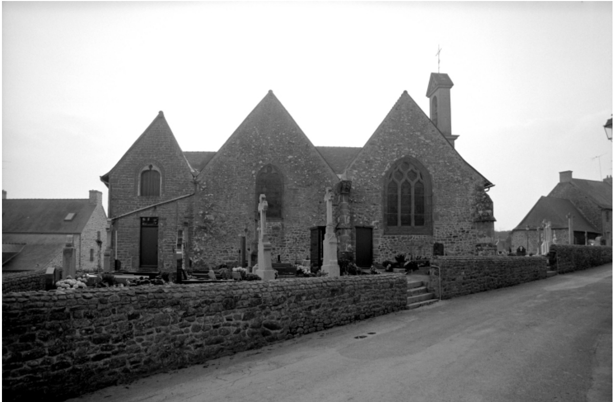
Elévation Nord : vue générale
