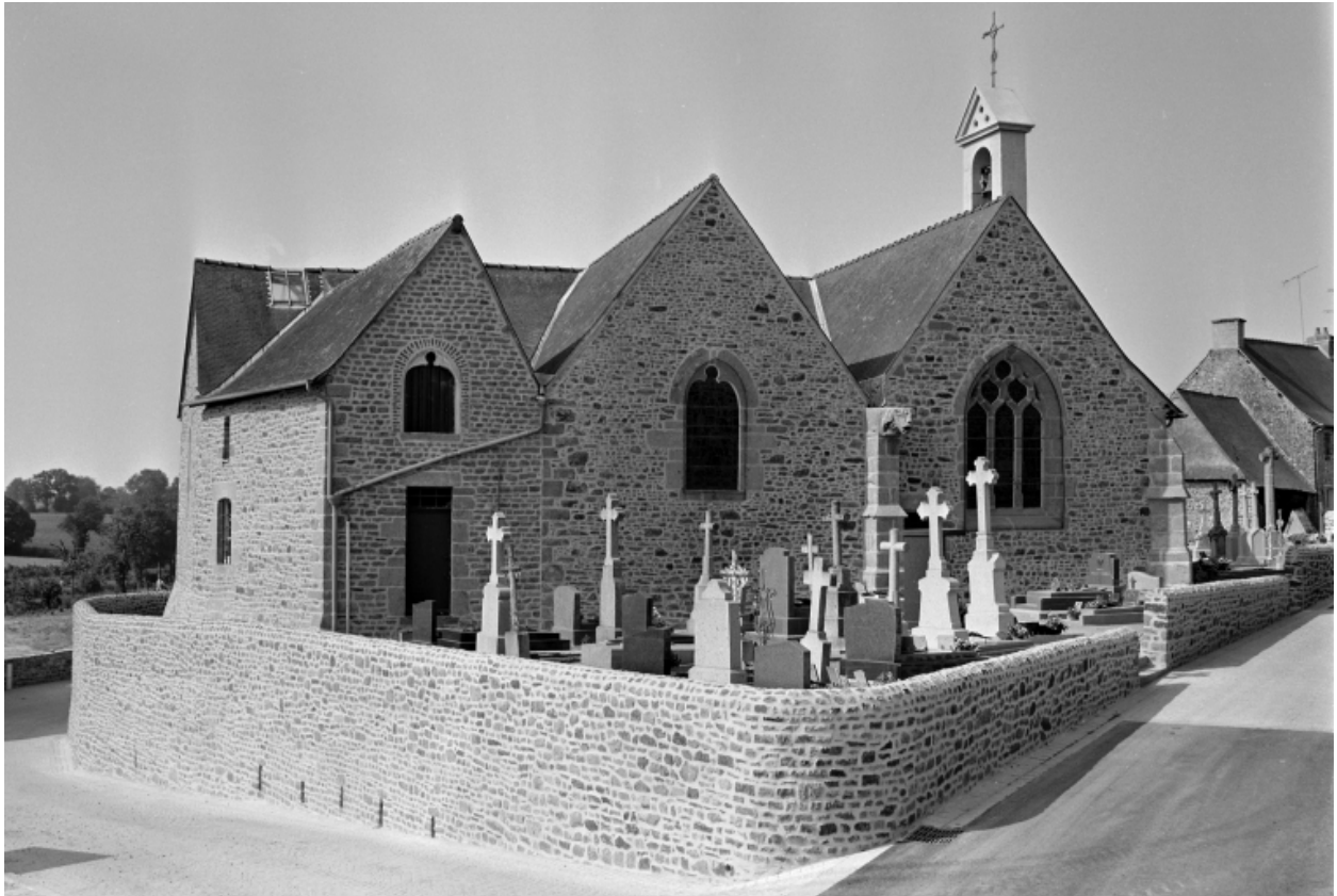
Elévation Nord-Est : vue générale
