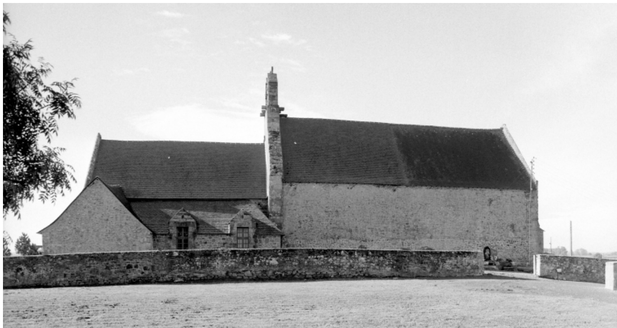
Elévation Nord : vue générale
