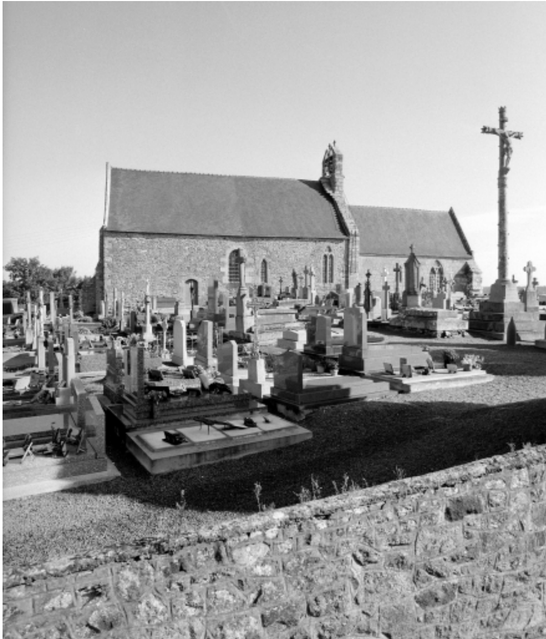
Elévation Sud : vue générale
