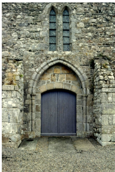
Elévation sud : détail fenêtrage. Phot. Isabelle Barbedor IVR53_19943502881ZA
