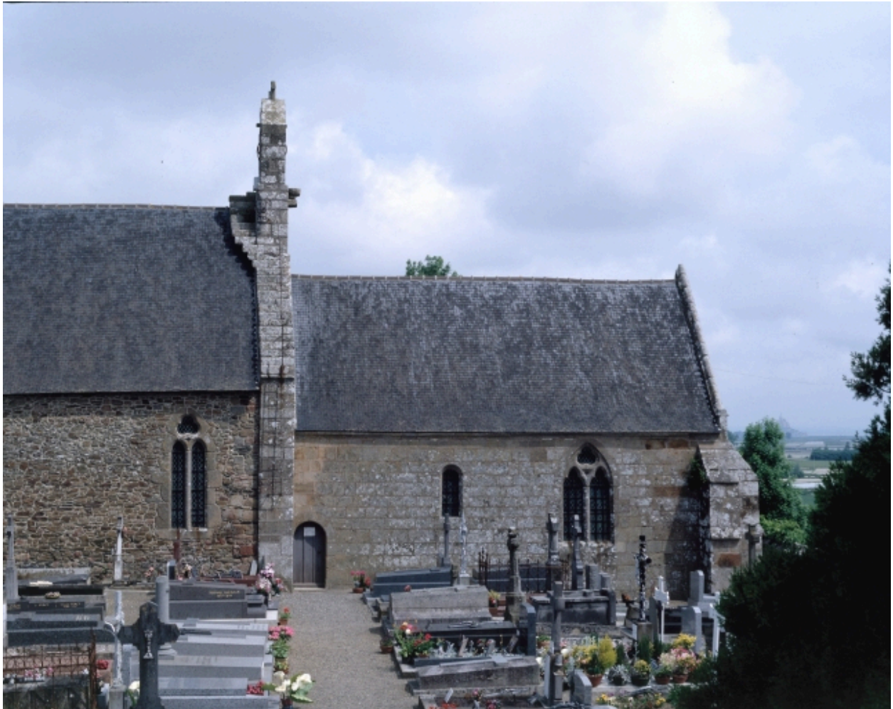
Elévation Sud : vue générale
