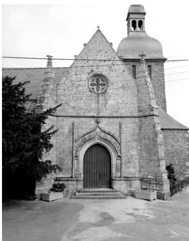
Façade ouest, détail du portail Phot. Guy Artur, Phot. Norbert Lambart IVR53_19943500811X
