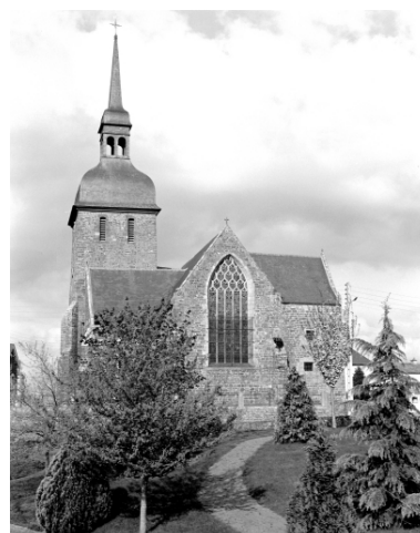
Vue générale est Phot. Guy Artur, Phot. Norbert Lambart IVR53_19943500836X
