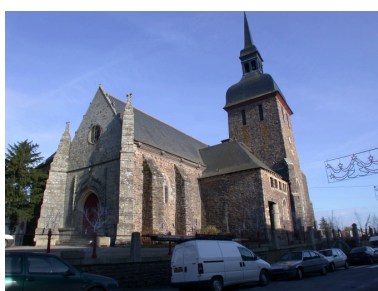
Façade sud Phot. Véronique Orain IVR53_20033515762NUCA
