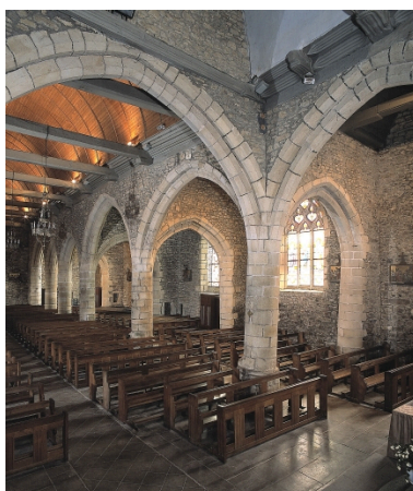
Vue intérieure, collatéral nord Phot. Bernard Bègne IVR53_20033502147XA
