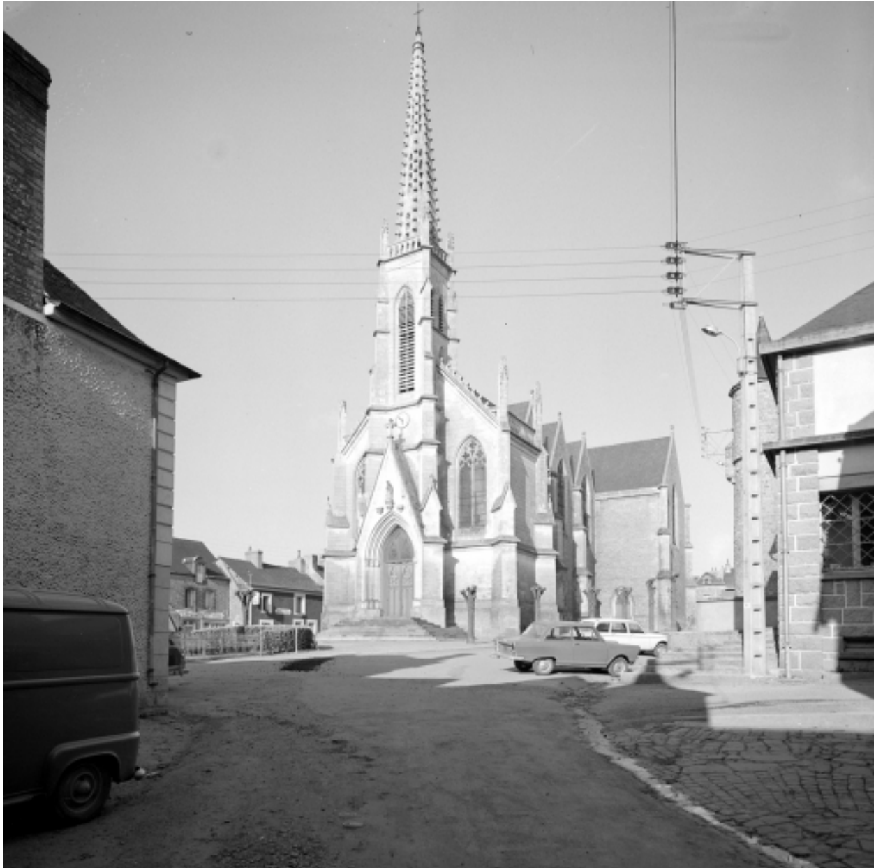
Elévation ouest : vue générale
