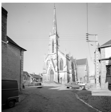
Elévation ouest : vue générale Phot. François Dagorn IVR53_19683500354V
