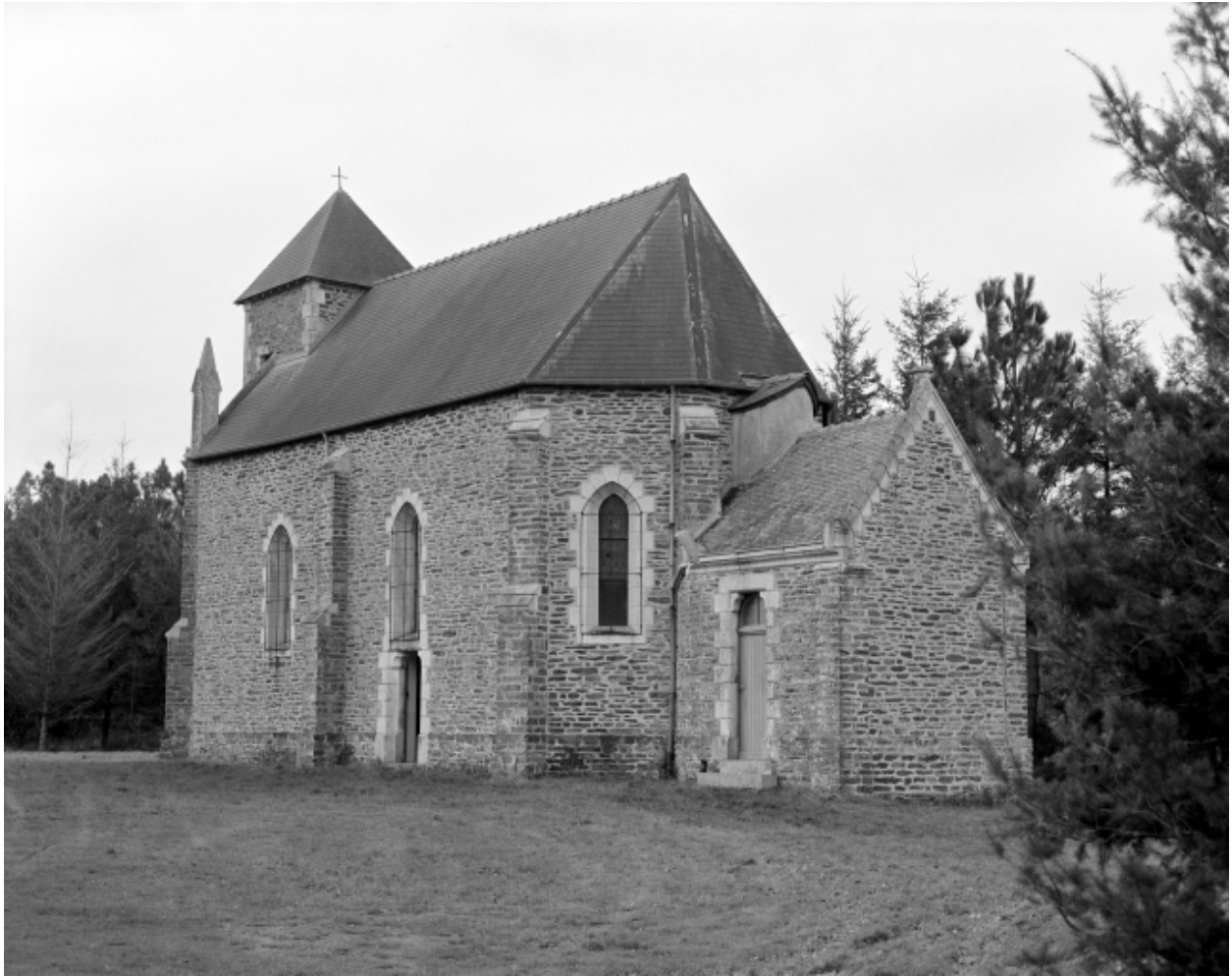
Elévation Sud-Est : vue générale
