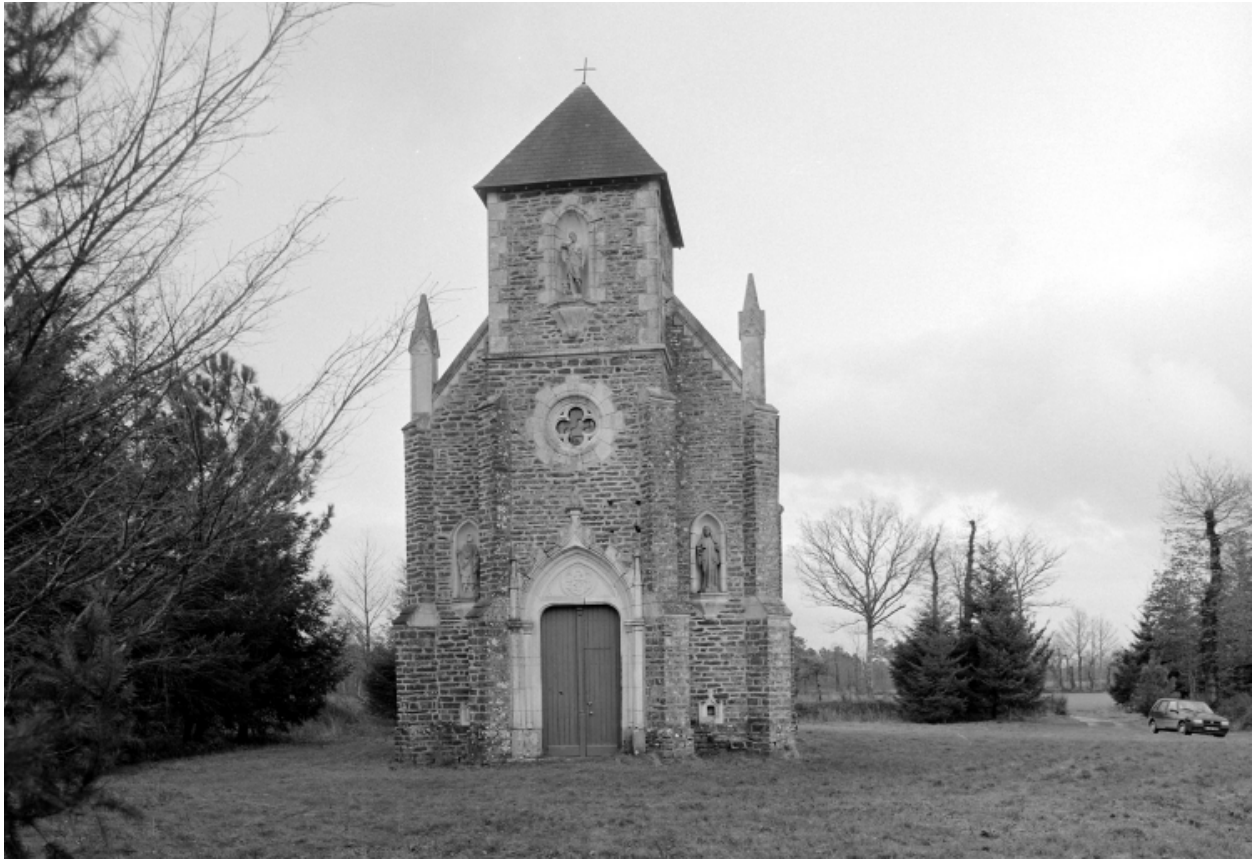
Elévation Ouest : vue générale
