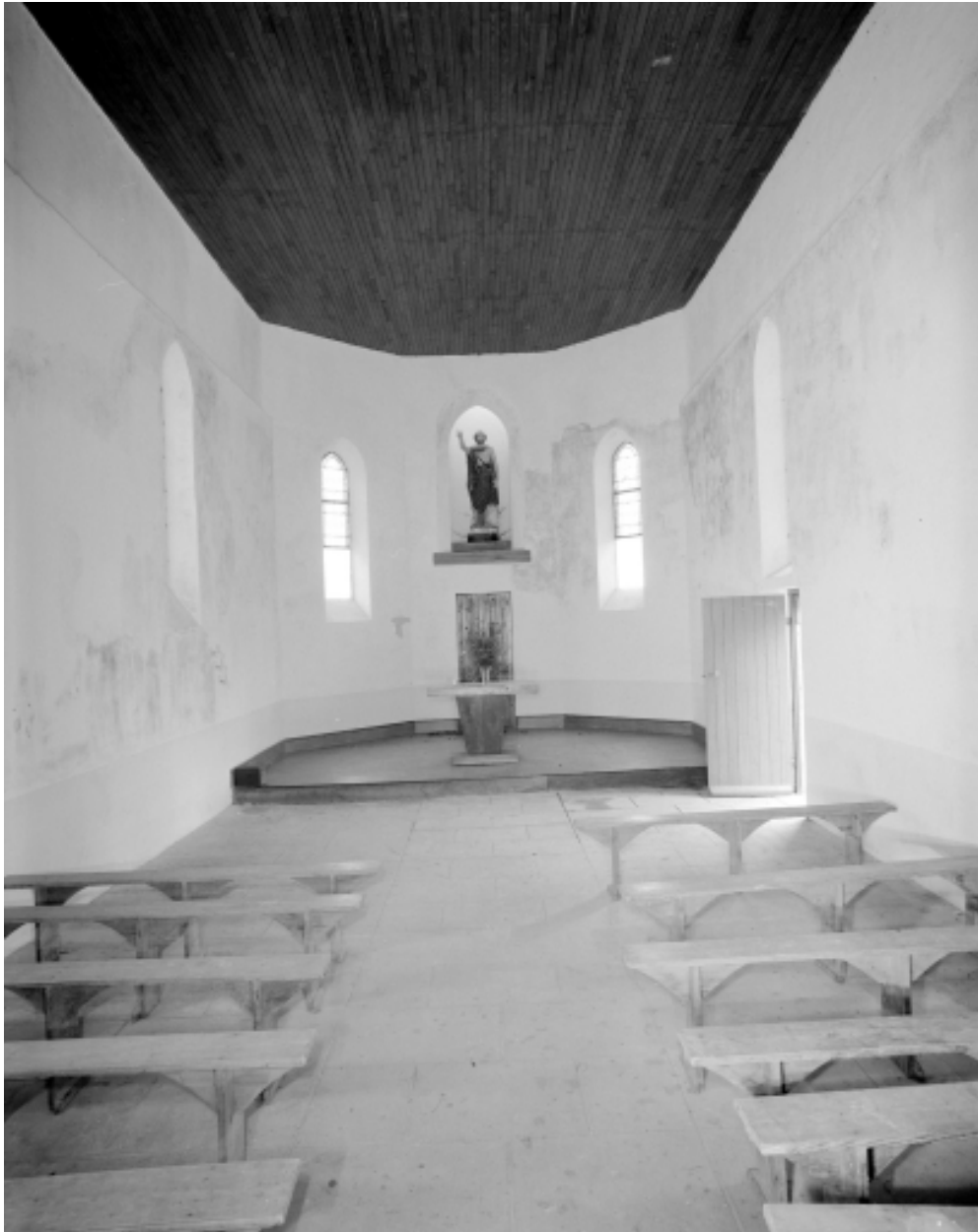
Intérieur : vue générale vers le chœur.
