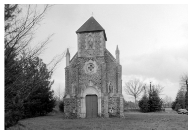
Elévation Ouest : vue générale Phot. Bernard Bègne, Phot. M. Luyon IVR53_19933500059X
