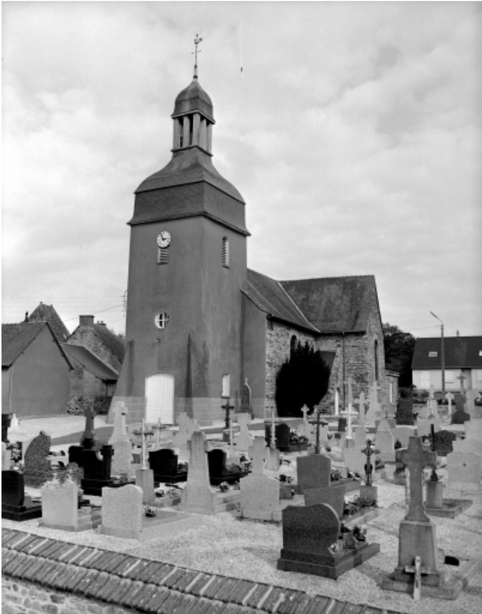
Elévation Ouest : vue générale
