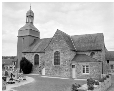
Elévation Sud : vue générale Phot. Guy Artur, Phot. Norbert Lambart IVR53_19943501948X
