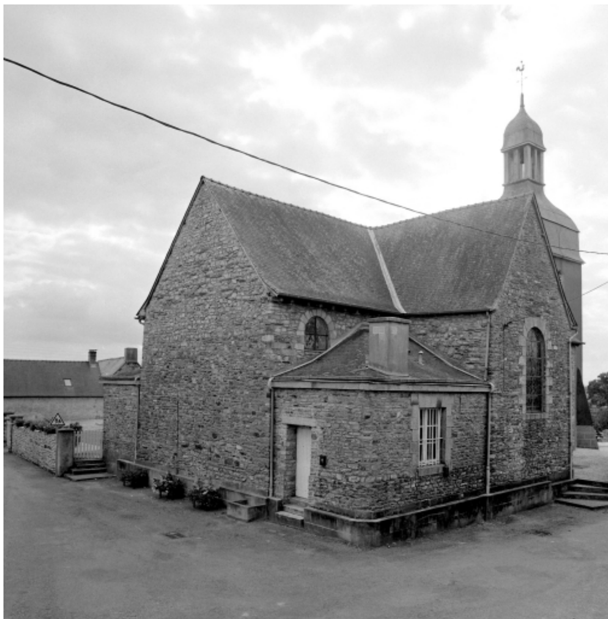
Elévation Nord-Est : vue générale
