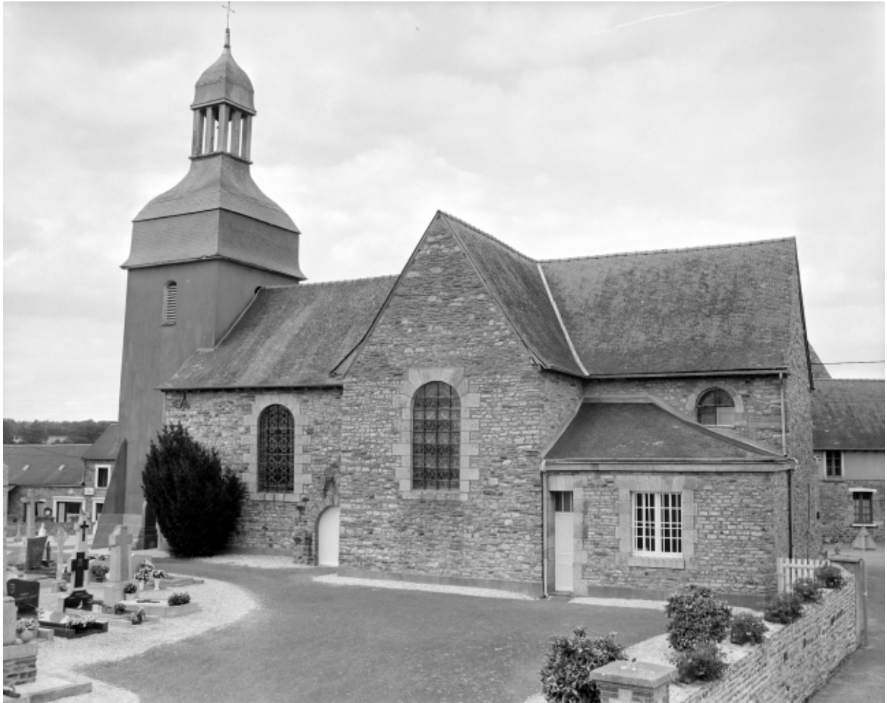
Elévation Sud : vue générale
