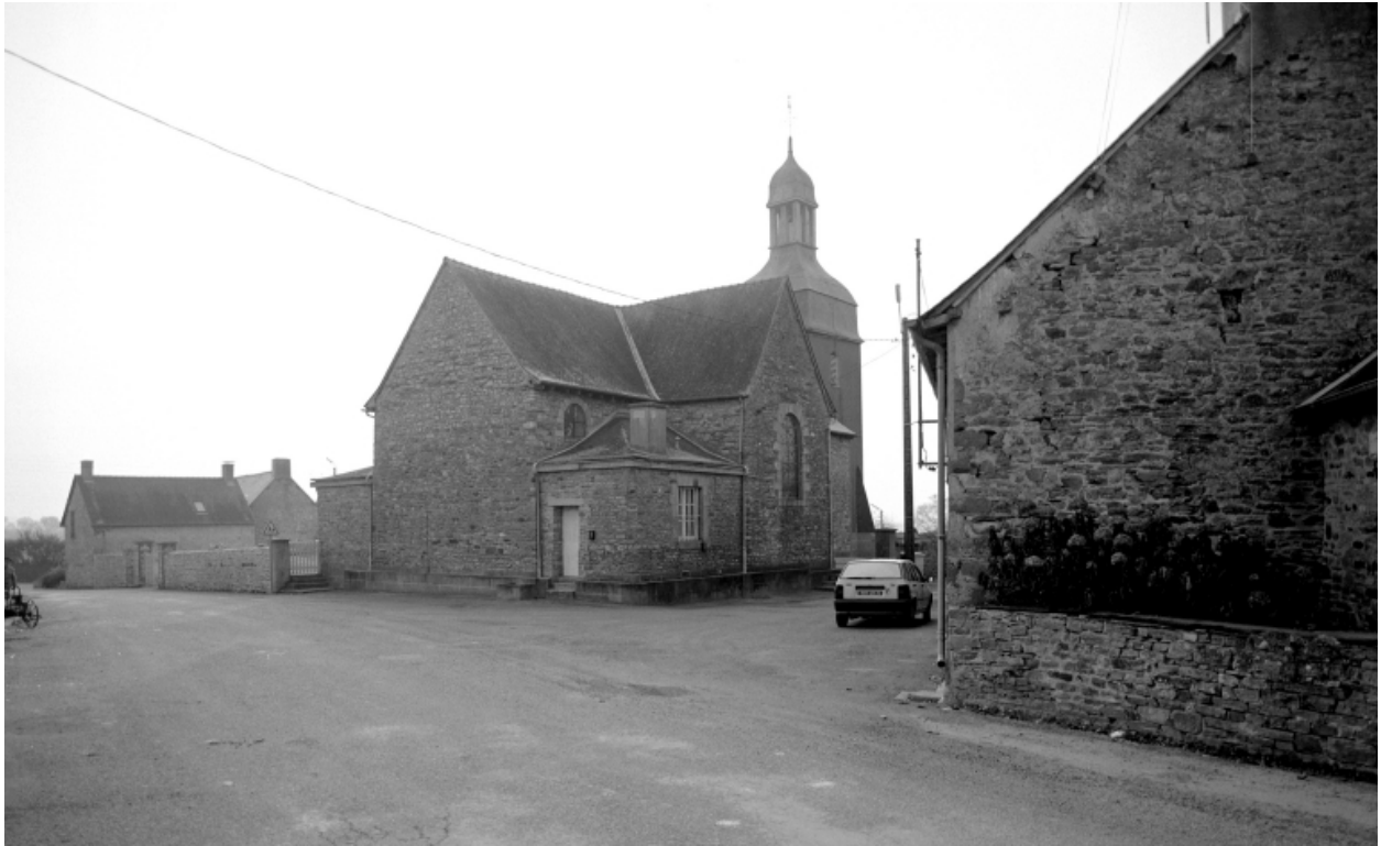
Elévation Nord-Est : vue générale
