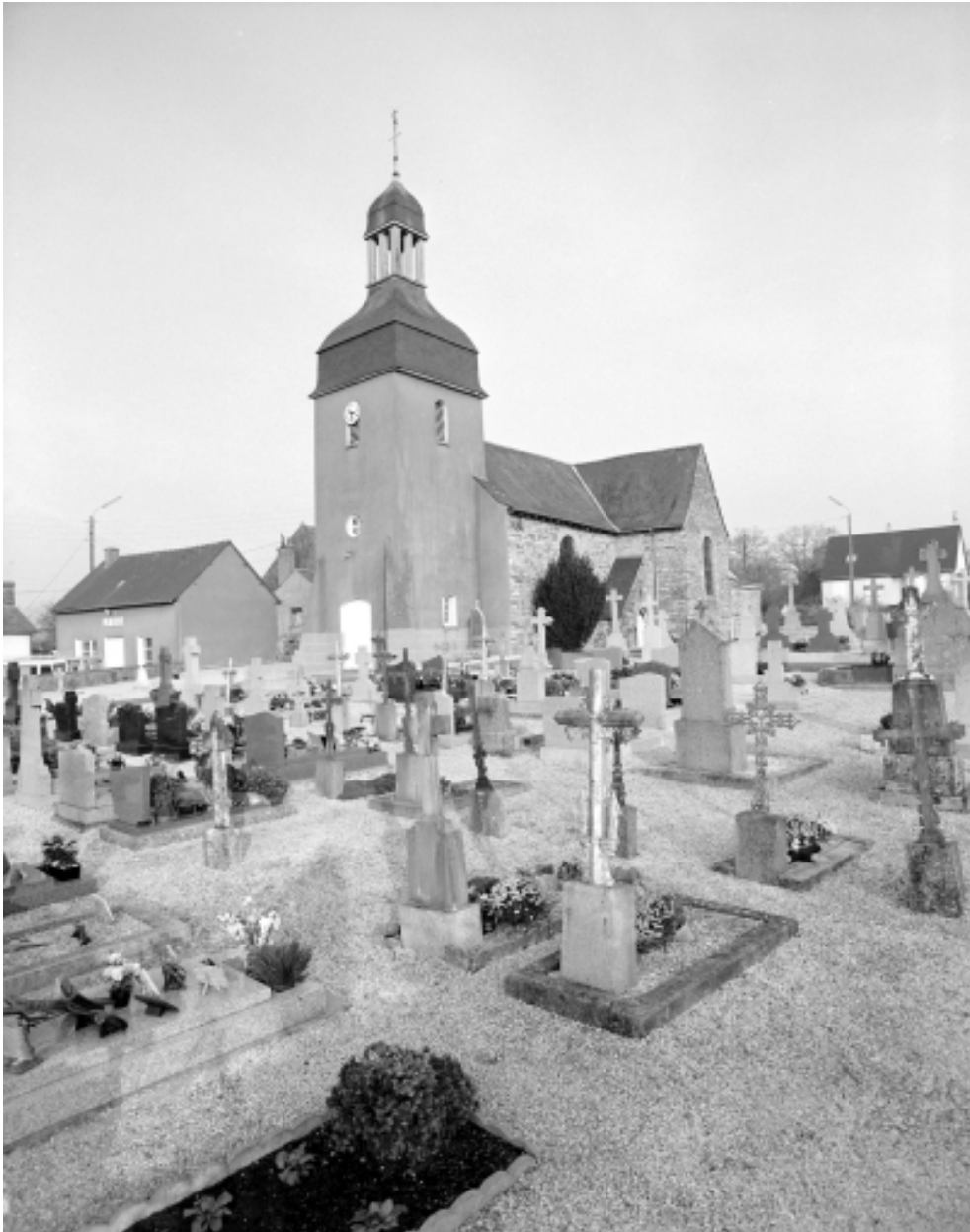
Elévation Ouest : vue de situation
