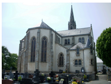
Plobannalec, église paroissiale Saint-Alour : vue générale nord-est Phot. Gwénaél Fauchille IVR53_20082905903NUCA
