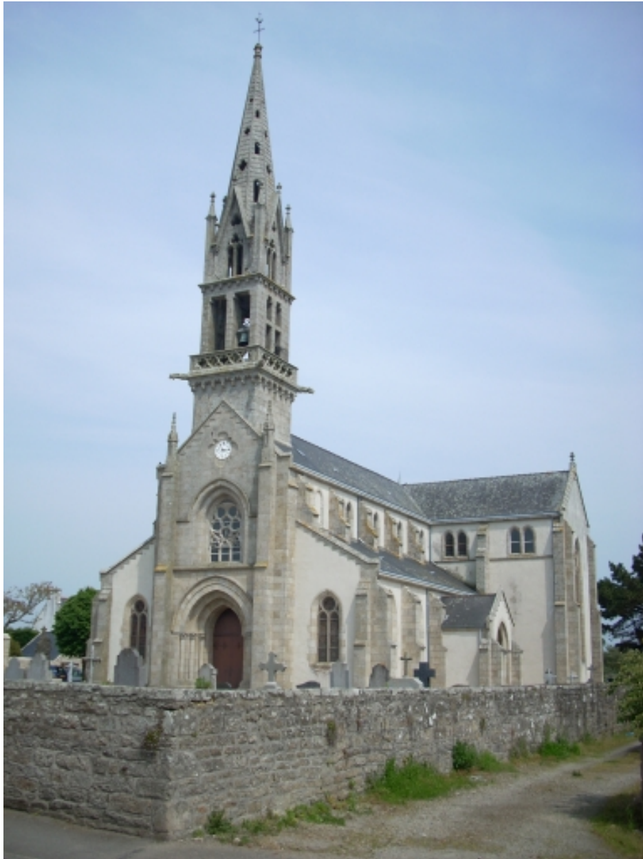
Plobannalec, église paroissiale Saint-Alour : vue générale sud-ouest
