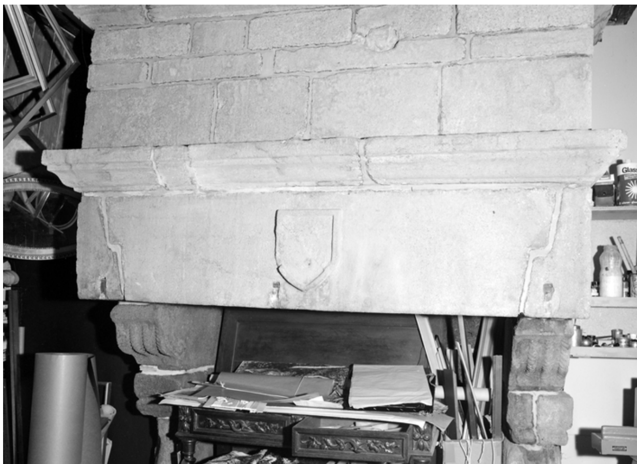
20 rue du Pont, linteau de cheminée.
