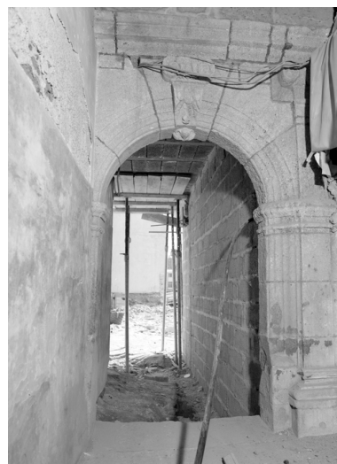
Porte 20 rue du Pont. Phot. François Dagorn IVR53_19745600340X
