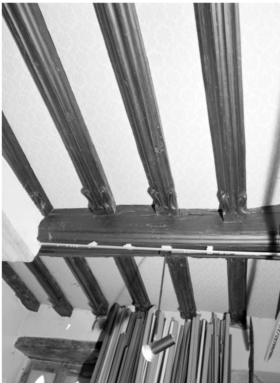
20 rue du Pont, plafond.
