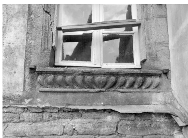
Détail décor sous une fenêtre. Phot. François Dagorn IVR53_19745600336X
