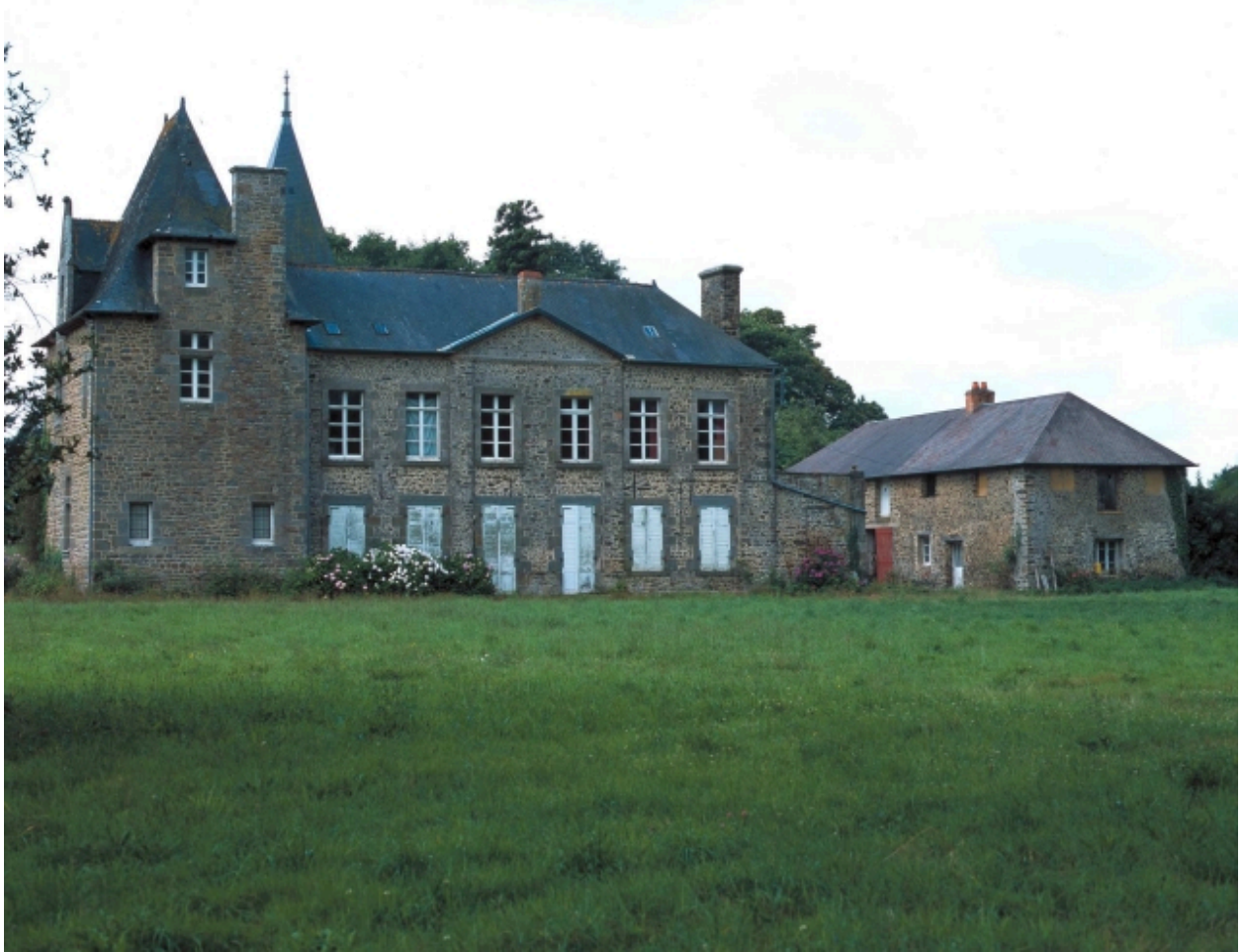
Vue générale nord
