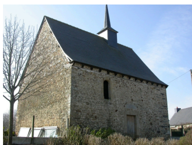
Vue de l'est Phot. Sabrina Dalibard IVR53_20043505928NUCA
