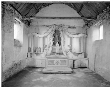
Intérieur de la chapelle Phot. Norbert Lambart IVR53_19923500899X
