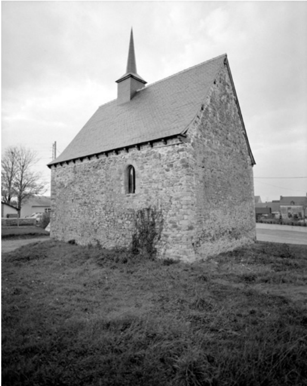
Vue générale de la chapelle
