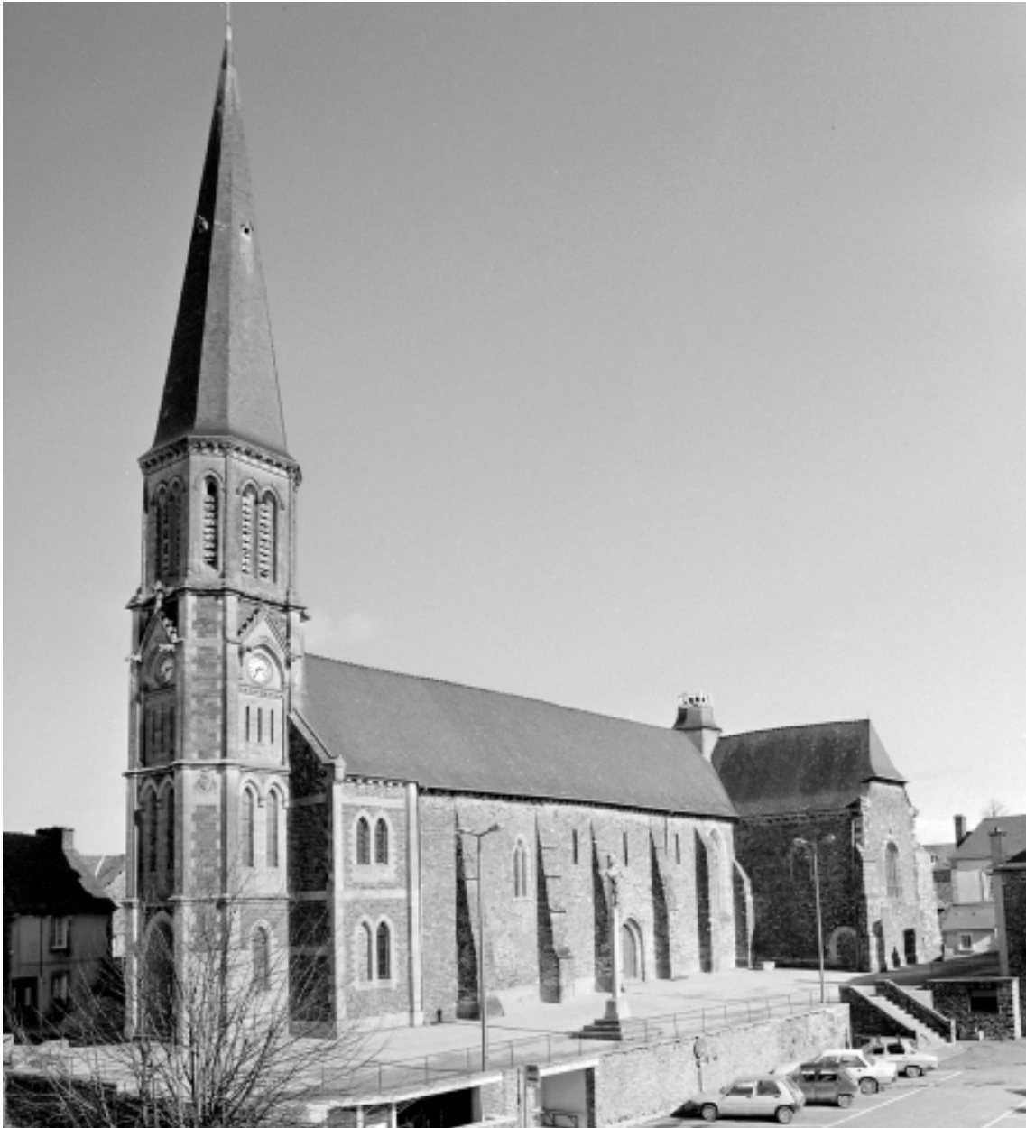
Elévation Sud-Ouest : vue générale
