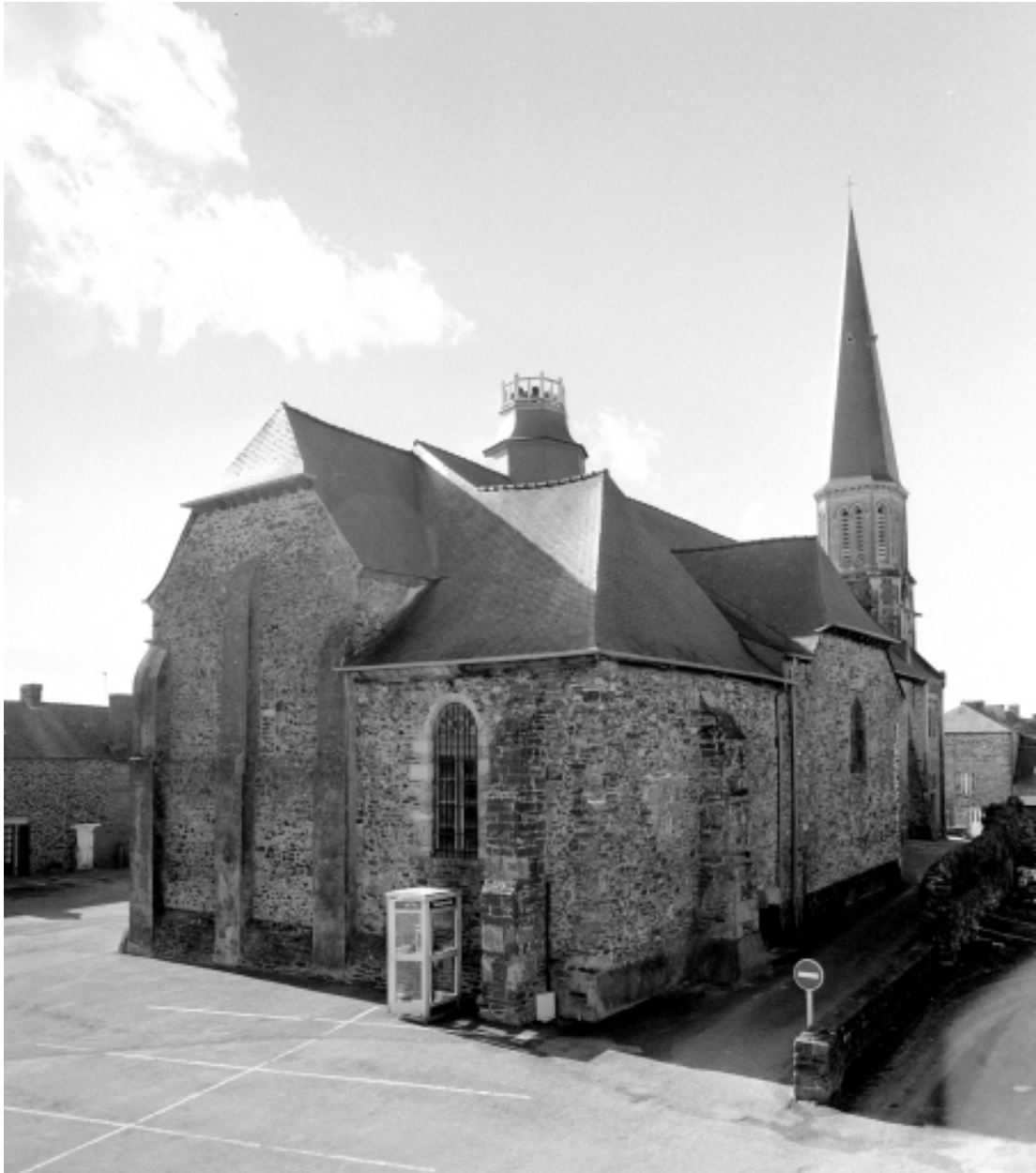
Elévation Nord-Est : vue générale
