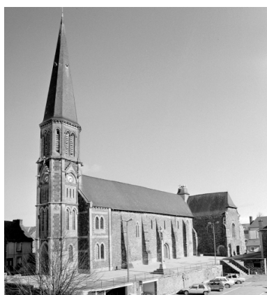
Elévation Sud-Ouest : vue générale Phot. Guy Artur, Phot. Norbert Lambart IVR53_19953500065X
