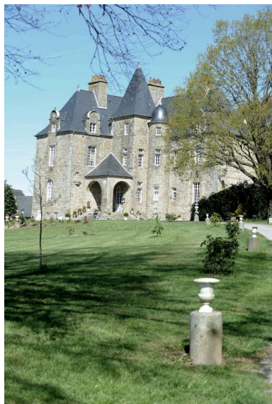
Vue sud-ouest Phot. Norbert Lambart IVR53_20143500154NUCA
