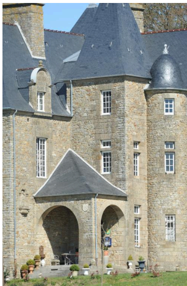
Détail des tours accolées Phot. Norbert Lambart IVR53_20143500153NUCA
