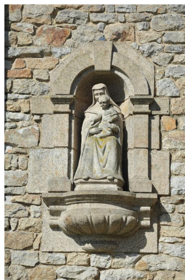
Niche et statue sur la façade du château Phot. Norbert Lambart IVR53_20143500155NUCA
