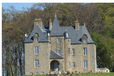
Vue générale Phot. Norbert Lambart IVR53_20143500152NUCA
