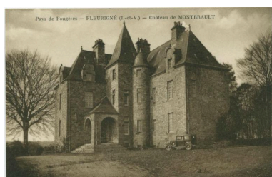
Fleurigné (I.-et-V.) Le château de Montbrault Repro. Archives départementales d'Ile-et-Vilaine IVR53_20133518380NUCA
