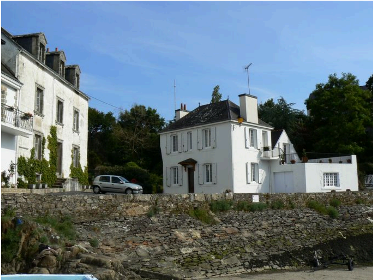
Maison 2 vue de la cale du Vieux Doëlan
