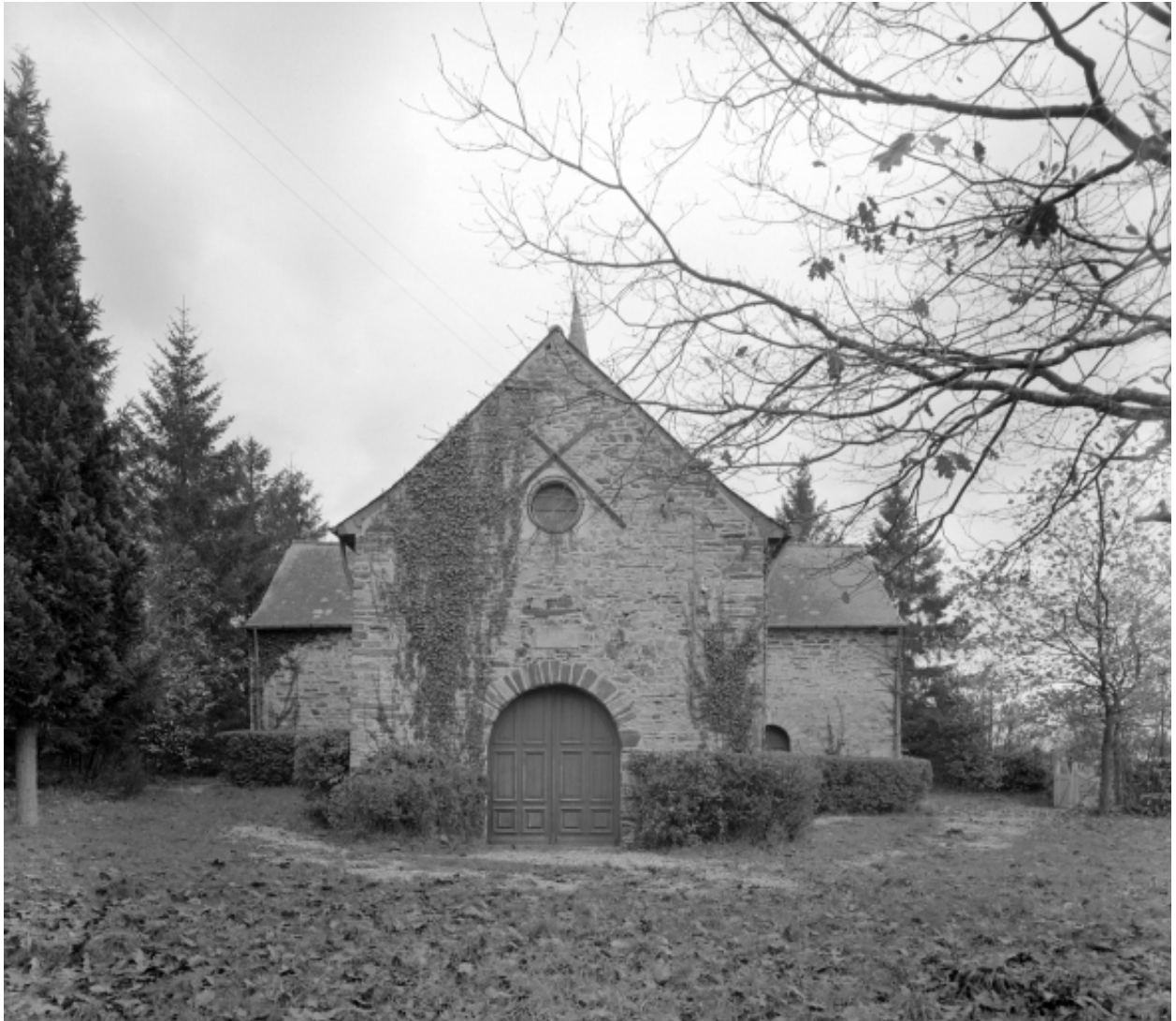
Elévation Ouest : vue générale
