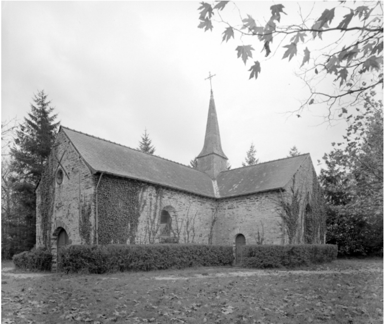
Elévation Sud : vue générale
