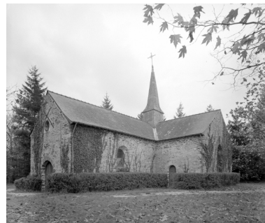
Elévation Sud : vue générale Phot. Guy Artur IVR53_19673500119V
