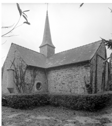
Elévation Nord-Est : vue générale Phot. Guy Artur IVR53_19673500121V
