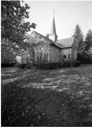
Elévation Est : vue générale Phot. Guy Artur IVR53_19703501406V
