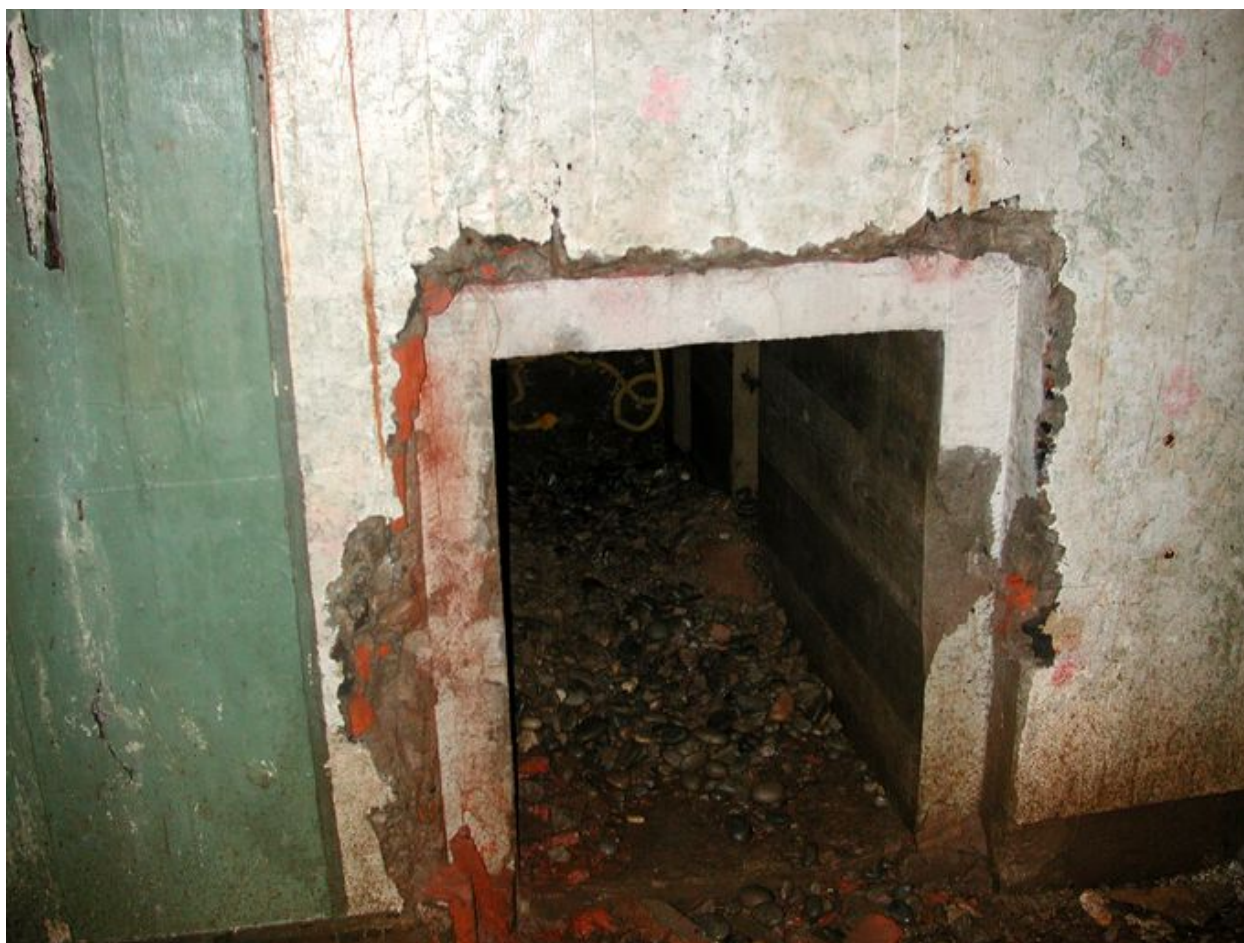
Vue de la sortie de secours du bunker depuis la pièce de vie - chambre de troupe (sa porte blindée de type 410P9 n'est plus en place) (état en 2003)
