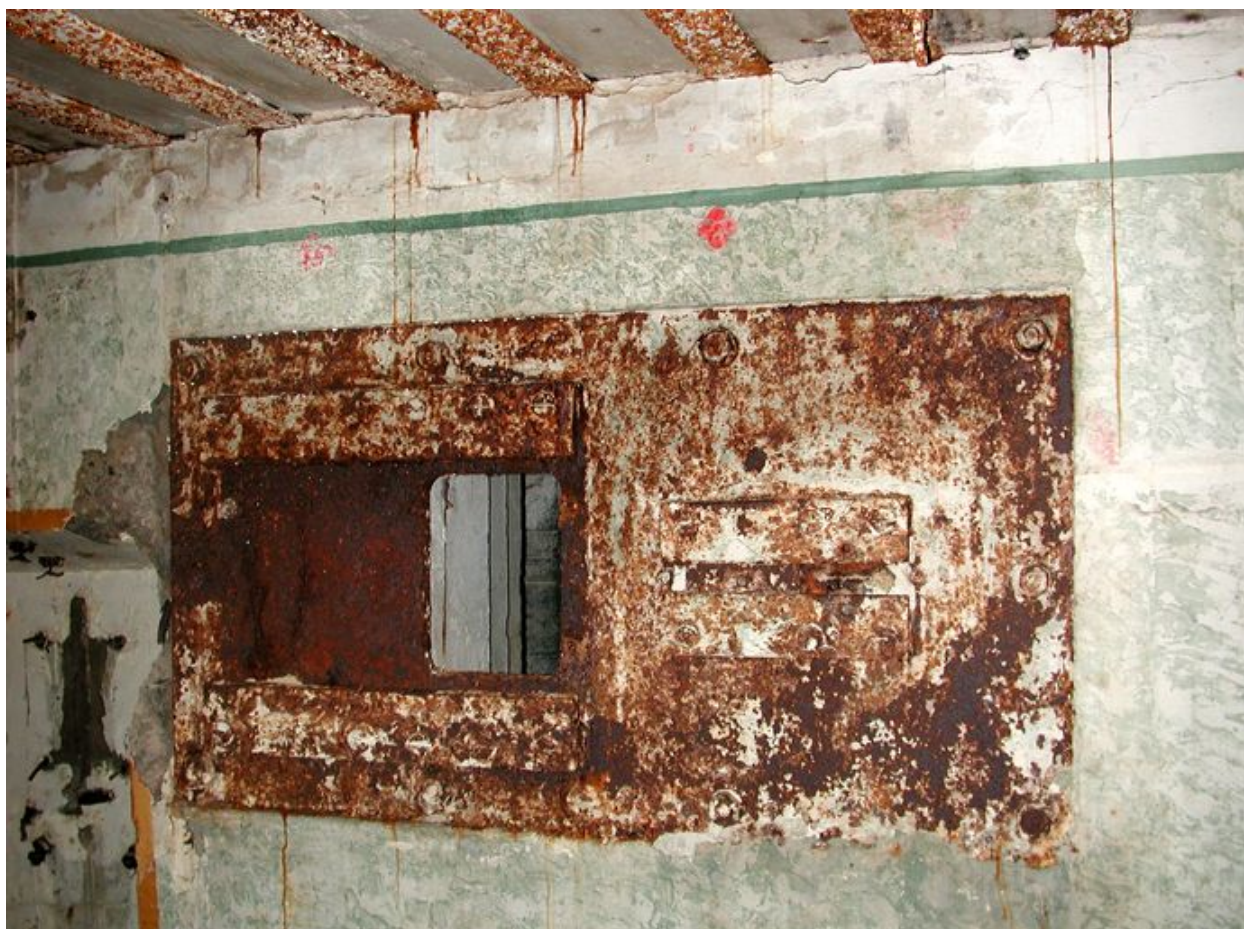
Vue de la pièce de vie - chambre de troupe du bunker : créneau blindé de défense d'entrée de type 422P01 (état en 2003)
