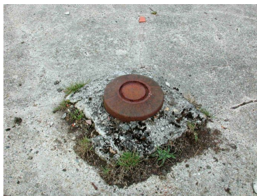
Vue de l'orifice de sortie du périscopes du bunker avec son bouchon de protection encore en place (état en 2003) Phot. Guillaume Lécueillier IVR53_20062904896NUCA
