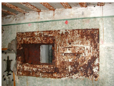
Vue de la pièce de vie - chambre de troupe du bunker : créneau blindé de défense d'entrée de type 422P01 (état en 2003) Phot. Guillaume Lécueillier IVR53_20062904901NUCA
