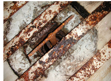
Vue de l'orifice d'entrée du périscopes du bunker avec son bouchon de protection encore en place (état en 2003) Phot. Guillaume Lécueillier IVR53_20062904903NUCA
