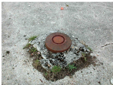
Vue de l'orifice de sortie du périscopes du bunker avec son bouchon de protection encore en place (état en 2003) Phot. Guillaume Lécueillier IVR53_20062904896NUCA
