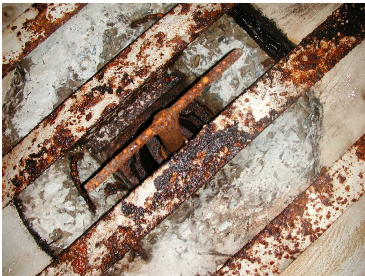
Vue de l'orifice d'entrée du périscope du bunker avec son bouchon de protection encore en place (état en 2003)
