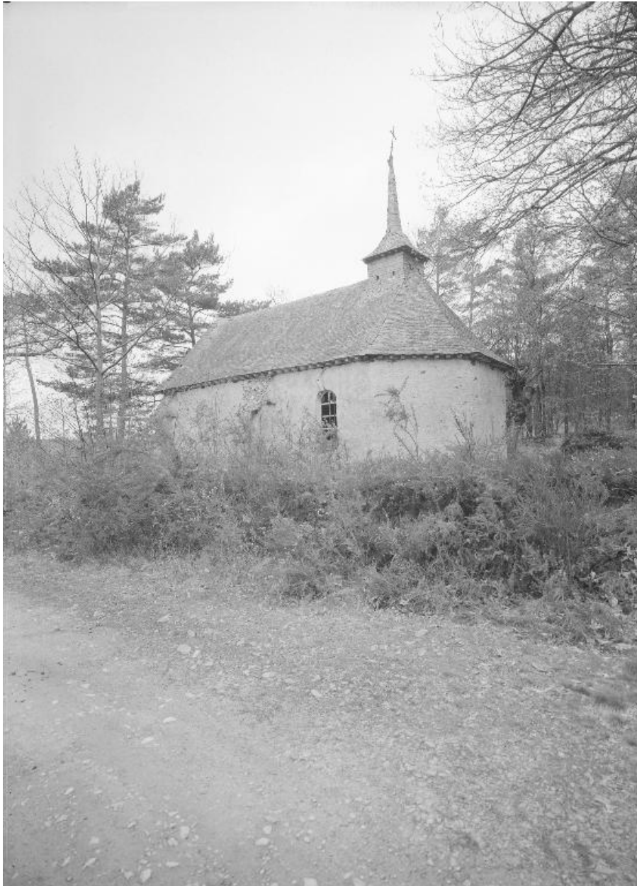
Elévation sud-est : vue générale (Etat en 1968)
