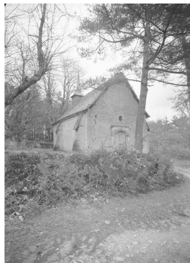
Elévation nord-ouest : vue générale (Etat en 1968) Phot. Guy Artur IVR53_19683500313V
