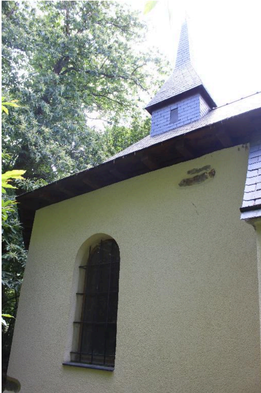
Baie façade nord - Vue générale
