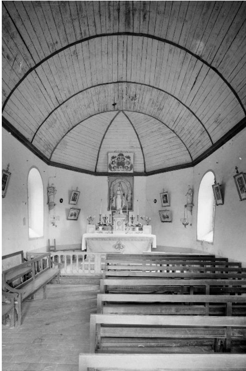
Intérieur, nef : vue générale (Etat en 1968)
