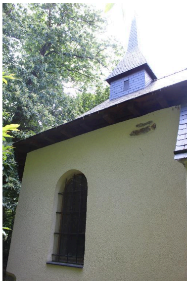
Baie façade nord - Vue générale Phot. Déborah De Sousa Figueiredo IVR53_20163505652NUCA
