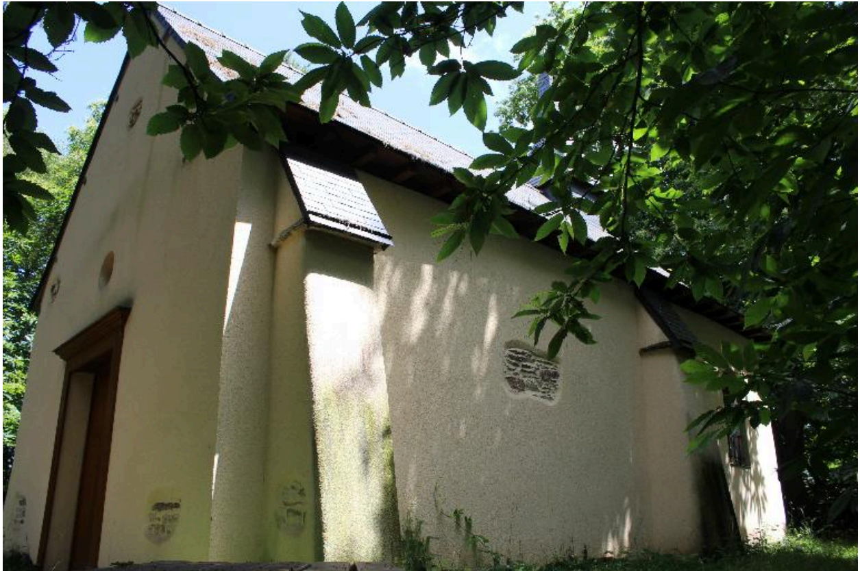
Façade méridionale - Vue générale
