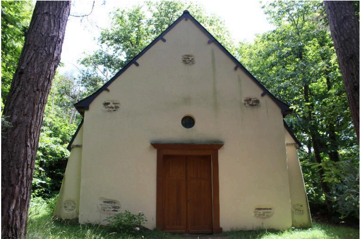
Façade occidentale - Vue générale
