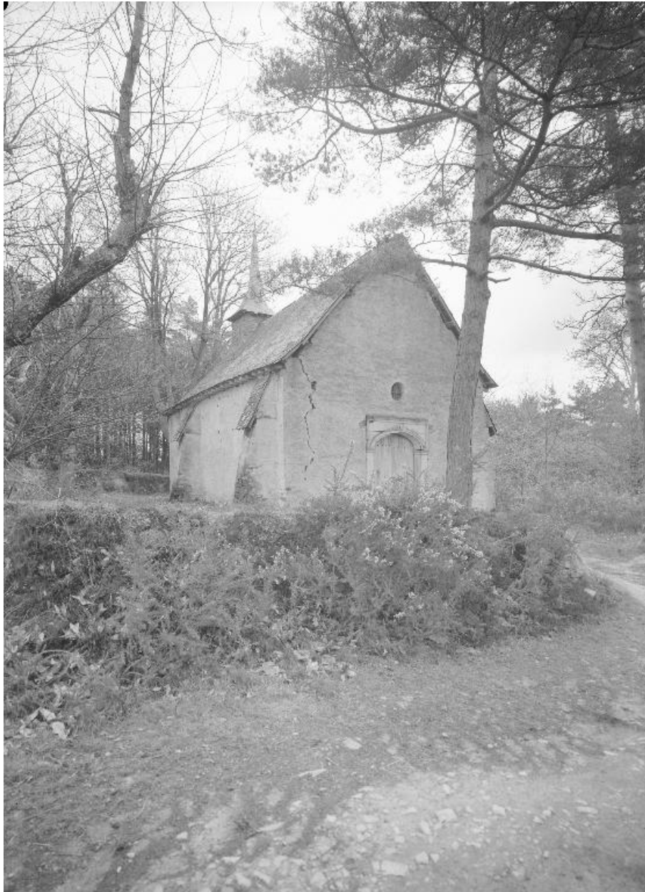
Elévation nord-ouest : vue générale (Etat en 1968)
