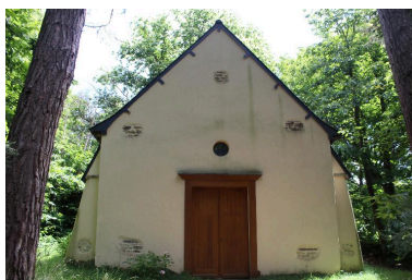
Façade occidentale - Vue générale Phot. Déborah De Sousa Figueiredo IVR53_20163505649NUCA
