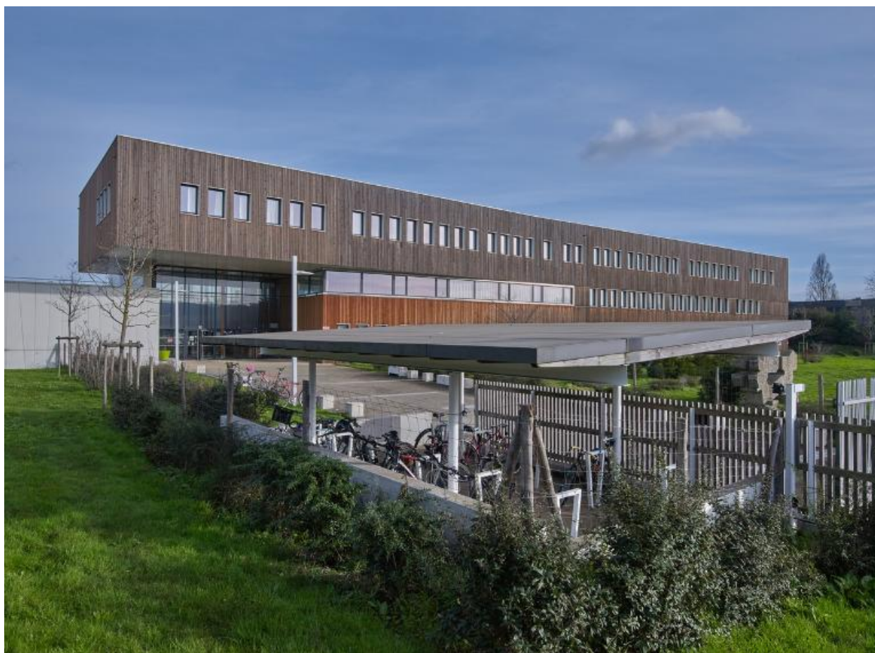
Vue d'ensemble prise du nord-ouest du nouveau bâtiment multifonctions en bois : hall d'accueil, administration, CDI, salle des professeurs, classes. Pierre Brulé, architecte, 2017. Au premier plan : garage à vélos.
