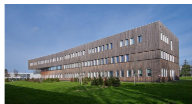
Vue d'ensemble prise du sud-ouest du nouveau bâtiment multifonctions en bois : hall d'accueil, administration, CDI, salle des professeurs, classes. Pierre Brulé, architecte, 2017. Phot. Bernard Bègne IVR53_20233500028NUCA
