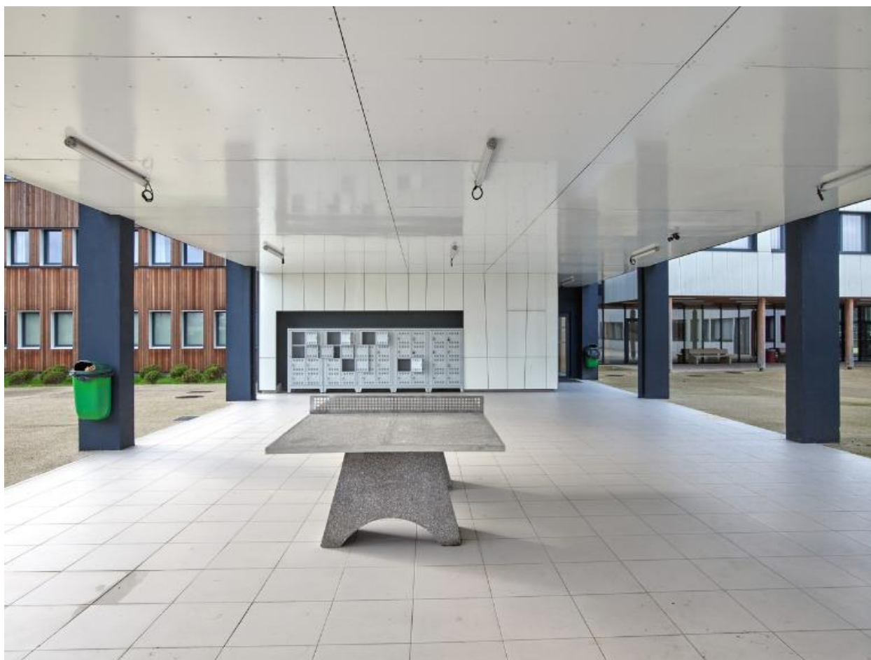
Préau de l'externat. Vue prise dans l'axe, de l'est vers l'ouest.
