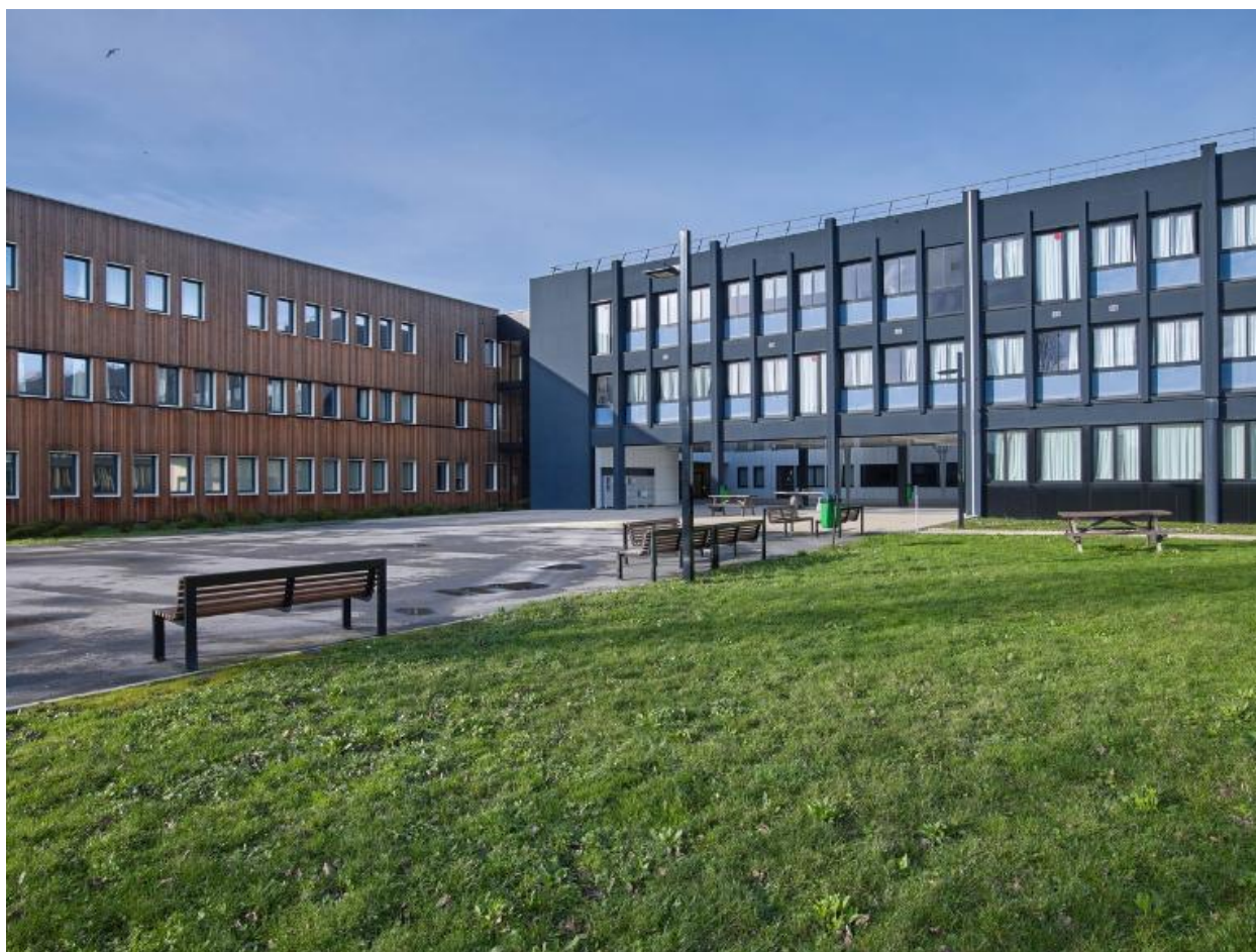
A droite, façade est du nouveau bâtiment (Pierre Brulé, architecte, 2021), à gauche, façade sud de l'externat (Roger Besnard, architecte, 1973, restructuration Pierre Brulé, architecte, 2021).
