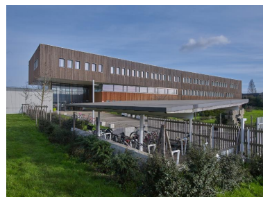
Vue d'ensemble prise du nord-ouest du nouveau bâtiment multifonctions en bois : hall d'accueil, administration, CDI, salle des professeurs, classes. Pierre Brulé, architecte, 2017. Au premier plan : garage à vélos. Phot. Bernard Bègne IVR53_20233500011NUCA
