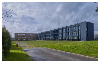
Vue d'ensemble prise du sud-est du nouveau bâtiment multifonctions en bois et de l'externat restructuré. Pierre Brulé, architecte, 2021. Phot. Bernard Bègne IVR53_20233500138NUCA
