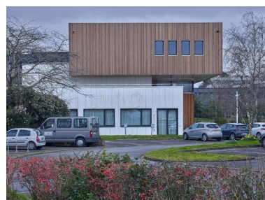
Vue d'ensemble de la façade nord du nouveau bâtiment multifonctions en bois : hall d'accueil, administration,
