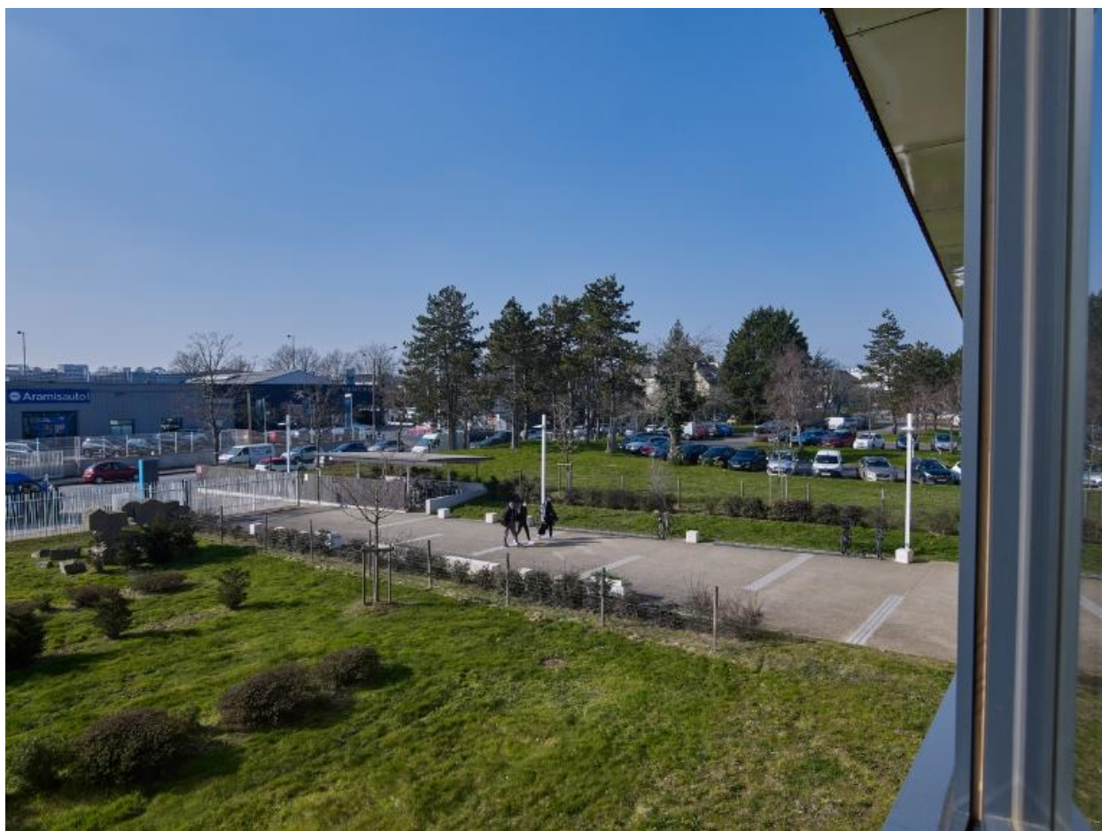
Vue d'ensemble de l'entrée restructurée en 2017-2021. A gauche, la sculpture de Francis Pellerin, à droite, le garage à vélos.
