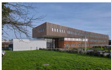
Vue d'ensemble prise du nord-ouest du nouveau bâtiment multifonctions en bois : hall d'accueil, administration, CDI, salle des professeurs, classes. Pierre Brulé, architecte, 2017. Phot. Bernard Bègne IVR53_20233500012NUCA
