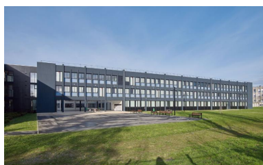
Façade sud de l'externat, Roger Besnard, architecte, 1973, restructuration, Pierre Brulé, architecte, 2021. Phot. Bernard Bègne IVR53_20233500030NUCA
