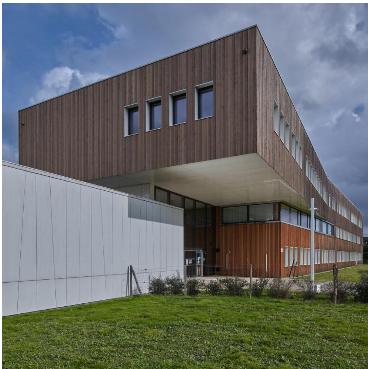
Vue d'ensemble prise du nord-ouest du nouveau bâtiment multifonctions en bois : hall d'accueil, administration, CDI, salle des professeurs, classes. Pierre Brulé, architecte, 2017. Noter la fonction d'auvent du porte-à-faux.
