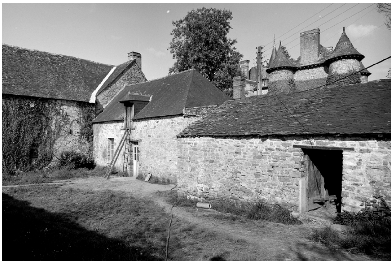
Vue sud-ouest des communs.
