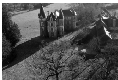
Vue aérienne. Phot. G.A.L.A.T. IVR53_19713500480V
