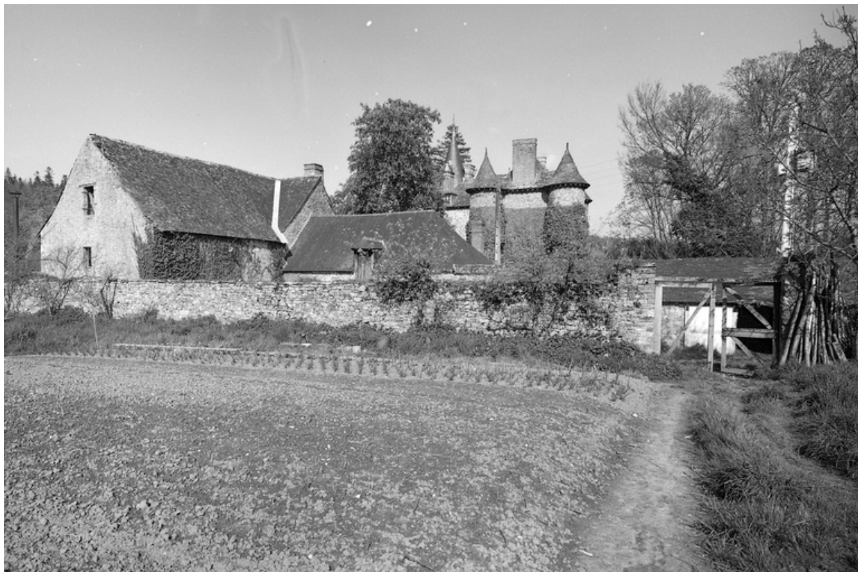
Vue de la face ouest des communs et du château.
