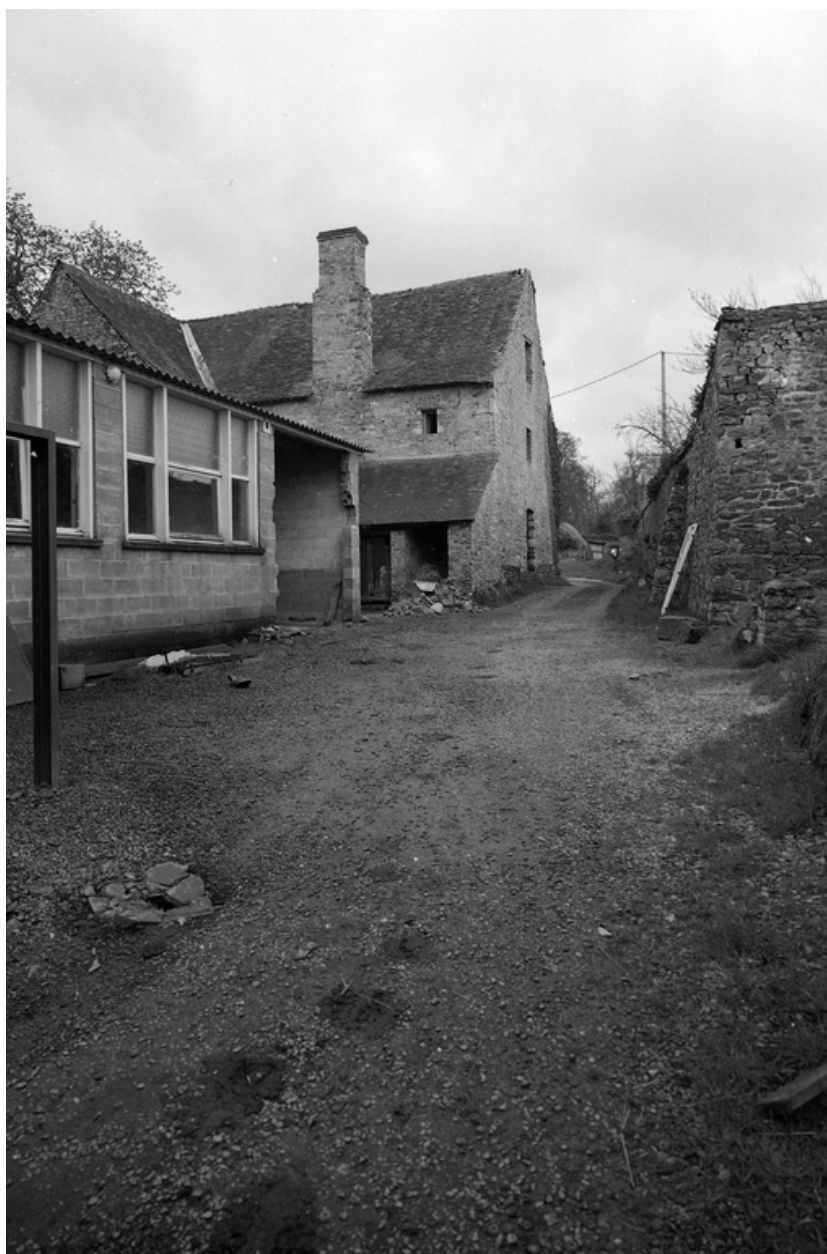
Vue générale des communs pignon ouest façade nord.
