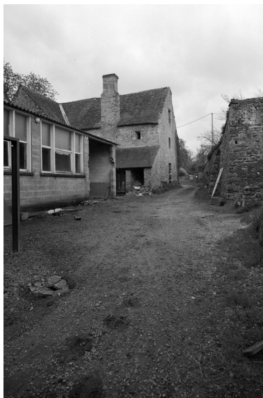
Vue générale des commons pignon ouest façade nord.
