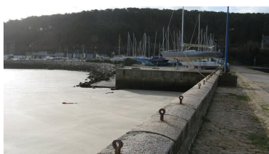
Terre-plein et partie proximale du môle Phot. Guillaume Marie IVR53_20072908651NUCA
