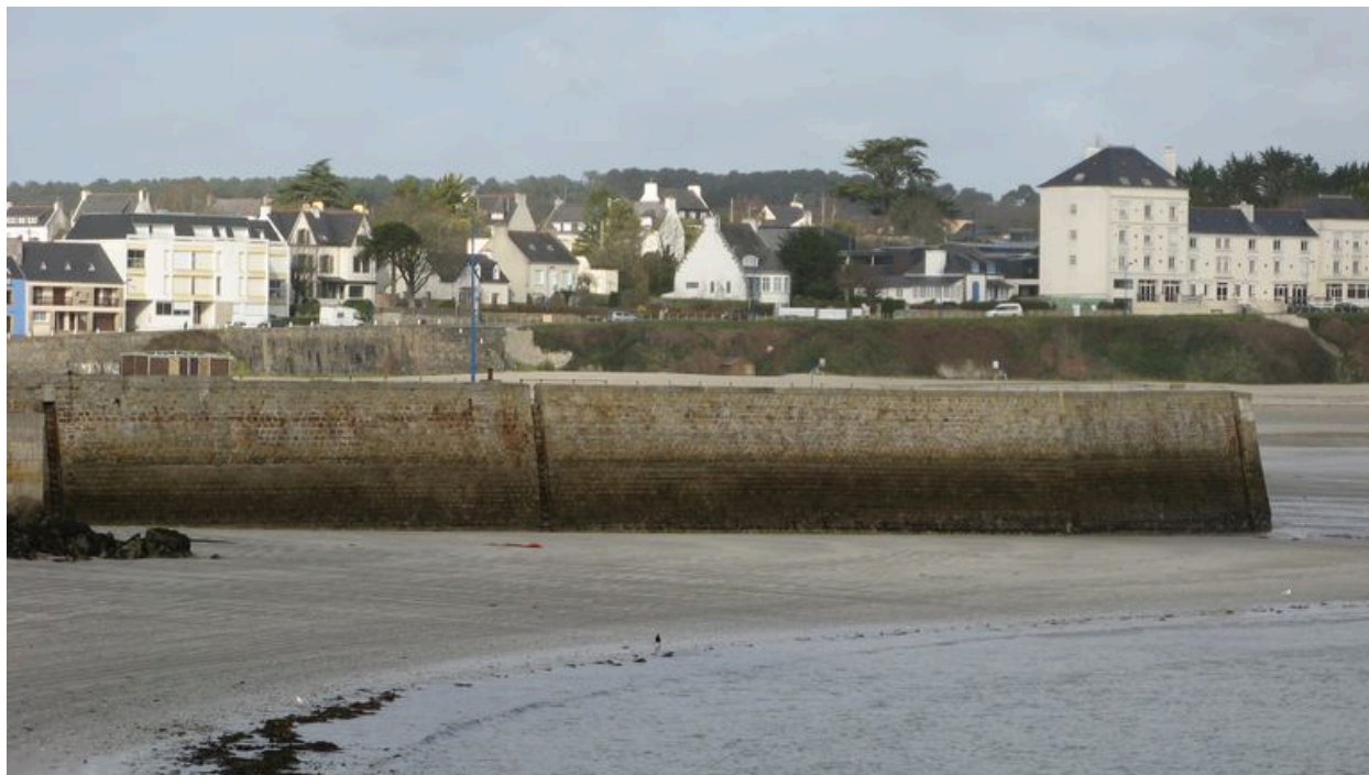
Môle vu du port de plaisance
