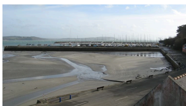
Vue générale du môle Phot. Guillaume Marie IVR53_20072908649NUCA
