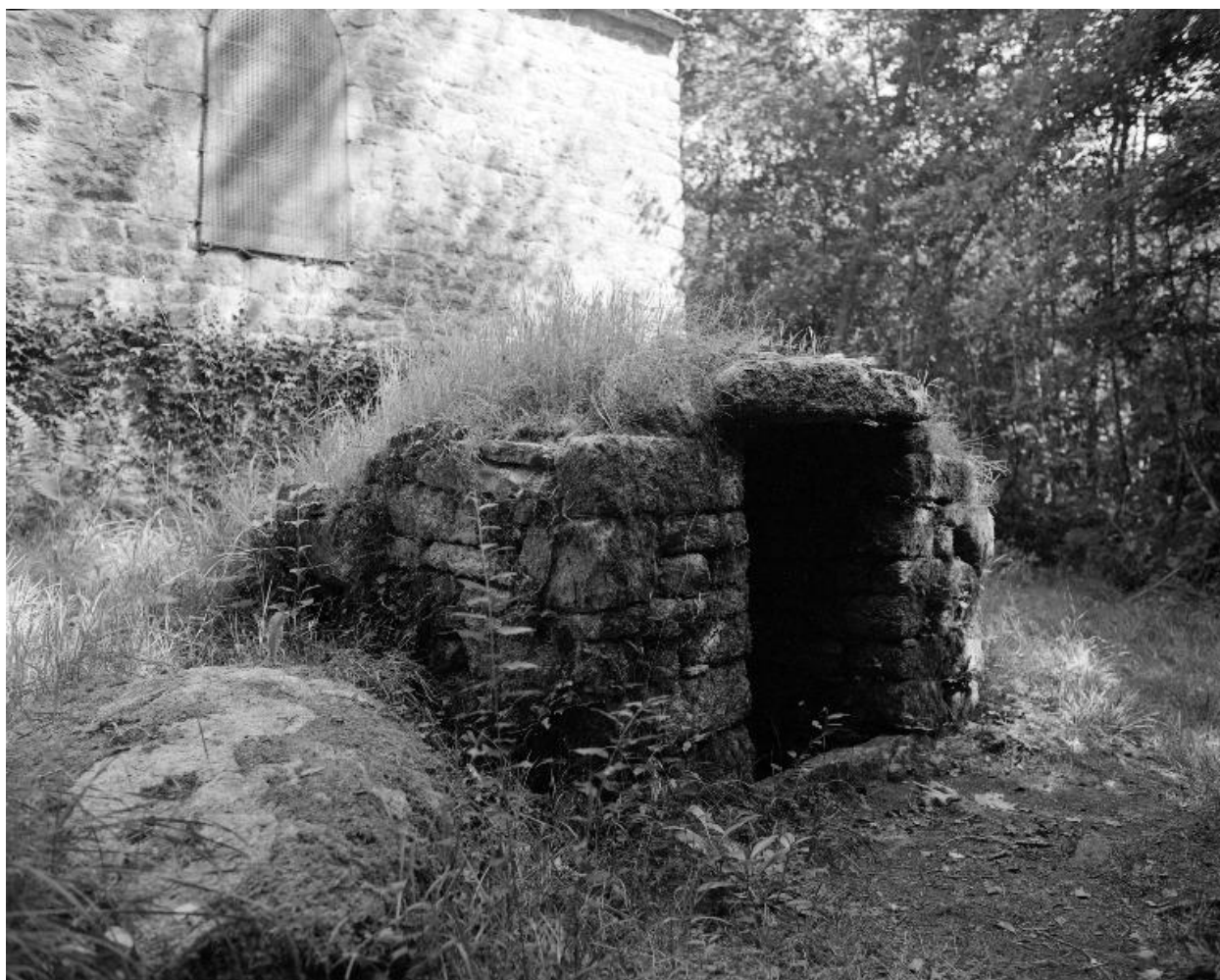
Fontaine : vue générale
