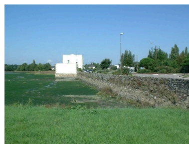
Moulin à marée de Cantizac, actuellement maison d'habitation Phot. Julien Amghar IVR53_20085606145NUCA
