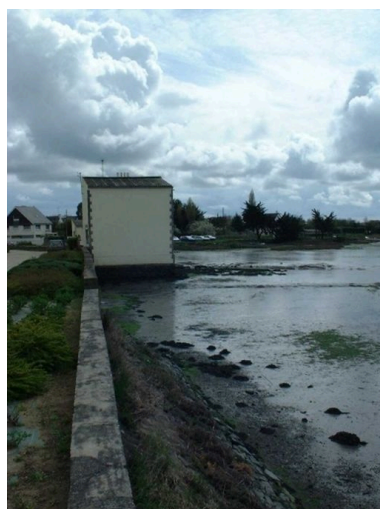
Moulin à marée de Cantizac, actuellement maison d'habitation Phot. Julien Amghar IVR53_20085606143NUCA
