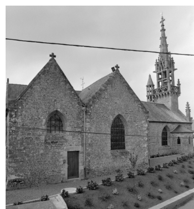
Elévation Nord : vue générale Phot. Guy Artur, Phot. Norbert Lambart IVR53_19943501933X
