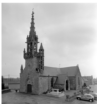
Elévation Sud-Ouest : vue générale Phot. Guy Artur, Phot. Norbert Lambart IVR53_19943501934X
