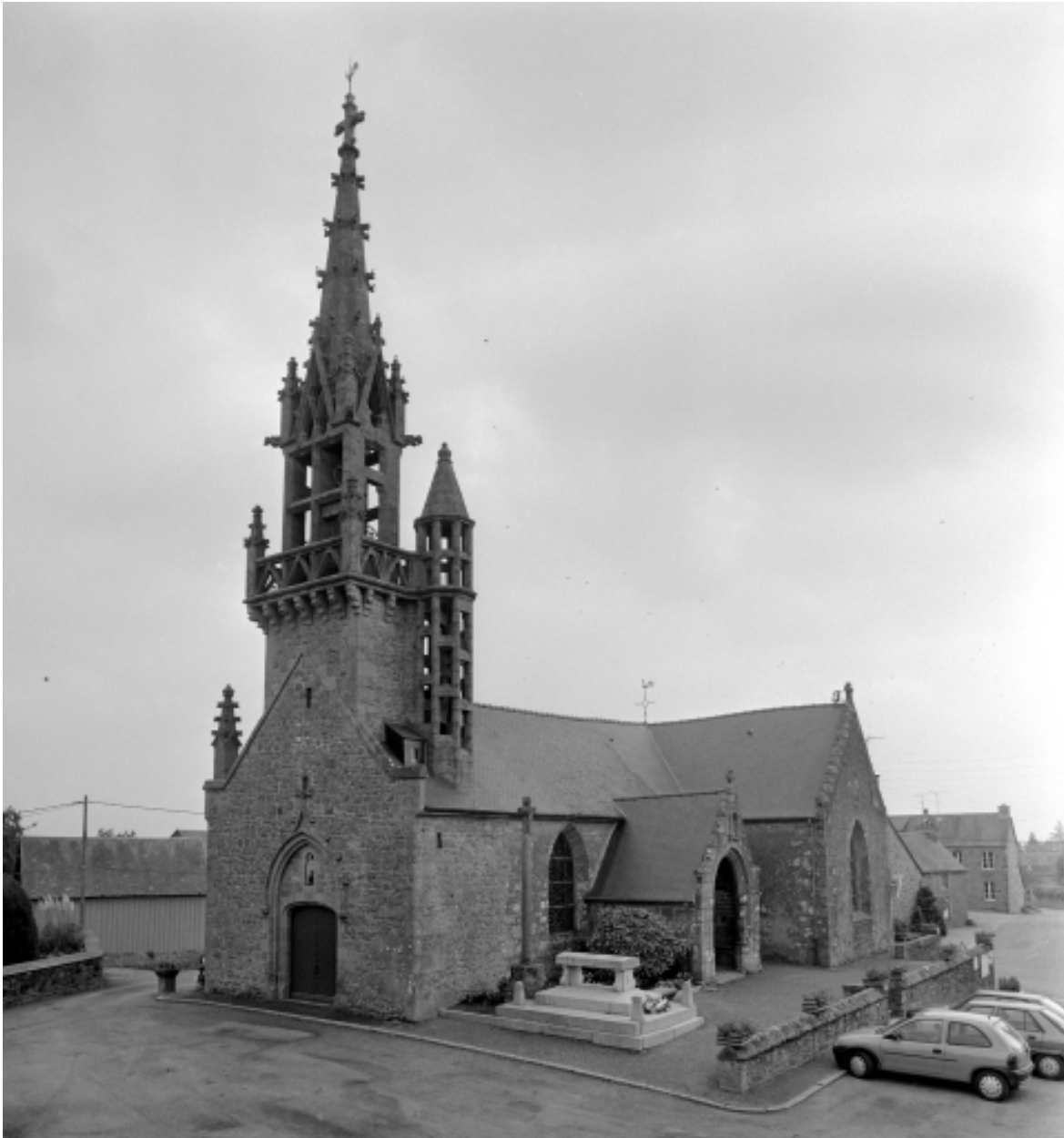
Elévation Sud-Ouest : vue générale
