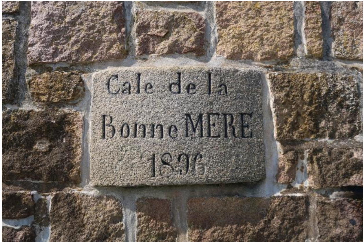
Inscription Cale de la/Bonne MERE/1896 insérée dans la maçonnerie du quai d'Auxerre
