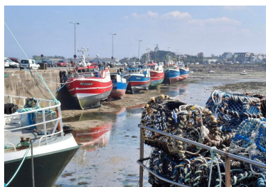
Nouveau quai et bassin du port de pêche Phot. Erwana L'Haridon IVR53_20252910403NUCA
