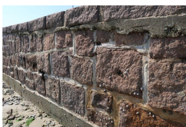
Maçonnerie de granite rose de la cale et du quai d'Auxerre Phot. Erwana L'Haridon IVR53_20252910786NUCA
