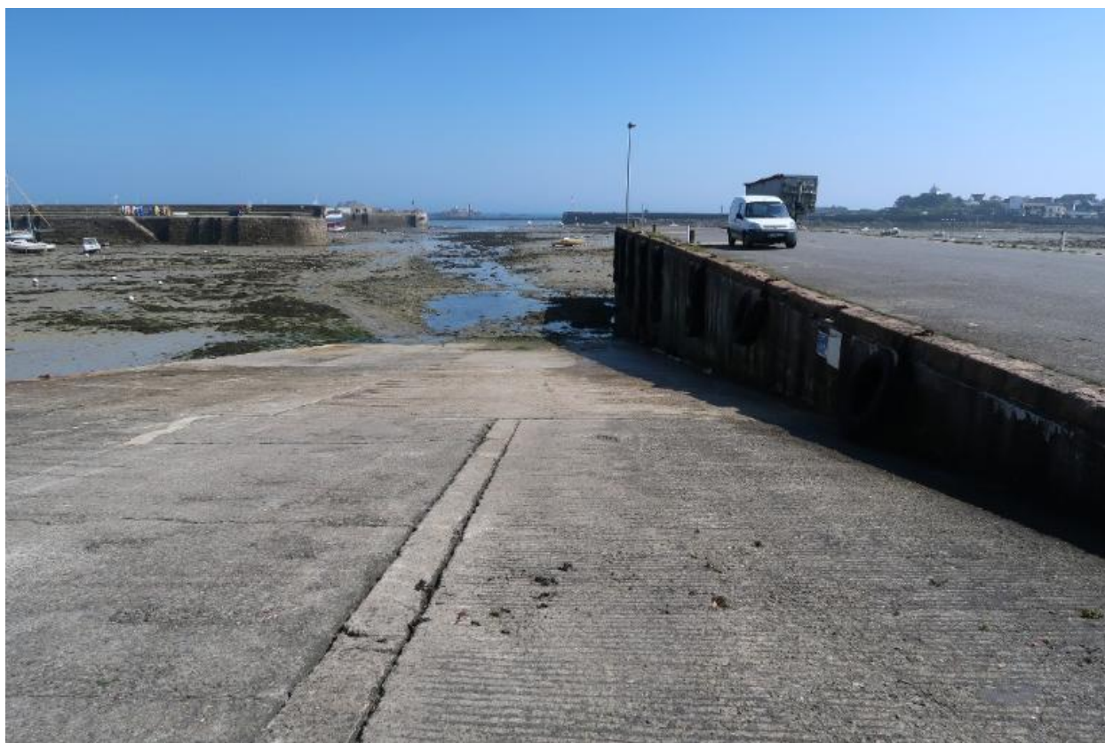
Cale de la barge et port à marée basse
