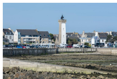
Phare de Roscoff dans son environnement portuaire et urbain Phot. Charlotte Barraud IVR53_2025291038NUCA
