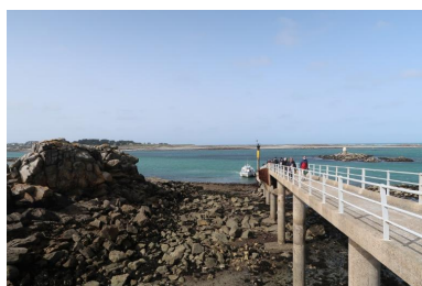
Estacade du port de Roscoff : débarquement Phot. Erwana L'Haridon IVR53_20252910231NUCA
