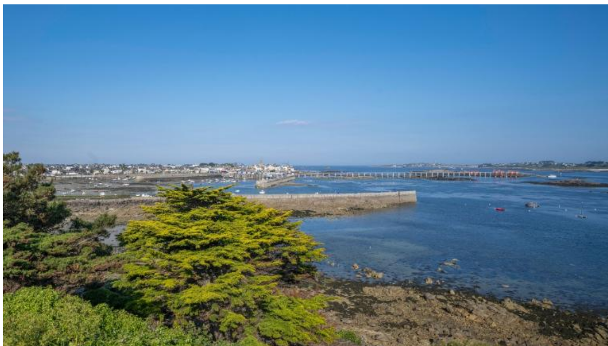
Le vieux port de Roscoff, ses ouvrages portuaires, l'estacade et la ville depuis le promontoire de la chapelle Sainte-Barbe
