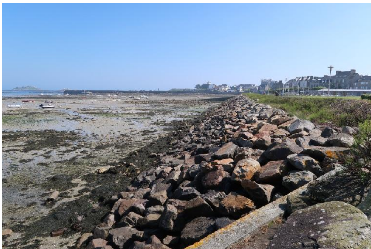
Enrochement du terre-plein de la rue Jeanne d'Arc
