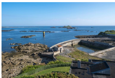
Le balisage du chenal d'accès et les viviers de Sainte-Barbe Phot. Charlotte Barraud IVR53_2025291066NUCA
