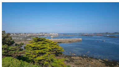
Le vieux port de Roscoff, ses ouvrages portuaires, l'estacade et la ville depuis le promontoire de la chapelle Sainte-Barbe Phot. Charlotte Barraud IVR53_2025291067NUCA
