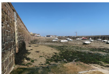
Vue générale du premier bassin avec la maçonnerie du quai d'Auxerre Phot. Erwana L'Haridon IVR53_20252910783NUCA
