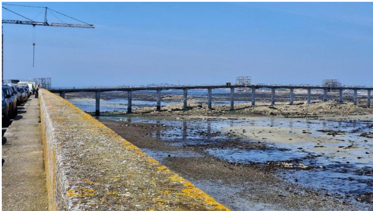
Parapet du nouveau quai et estacade
