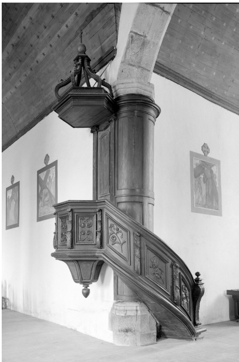
Croisée du transept, angle nord ouest : chaire
