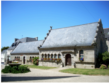
Plouñéour-Trez, église paroissiale : vue générale sud-est des ossuaires Phot. Gwénaél Fauchille IVR53_20082906304NUCA
