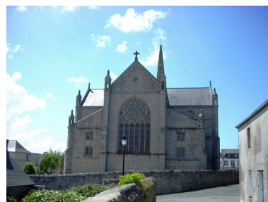
Plounéour-Trez, église paroissiale : vue générale est Phot. Gwénaél Fauchille IVR53_20082906303NUCA
