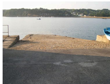
Extrémité de la cale du Fret Phot. Clotilde Buhot IVR53_20062908546NUCA
