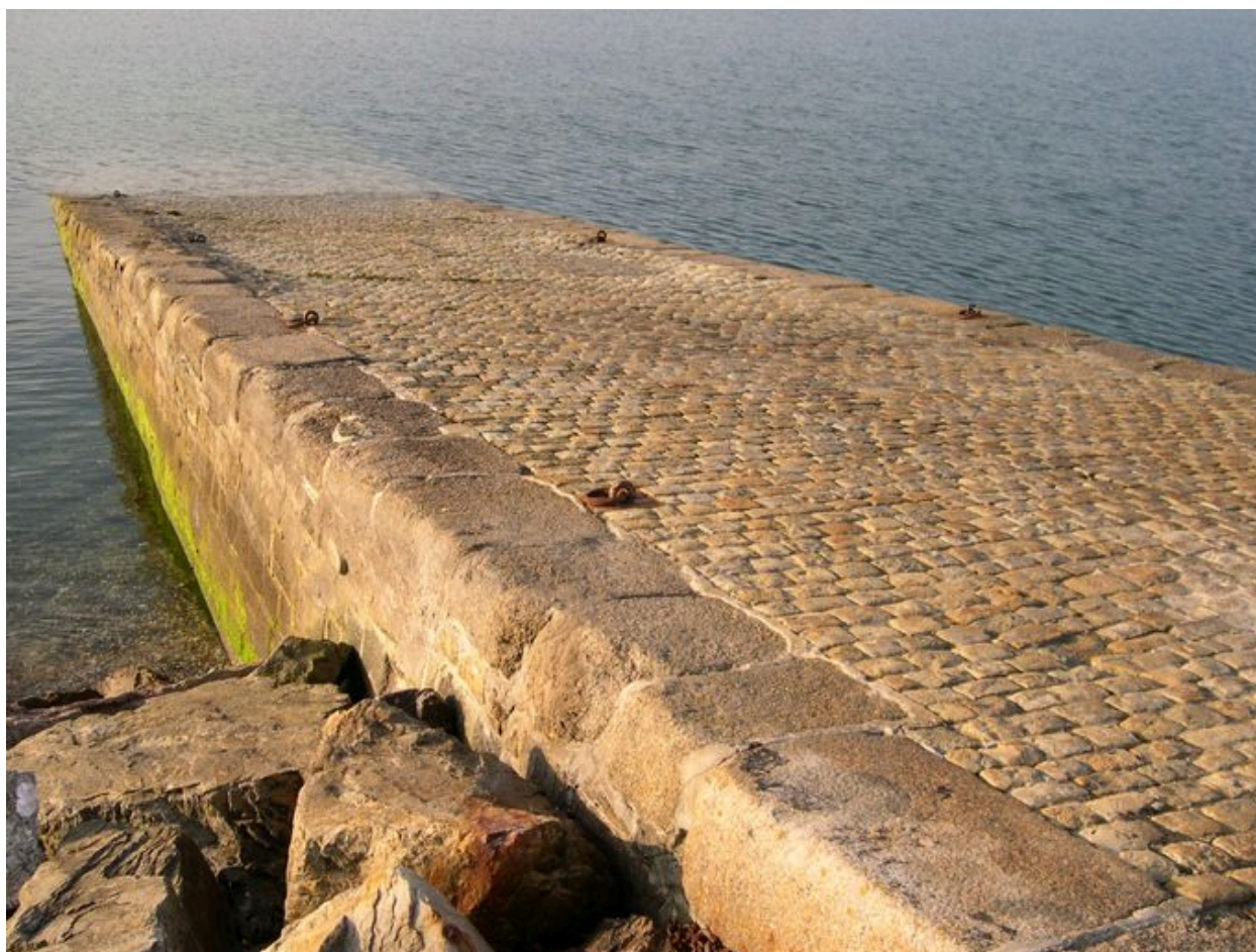
Vue générale de la cale du Fret
