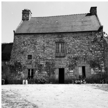
Maison (parcelle 298) : vue d'ensemble de la façade ouest Phot. Jean-Yves Veillard IVR53_19665600662X
