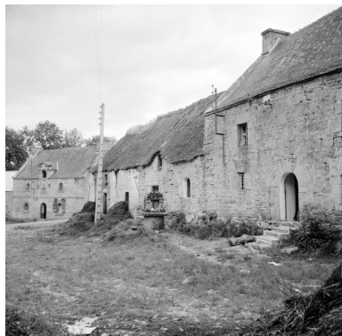
Kerdanet, alignement de maisons : vue de situation prise du nord-est Phot. Jean-Yves Veillard IVR53_19665600768X
