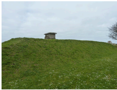
Le Palais, citadelle, magasin à poudre du bastion 3, massif terrassé et cheminée.
