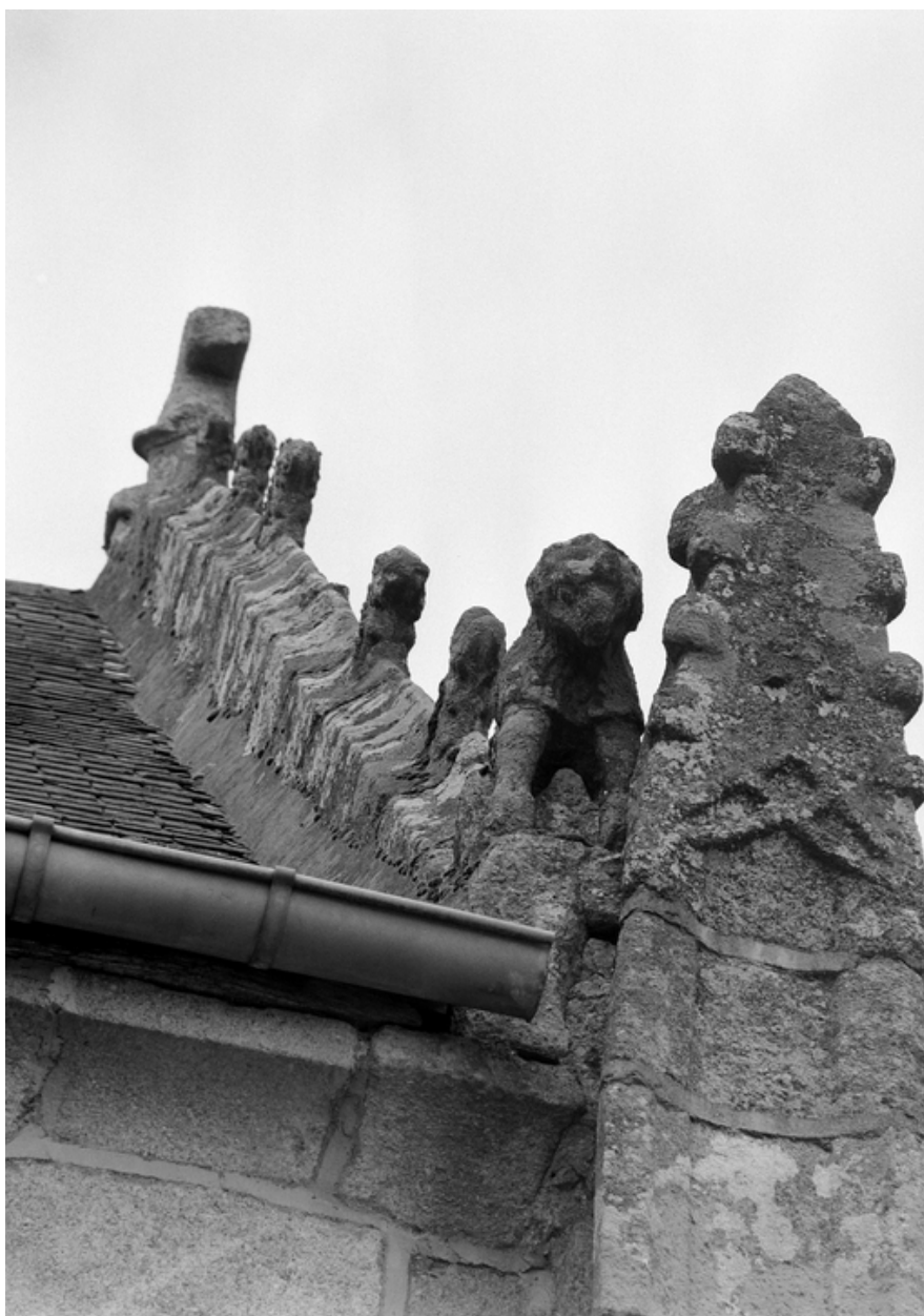
Chevet, pignon est : détail du corbeau sculpté du rampant sud
