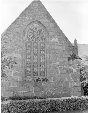
Transept, bras nord, 1ère chapelle ouest : fenêtre nord Phot. François Dagorn IVR53_19762200298X
