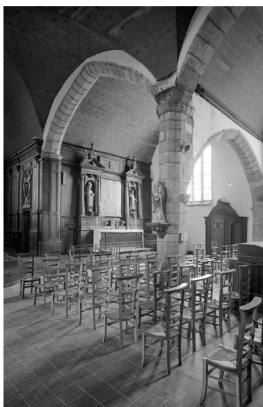
Croisillons sud : vue axiale nord ouest - sud est Phot. François Dagorn IVR53_19692200834V
