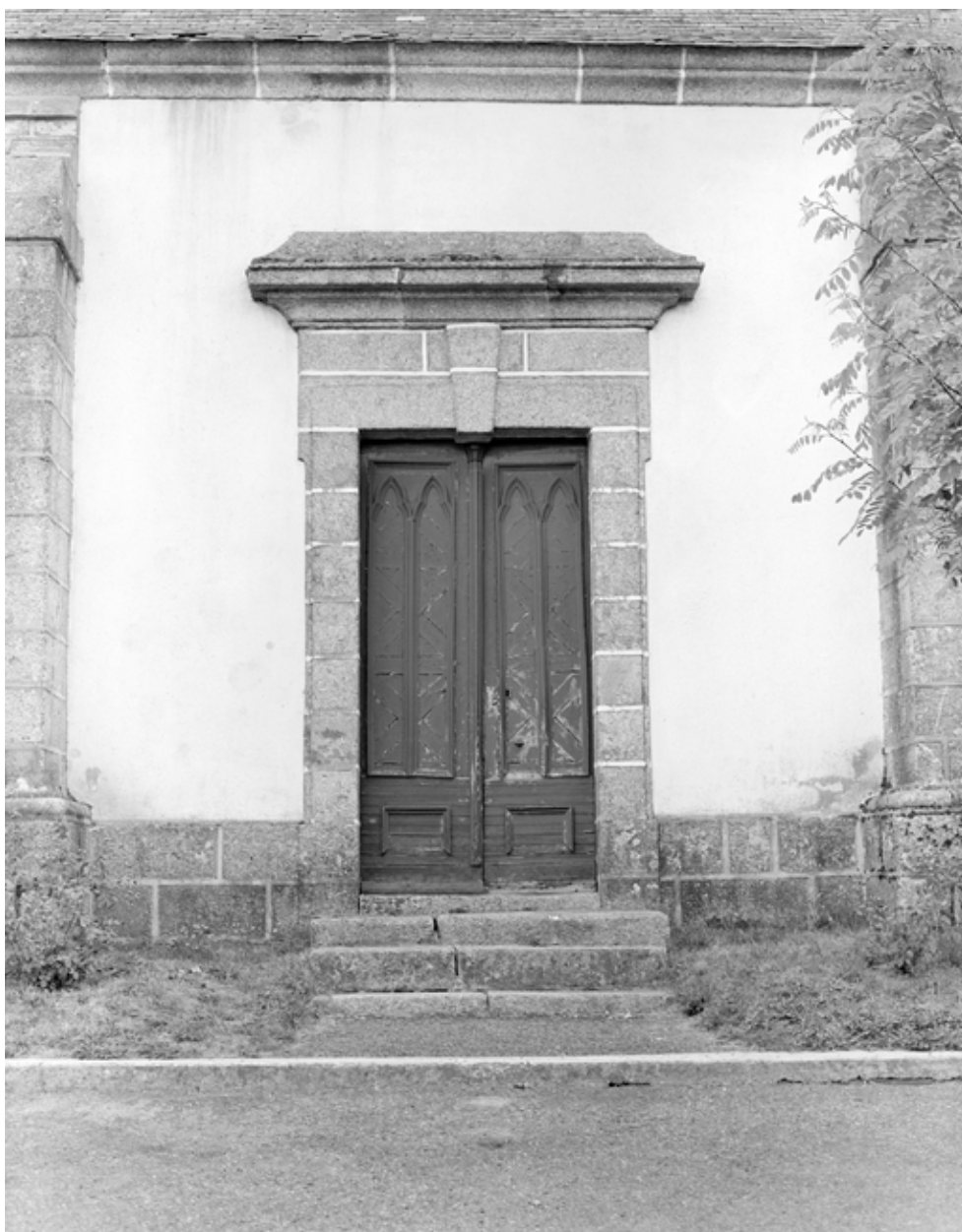
Nef, élévation sud : porte d'accès
