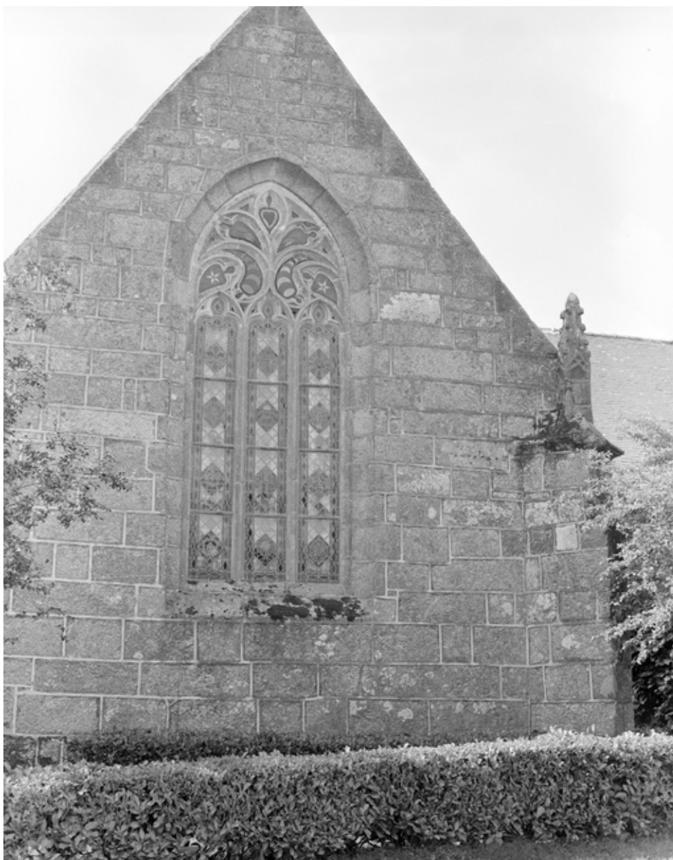
Transept, bras nord, 1ère chapelle ouest : fenêtre nord
