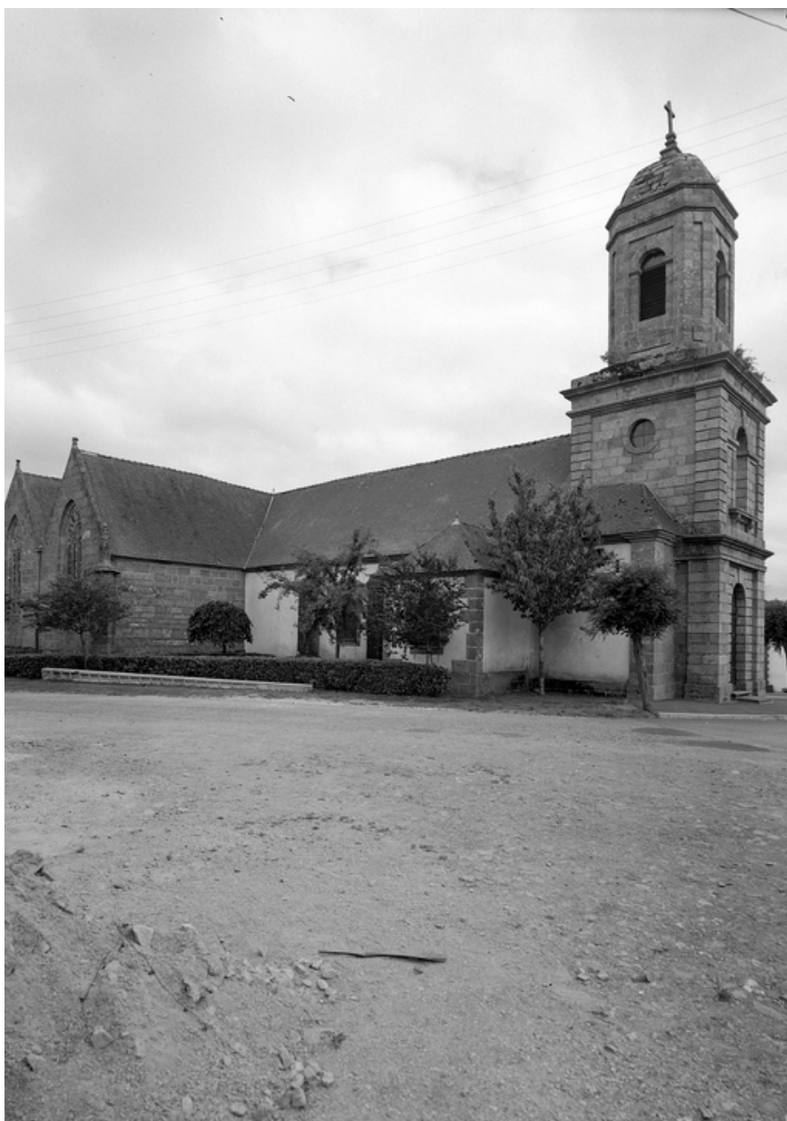
Vue de situation prise du nord est
