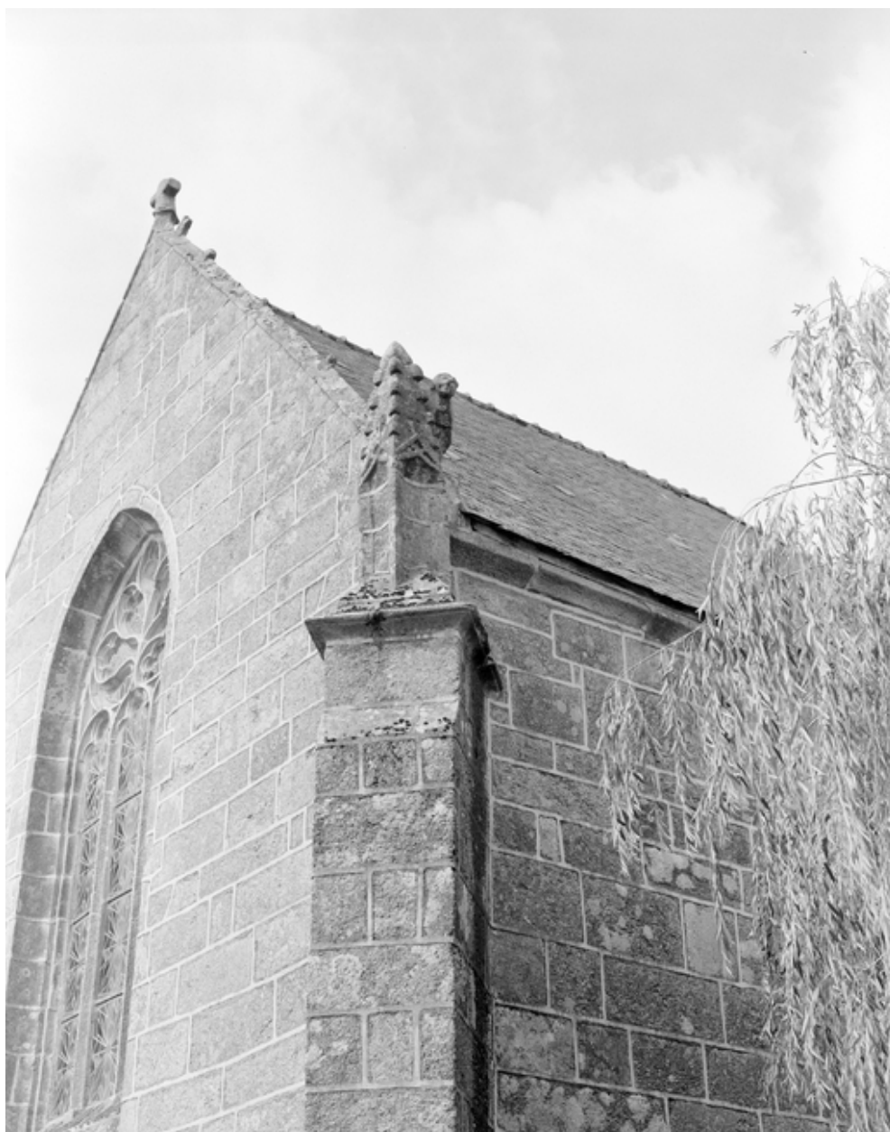
Choeur, mur est : détail de la crossette sculptée à la base du rampant nord
