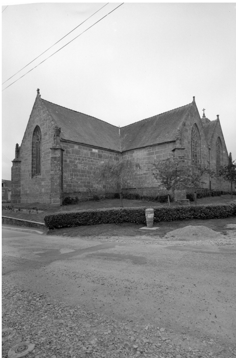
Façades nord et est : angle du chevet et des croisillons nord
