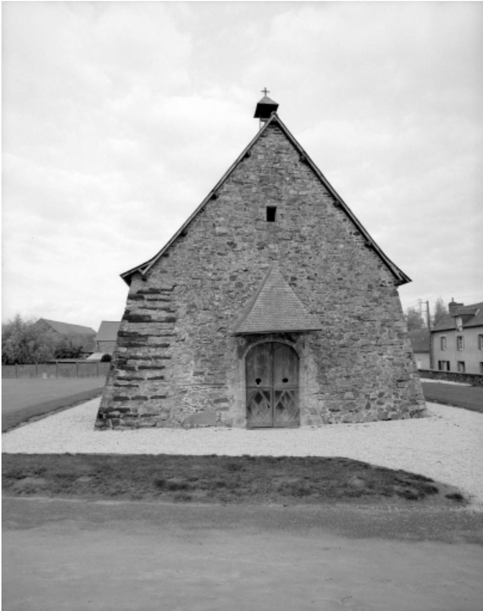
Elévation Ouest : vue générale
