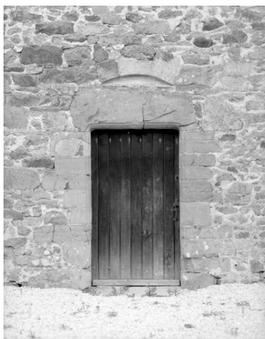
Elévation Sud, porte : vue générale Phot. Bernard Bègne, Phot. M. Loyon IVR53_19923500893X
