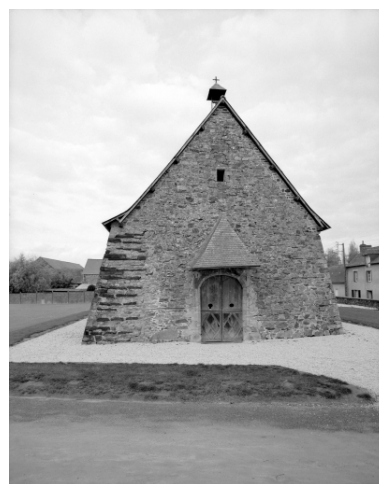
Elévation Ouest : vue générale Phot. Bernard Bègne, Phot. M. Loyon IVR53_19923500890X
