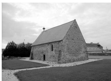
Elévation Sud-Est : vue générale Phot. Bernard Bègne, Phot. M. Loyon IVR53_19923500888X
