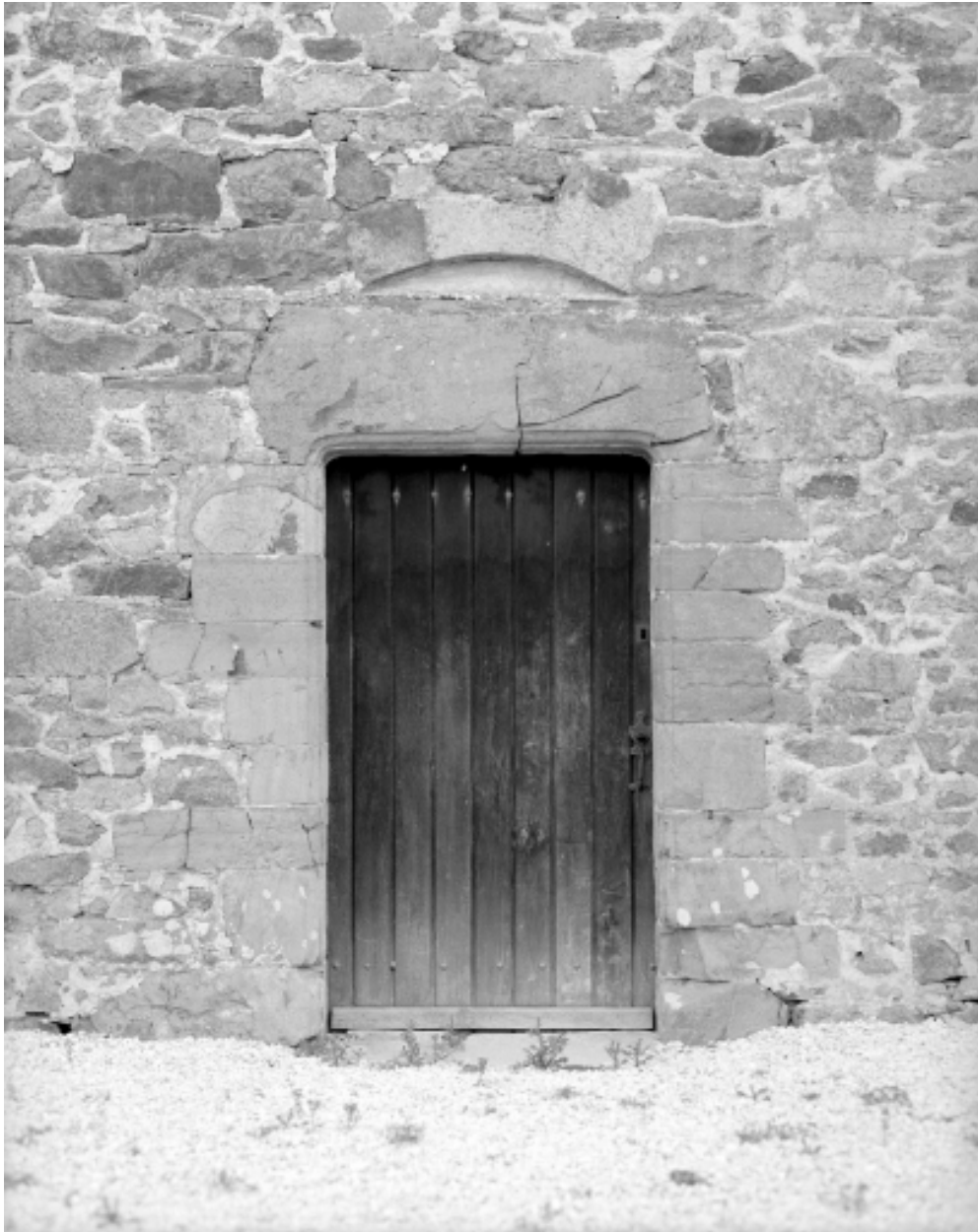
Elévation Sud, porte : vue générale
