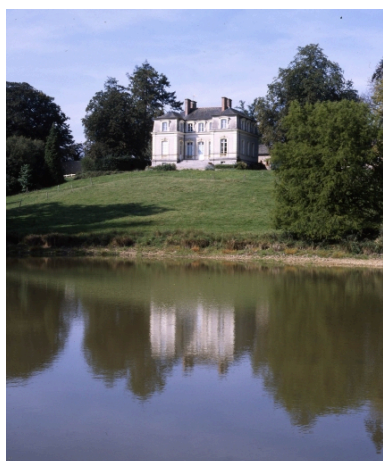
Vue générale est Phot. Guy Artur, Phot. Norbert Lambart IVR53_19973500959XA
