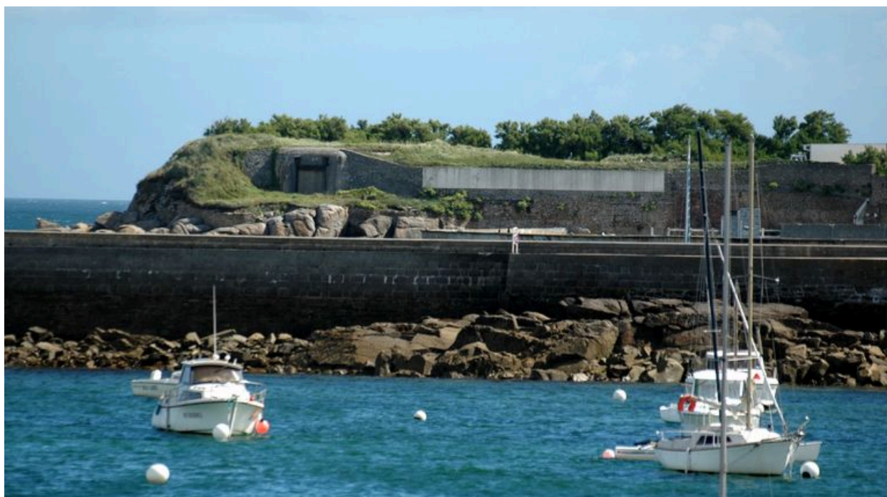
Vue de l'extrémité nord du Fort Blosson : bunker - casemate de type 611 flanqué de murs en maçonnerie de moellon de granite (état en 2004). Au premier plan, la digue des viviers
