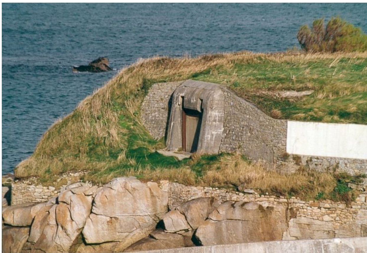
Vue du bunker - casemate de type 611 flanqué de murs en maçonnerie de moellon de granite (état en 2002)
