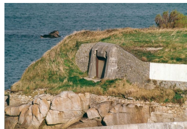
Vue du bunker - casemate de type 611 flanqué de murs en maçonnerie de moellon de granite (état en 2002) Phot. Guillaume Lécueillier IVR53_20022901525NUCA
