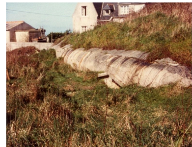
Vue d'un bunker - abri de type 661 SK Phot. Olivier Dohér IVR53_20232905364NUCA
