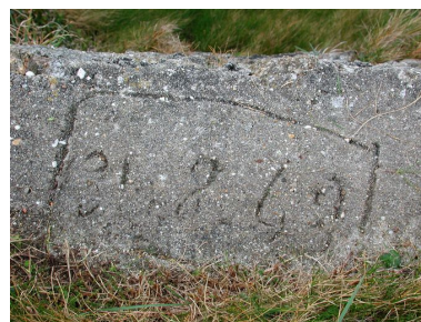
Vue d'un millésime tracé dans le béton frais : 31-8-43 situé près du bunker - casemate de type 611 du Fort Blosson (état en 2004) Phot. Guillaume Lécueillier IVR53_20042903922NUCA
