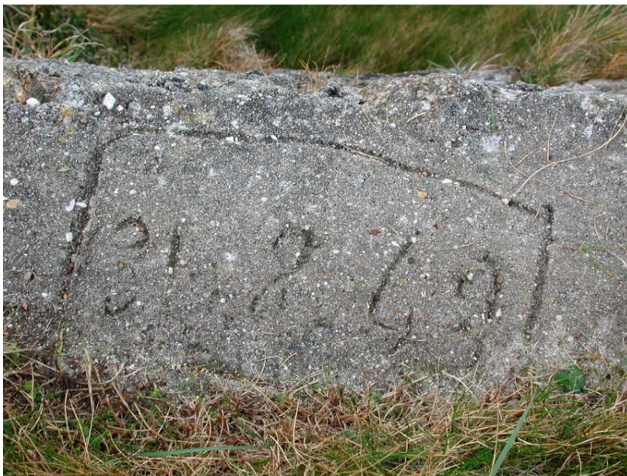
Vue d'un millésime tracé dans le béton frais : 31-8-43 situé près du bunker - casemate de type 611 du Fort Blosson (état en 2004)
