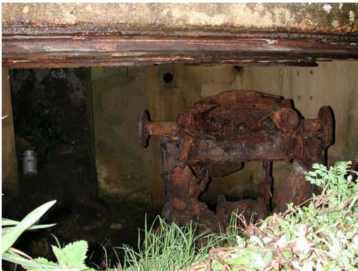
Vue du canon antichar de 5 cm KwK L/39 dans son bunker - casemate de type 667 orienté vers le nord-est (état en 2003). Le canon a été saboté en août 1944
