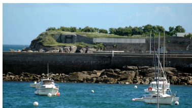
Vue de l'extrémité nord du Fort Blosson : bunker - casemate de type 611 flanqué de murs en maçonnerie de moellon de granite (état en 2004). Au premier plan, la digue des viviers Phot. Guillaume Lécueillier IVR53_20042903920NUCA
