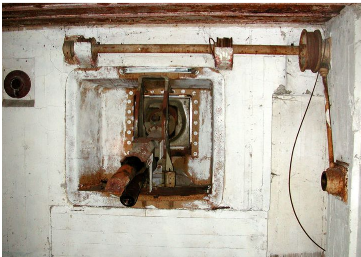
Vue du canon antichar de 4,7 cm Skoda d'origine tchèque dans son bunker casemate de type 631 (état en 2004). Le canon a été saboté en août 1944
