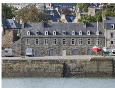
Tréguier, rue du Port : maison d'armateur ou de négociant (11 rue du Port) Phot. Bernard Bègne IVR53_20202200520NUCA
