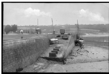
Tréguier : cale du port à marée basse et bateaux de travail (Archives départementales des Côtes-d'Armor, collection photographique Lacombe : FRAD022_19Fi506_539) Phot. Archives départementales des Côtes-d'Armor, Autr. Lacombe IVR53_20182205718NUCA
