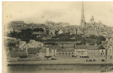
Tréguier : front portuaire de la ville, carte postale (Archives départementales des Côtes-d'Armor : FRAD022_16F16568_6534) Phot. Archives départementales des Côtes-d'Armor IVR53_20182205715NUCA
