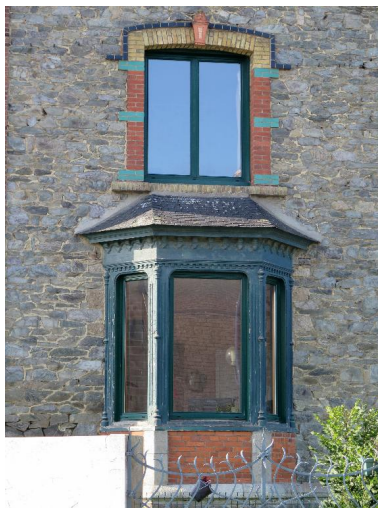
Tréguier, 11 rue Marcelin Berthelot : maison, élévation est sur rue, détail de l'une des fenêtres avec un décor de brique émaillée colorée et fenêtre en saillie dite bow-window au niveau du rez-de-chaussée Phot. Guillaume Lécueillier IVR53_20182205785NUCA
