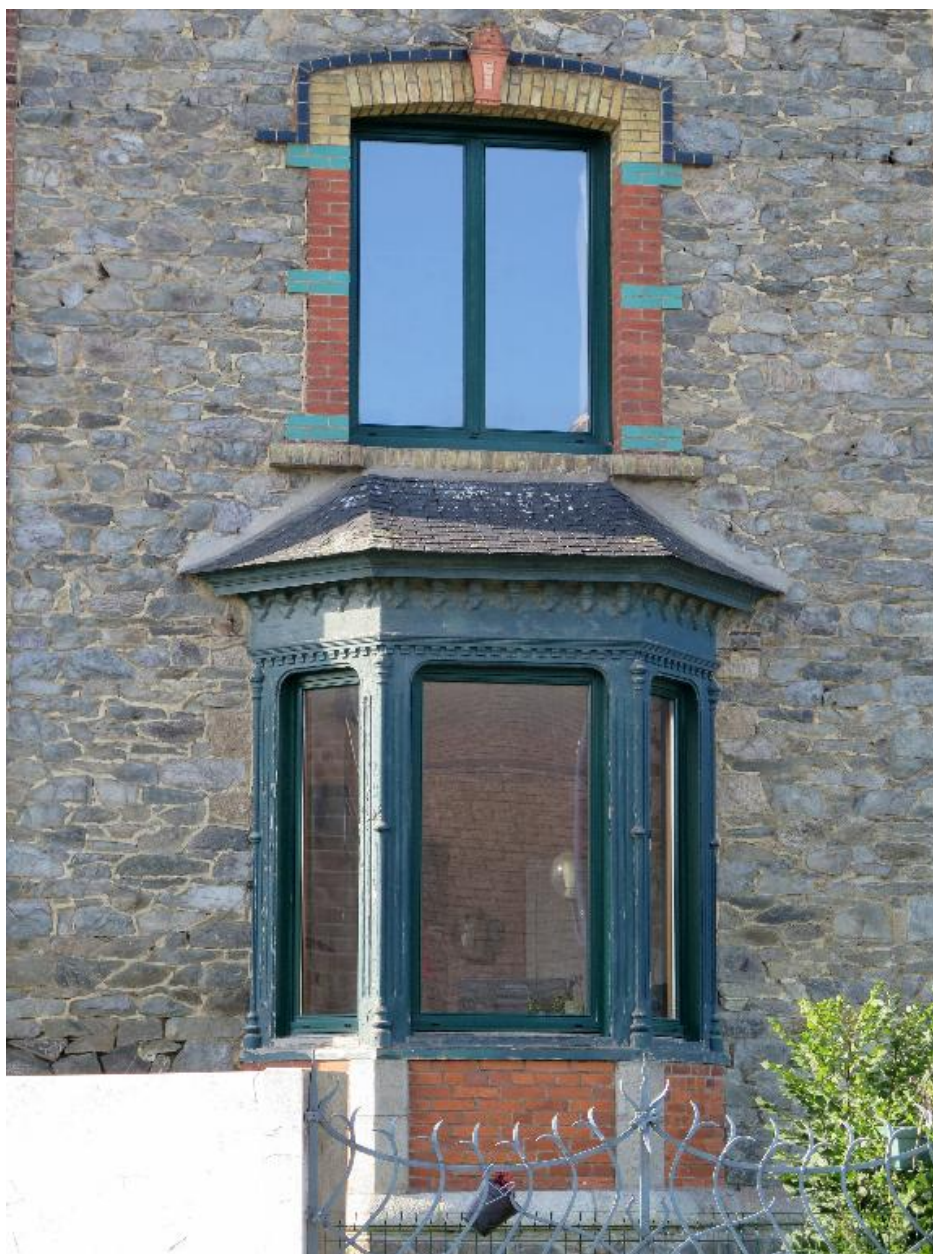
Tréguier, 11 rue Marcelin Berthelot : maison, élévation est sur rue, détail de l'une des fenêtres avec un décor de brique émaillée colorée et fenêtre en saillie dite bow-window au niveau du rez-de-chaussée
