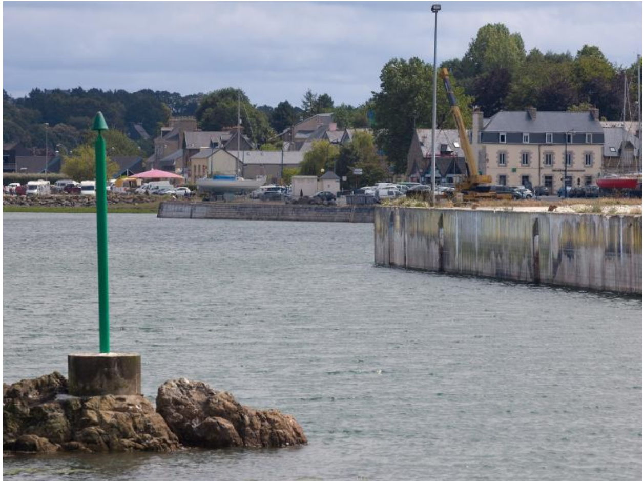
Tréguier : Balise du tas de Fumier. En arrière plan à droite, quai sud (poste n° 5) du port de commerce
