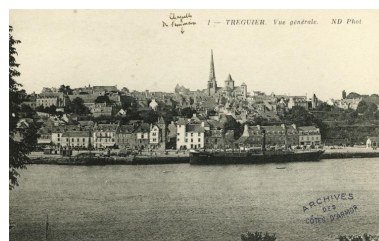
Tréguier : front portuaire de la ville, carte postale (Archives départementales des Côtes-d'Armor : FRAD022_16FI6534_6500) Phot. Archives départementales des Côtes-d'Armor IVR53_20182205713NUCA
