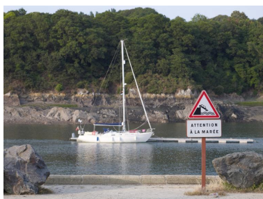
Tréguier : ponton flottant. Au premier plan, le quai
