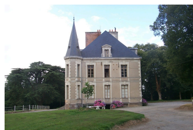
Le pignon est : vue générale Phot. Xavier Gilbert IVR53_19993503751NUCA
