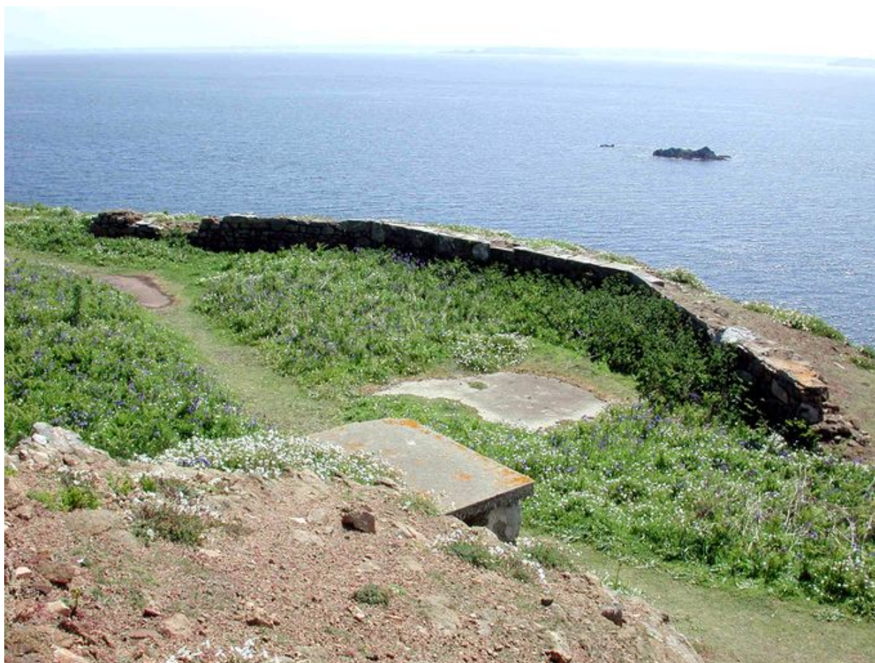
Vue générale (état en 2002). Au premier plan, la dalle de couverture en béton armé de la niche à munitions
