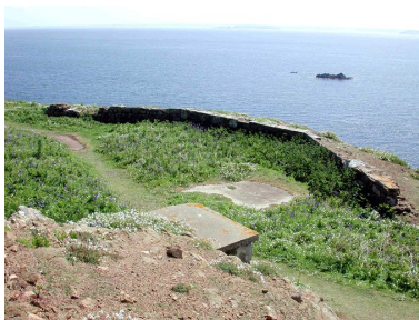
Vue générale (état en 2002). Au premier plan, la dalle de couverture en béton armé de la niche à munitions Phot. Guillaume Lécueillier IVR53_20022202519NUCA
