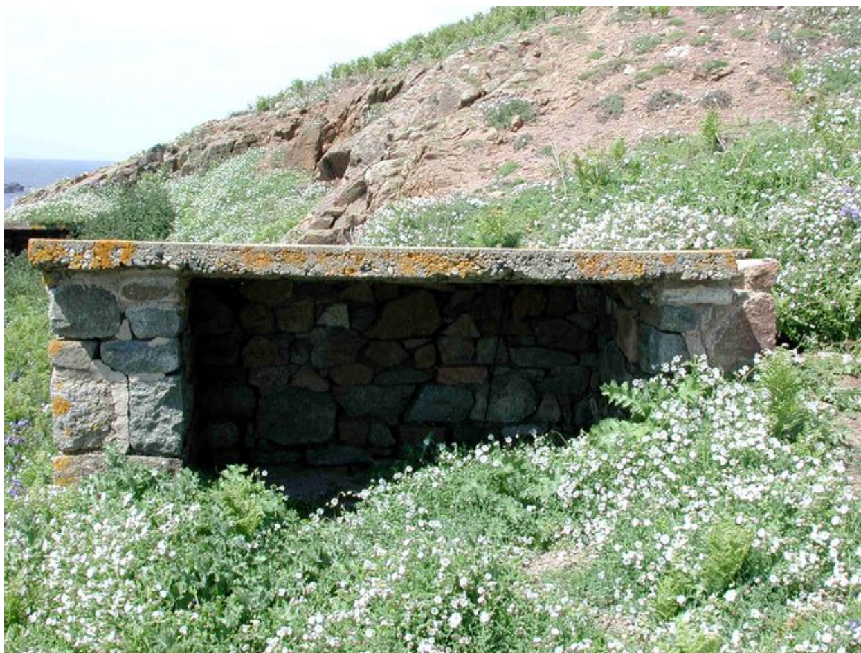
Vue de la niche à munitions (état en 2002)
