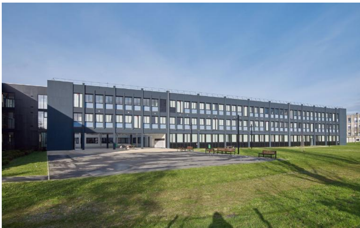
Façade sud de l'externat, Roger Besnard, architecte, 1973, restructuration, Pierre Brulé, architecte, 2021.
