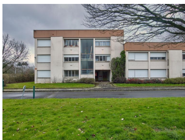
Façade est des logements de fonction : détail sur la partie sud. Roger Besnard, architecte, 1973-1974. Phot. Bernard Bègne IVR53_20233500132NUCA
