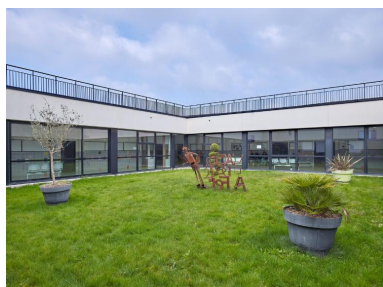
Vue d'ensemble du patio entre les ateliers et le l'externat (bâtiment D) et de sa sculpture métallique. Phot. Bernard Bègne IVR53_20233500068NUCA
