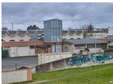
Ateliers : détail sur la façade est et le silo. Phot. Bernard Bègne IVR53_20233500130NUCA
