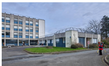
Façade ouest de l'aile sud de l'internat et vue d'ensemble de l'infirmerie. Roger Besnard, architecte, 1973. Phot. Bernard Bègne IVR53_20233500038NUCA
