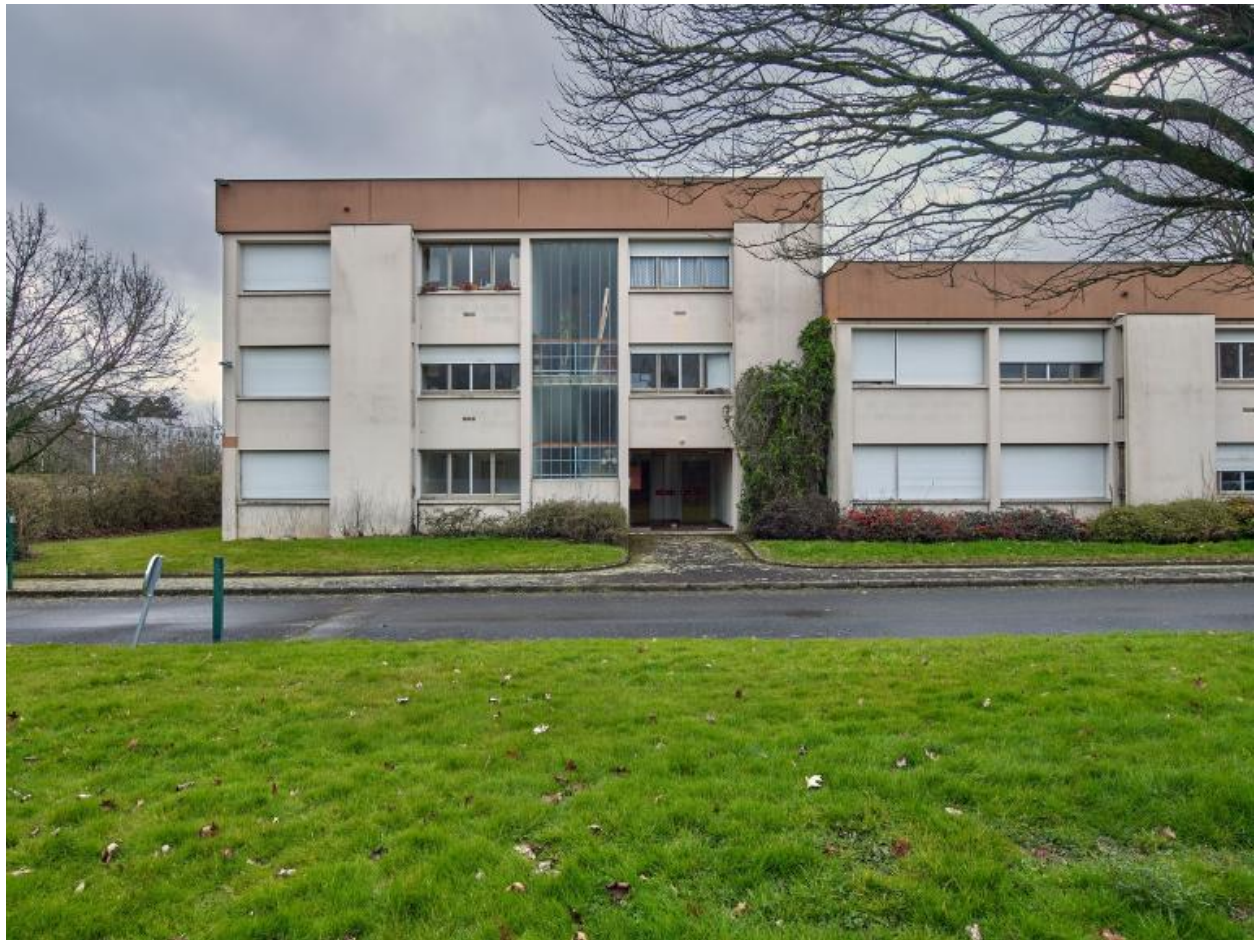
Façade est des logements de fonction : détail sur la partie sud. Roger Besnard, architecte, 1973-1974.
