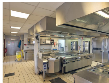
Vue intérieure d'ensemble des cuisines. Phot. Bernard Bègne IVR53_20233500125NUCA
