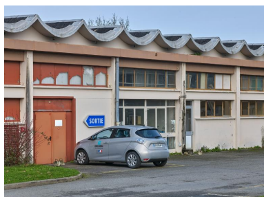
Façade sud de l'ancien atelier conducteurs d'engins (bâtiment E). Roger Besnard, architecte, 1973. Noter l'originalité du dessin de la toiture, "orientalisant", qui rappelle celui des ateliers principaux. Phot. Bernard Bègne IVR53_20233500022NUCA
