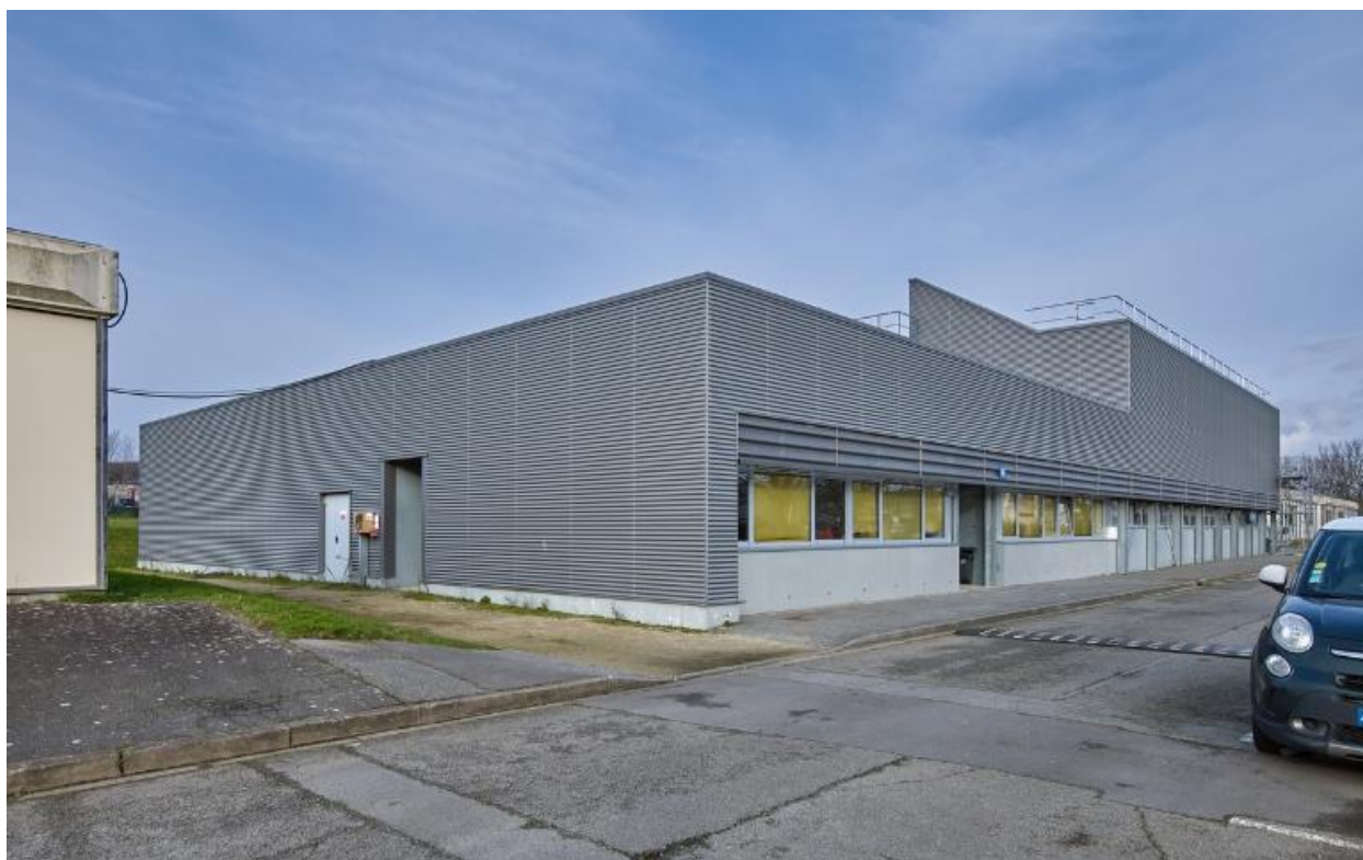
Vue d'ensemble prise du sud-ouest de l'atelier pédagogique (bâtiment N).
