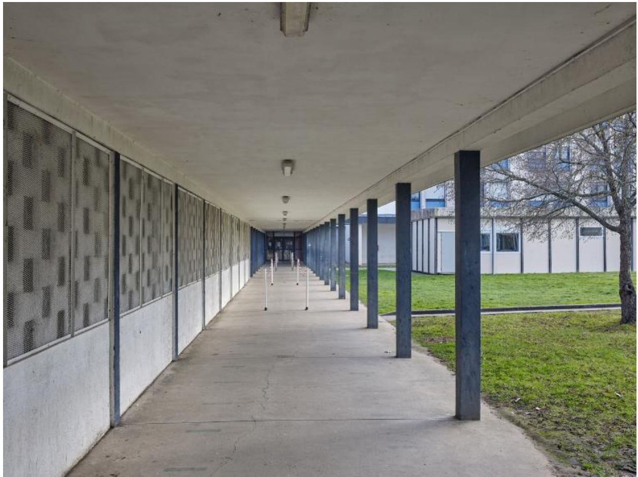
Vue d'ensemble axiale de la galerie de circulation couverte reliant les ateliers à la restauration et aux internats. Noter le mur ajourée côté nord. Roger Besnard, architecte, 1973.
