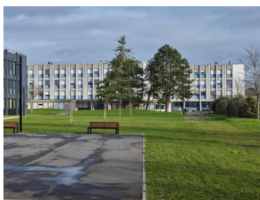
Vue d'ensemble prise de l'ouest. A gauche, façade sud de l'externat, à l'arrière plan façade ouest de l'internat. Phot. Bernard Bègne IVR53_20233500032NUCA
