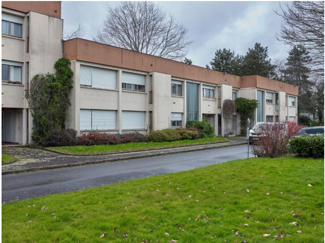
Façade est des logements de fonction : détail sur la partie nord. Roger Besnard, architecte, 1973-1974.
