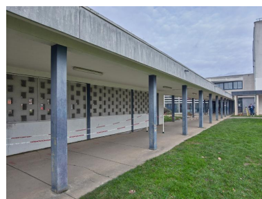
Galerie de circulation entre les ateliers et la restauration scolaire. C'est un élément important de l'axe structurant du lycée. Noter le mur pour protéger des vents du nord,
