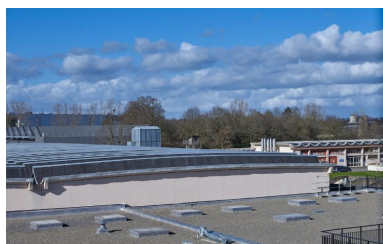
Ateliers : vue d'ensemble de la toiture. Au premier plan, les skydomes du bâtiment de liaison entre ateliers et externat (D). A droite, façade sud des anciens ateliers conducteurs d'engins. Roger Besnard, architecte, 1973. Phot. Bernard Bègne IVR53_20233500149NUCA
