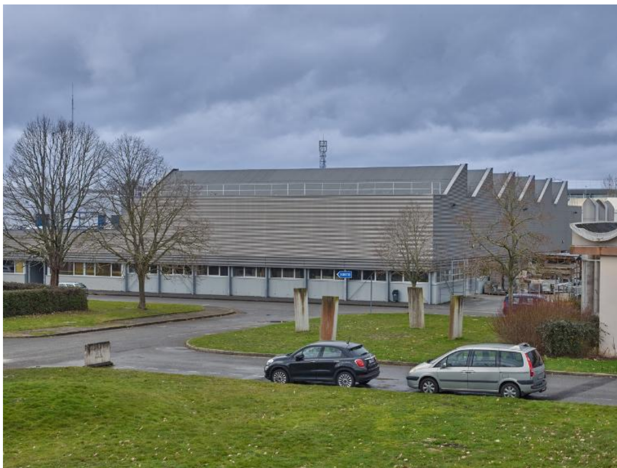
Ateliers pédagogiques (bâtiment N), vue d'ensemble prise du sud-est.
