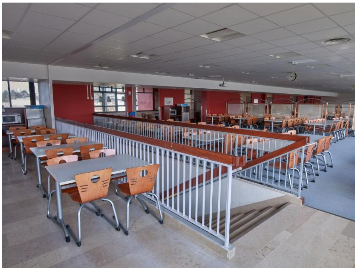
Vue d'ensemble du réfectoire et de l'escalier d'origine.
