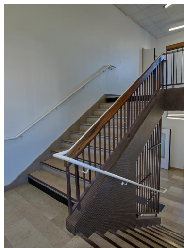
Cage d'escalier dans l'externat (bâtiment D). Roger Besnard, architecte, 1973. Phot. Bernard Bègne IVR53_20233500115NUCA
