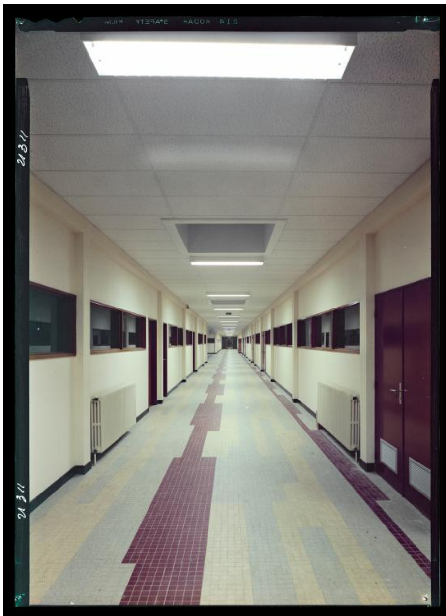
Dégagement et axe de distribution principal (1973).
