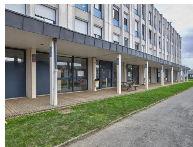
Façade ouest de l'internat, à la trame porteuse très affirmée (Roger Besnard, architecte, 1973), précédée d'une galerie ajoutée ultérieurement. Phot. Bernard Bègne IVR53_20233500035NUCA
