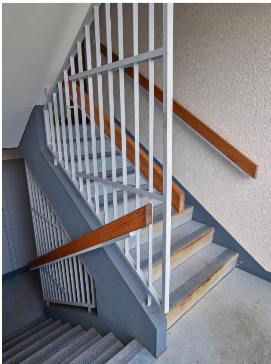
Cage d'escalier du 'bloc' sud des logements de fonction. Roger Besnard, architecte, 1973-1974.
