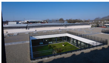
Vue d'ensemble prise du toit, du patio entre les ateliers et le l'externat (bâtiment D). A l'arrière plan, toiture des ateliers. Roger Besnard, architecte, 1973. Phot. Bernard Bègne IVR53_20233500067NUCA
