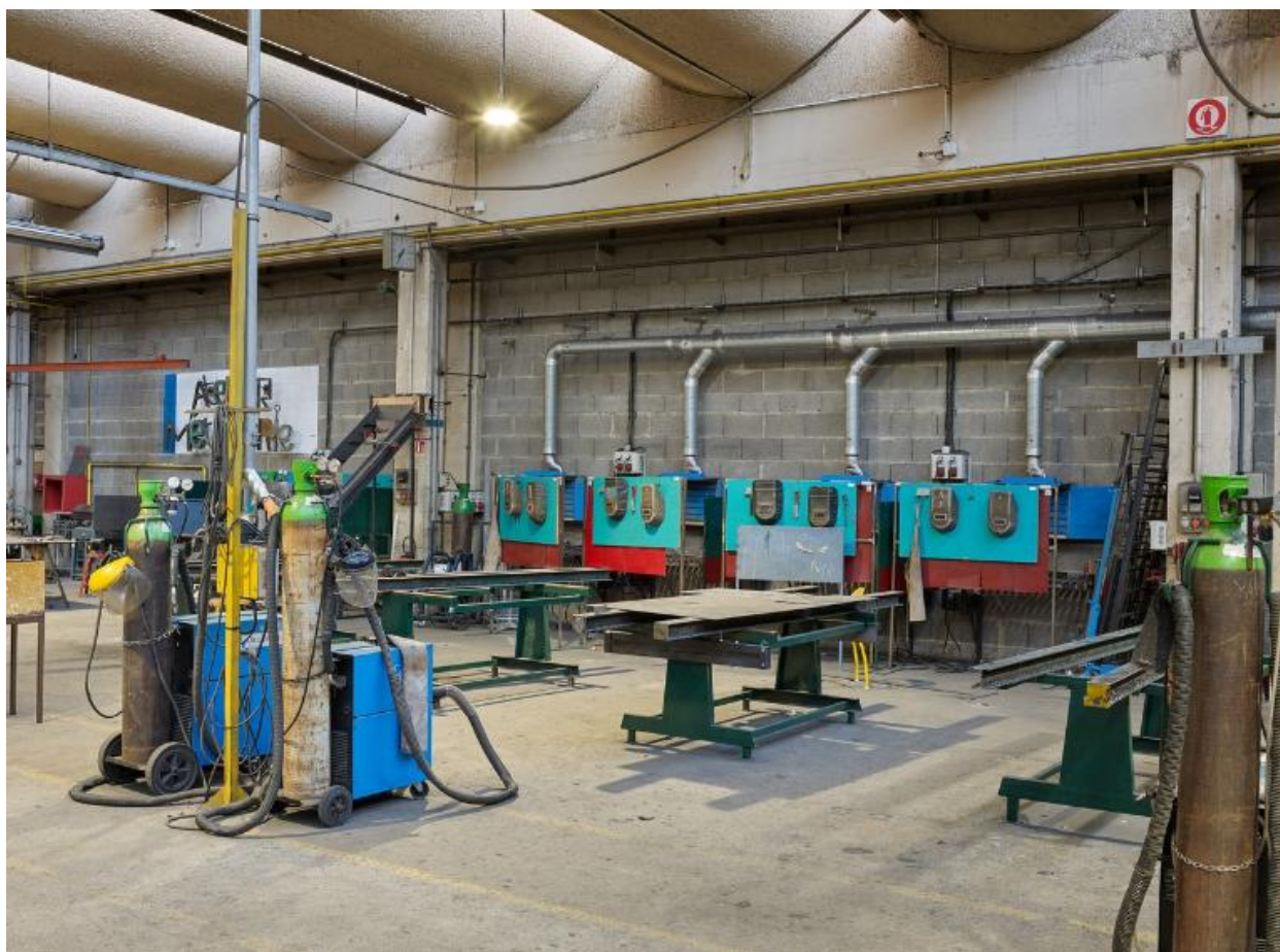
Vue intérieure des ateliers : soudure.
