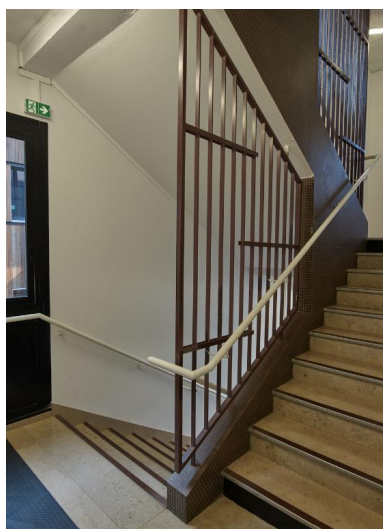
Cage d'escalier dans l'externat (bâtiment D). Roger Besnard, architecte, 1973. Phot. Bernard Bègne IVR53_20233500114NUCA
