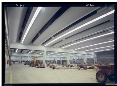
Vue intérieure des ateliers en 1973. Phot. Bernard Heurtier IVR53_20233505017NUCA
