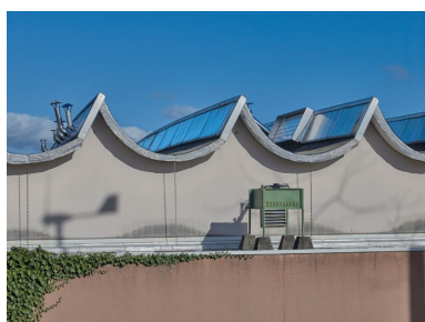
Ateliers : détail de la toiture. Roger Besnard, architecte, 1973. Phot. Bernard Bègne IVR53_20233500150NUCA
