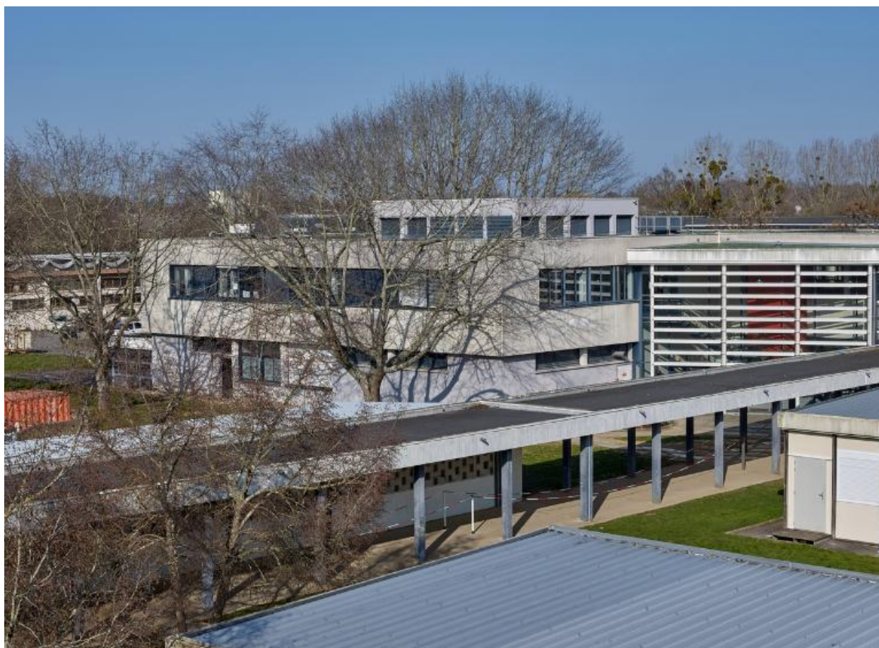
Vue d'ensemble de la restauration scolaire et de la galerie de circulation couverte, prise d'un étage du bâtiment D.
