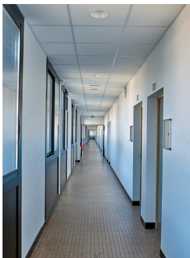
Couloir latéral situé au nord de l'externat. Roger Besnard, architecte, 1973, restructuration Pierre Brulé, architecte, 2021. Phot. Bernard Bègne IVR53_20233500113NUCA
