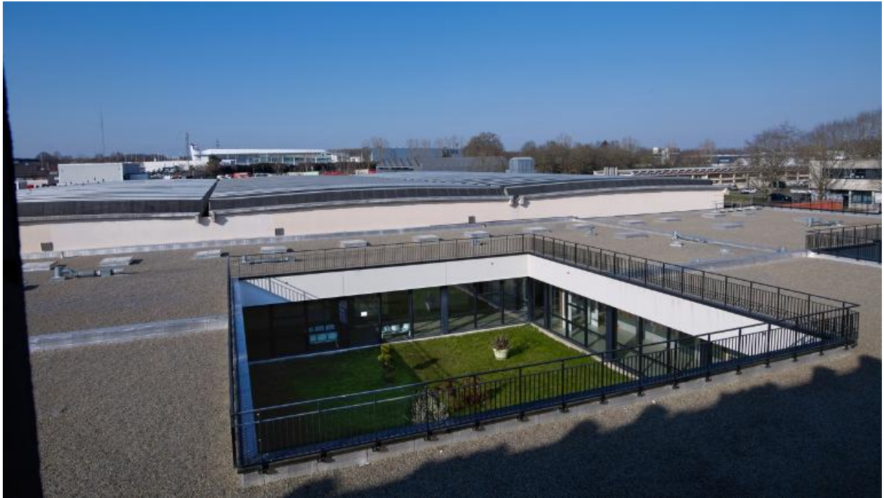
Vue d'ensemble prise du toit, du patio entre les ateliers et le l'externat (bâtiment D). A l'arrière plan, toiture des ateliers. Roger Besnard, architecte, 1973.
