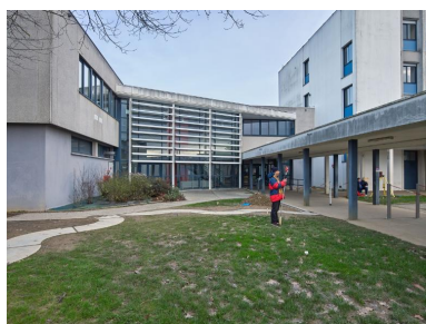
Jonction entre la restauration scolaire, l'internat et la galerie de circulation. Une restructuration a introduit de l'inox et une diagonale en rupture avec les élégants et très modernes bandeaux de fenêtres. Phot. Bernard Bègne IVR53_20233500036NUCA
