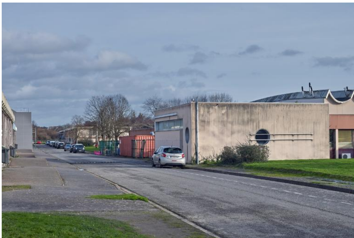
Labo acoustique, accolé à l'angle nord-ouest des ateliers principaux.
