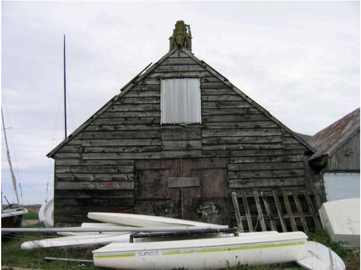
Vue générale de le Cabane Le Dé
