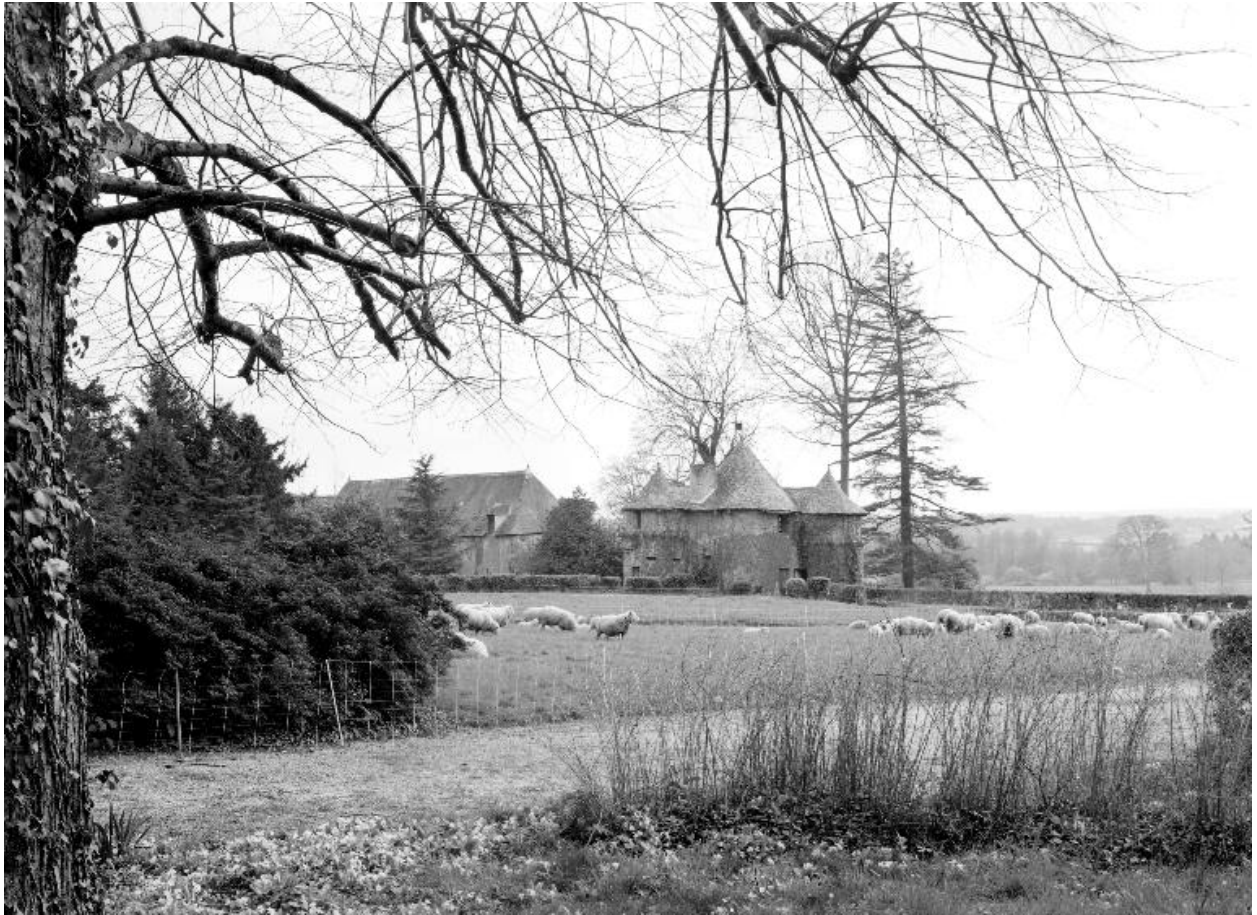
Château, tour sud-est, vue générale nord-ouest.
