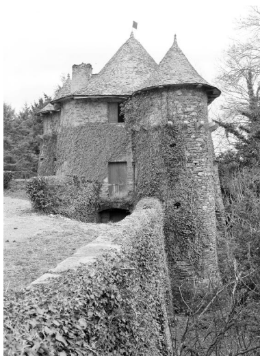
Château, tour sud-est, vue générale ouest. Phot. Norbert Lambart IVR53_19835600450V
