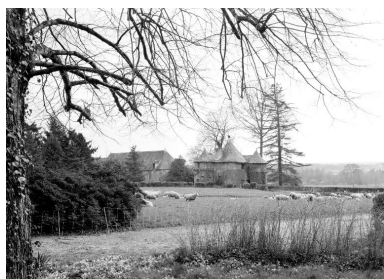
Château, tour sud-est, vue générale nord-ouest. Phot. Norbert Lambart IVR53_19835600449V
