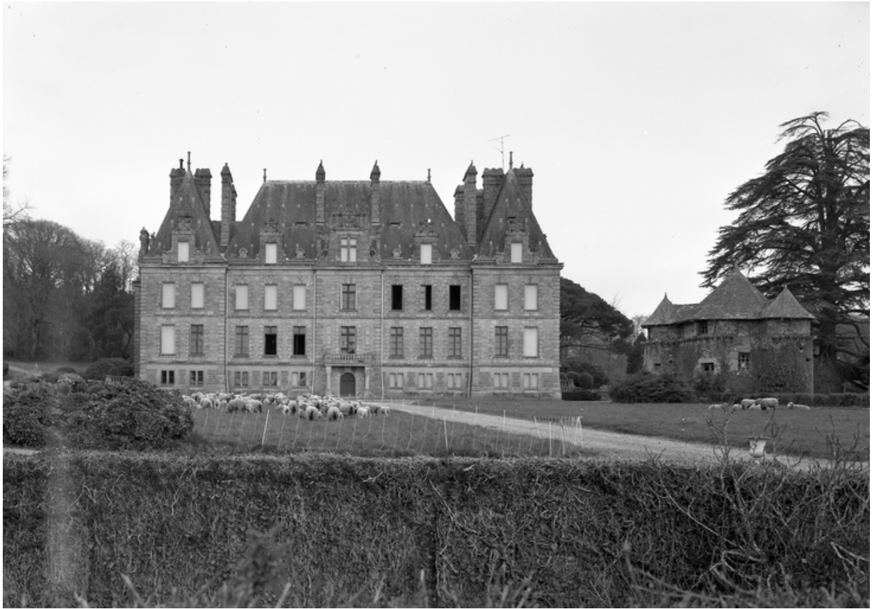
Logis, vue générale sud
