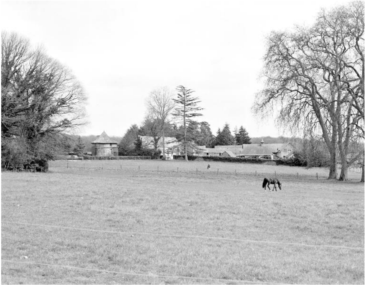
Château, tour sud-est, vue générale sud.
