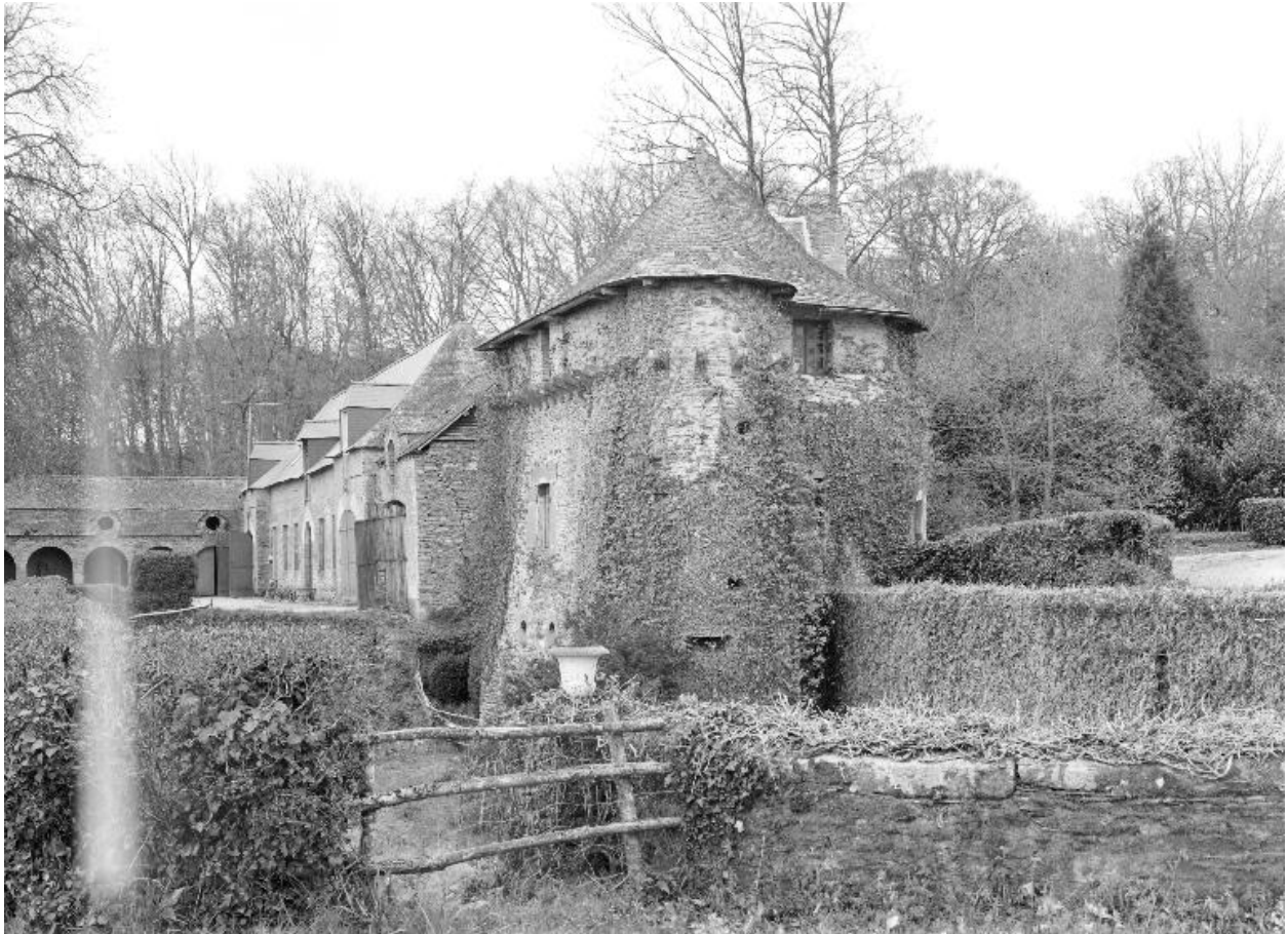
Château, tour sud-ouest, vue générale est.
