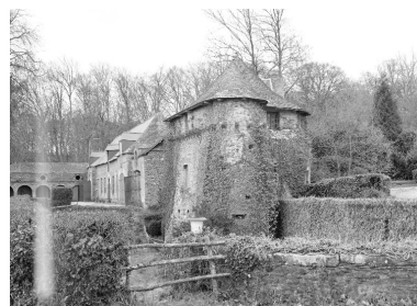
Château, tour sud-ouest, vue générale est. Phot. Norbert Lambart IVR53_19835600451V
