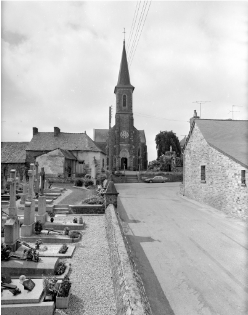
Vue générale prise du nord.
