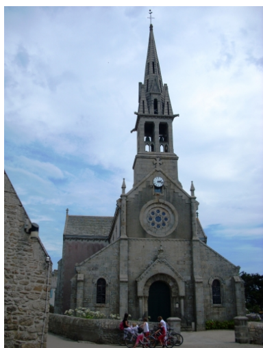
Ile de Batz, église paroissiale Notre-Dame : vue générale ouest Phot. Gwénaél Fauchille IVR53_20082906554NUCA
