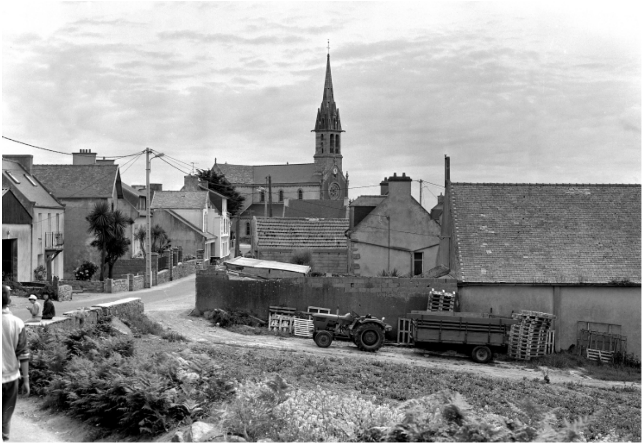
Ile de Batz, église paroissiale Notre-Dame : vue générale nord, état en 1986
