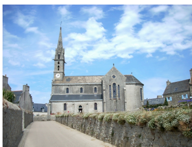
Ile de Batz, église paroissiale Notre-Dame : vue générale sud Phot. Gwénaél Fauchille IVR53_20082906555NUCA
