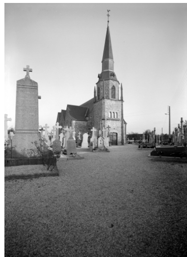
Elévation Sud-Ouest : vue générale Phot. François Dagorn IVR53_19723500698V
