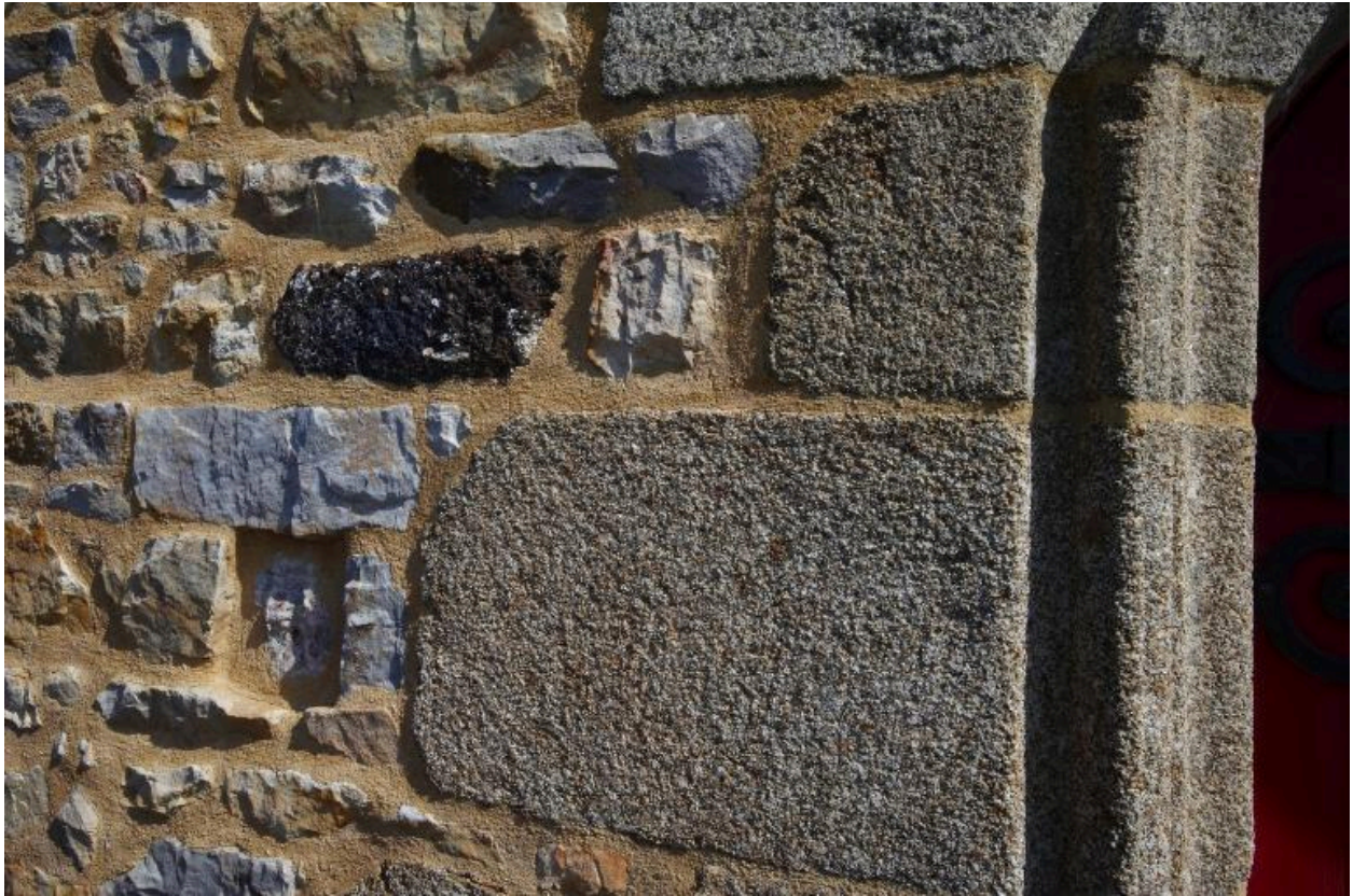
Détail de la maçonnerie
