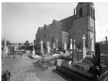
Elévation Nord : vue générale Phot. François Dagorn IVR53_19723500638V
