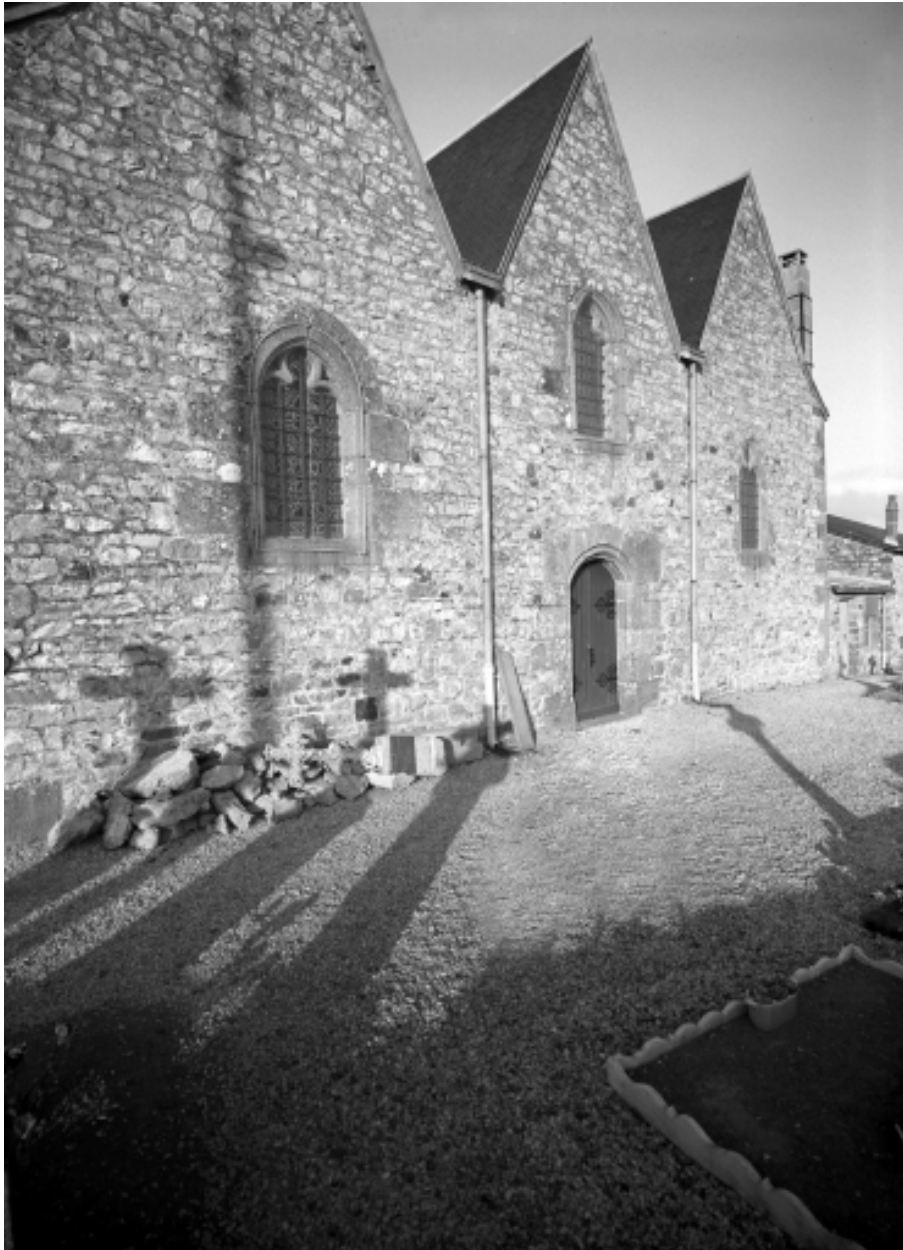
Elévation Sud, partie centrale : vue générale
