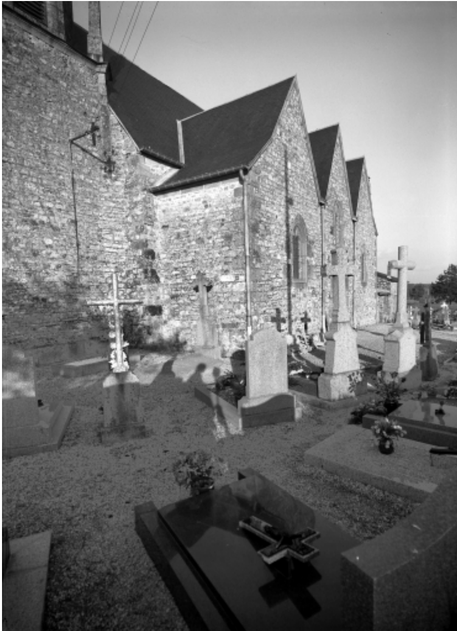
Elévation Sud, partie centrale : vue générale de 3/4
