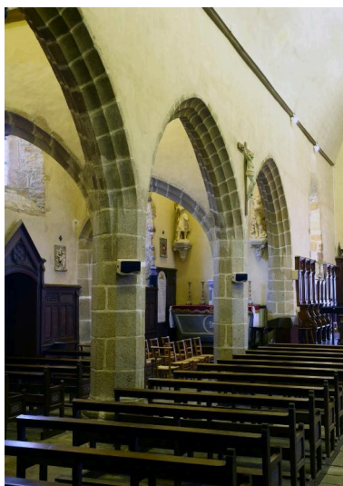
Intérieur : vue de la nef Phot. Norbert Lambart IVR53_20143501223NUCA
