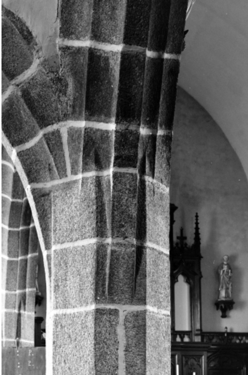
Pile 2 Nord, retombée des arcades.
