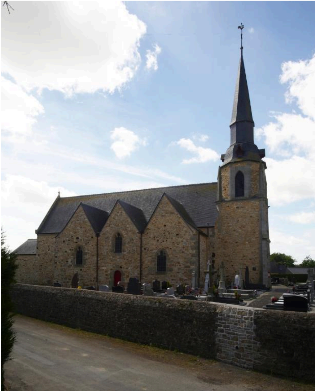
Vue générale nord
