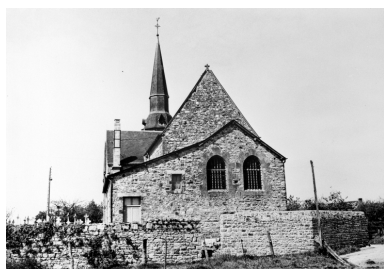
Elévation Est : vue générale Phot. Huart IVR53_19693500203V
