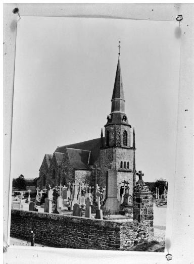
Elévation Nord- Ouest : vue de situation Phot. Huart IVR53_19693500201V
