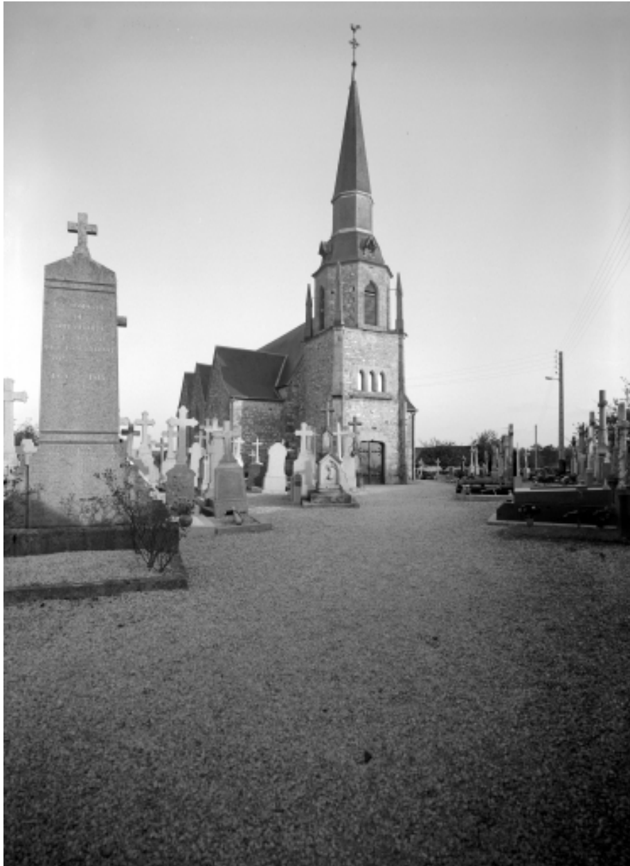
Elévation Sud-Ouest : vue générale
