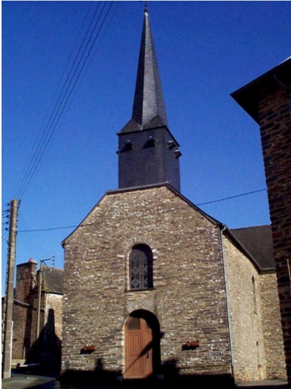
Le clocher : vue générale sud-ouest
