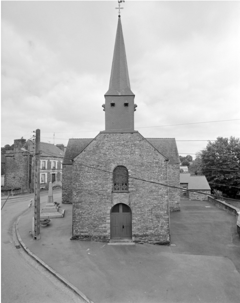
Le clocher : vue générale sud-ouest
